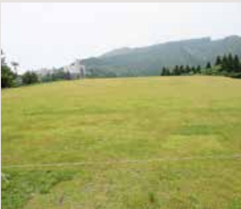
草地拡大工事(ビジターセンター前)
