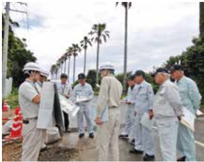
R元.5.29 (国道448号舳トンネル 藤工区)
