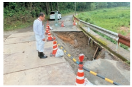
先日の豪雨によって陥没した道路を視察する様子
