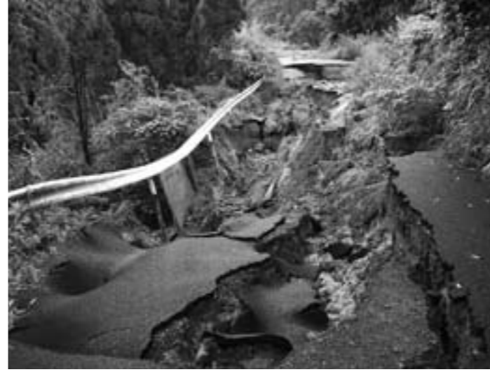
平成18年7月の集中豪雨による被害(大東地区・三ヶ平～三幸ヶ野間)
