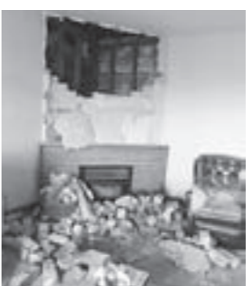
地震で壊れた実家のリビング。
