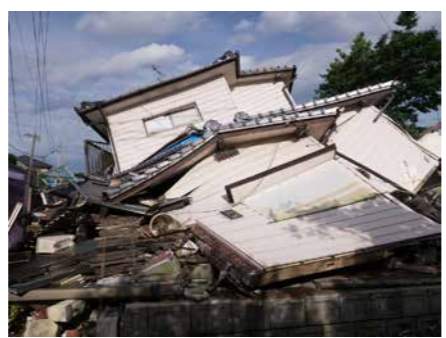
熊本地震被災状況
