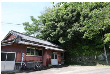
作業開始前の状況です
