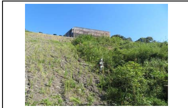
写真6 盛土側方境界部の状況
