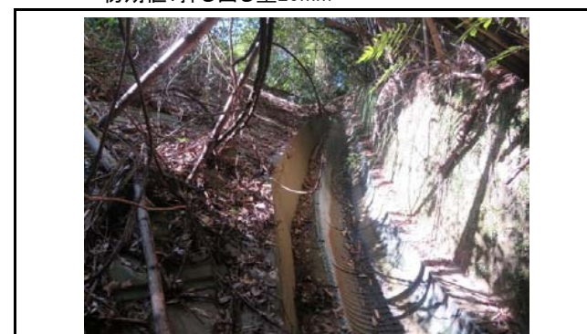
写真23 盛土のり面縦排水の状況(変状なし)
