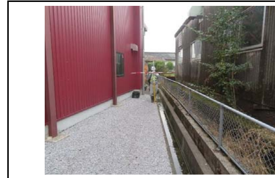
写真3 盛土側方境界部の状況(変状なし)
