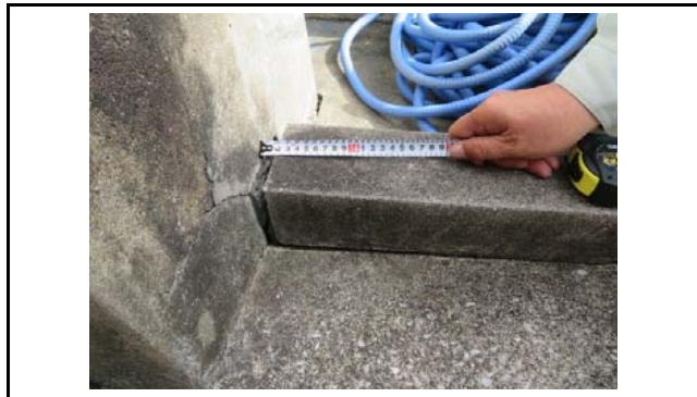
写真9 盛土側方境界部の状況 コンクリートたきの沈下による開口(初期値:開口15mm)
