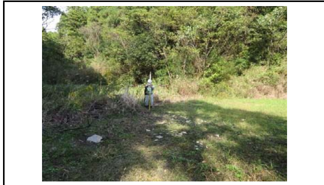
写真1 盛土頭部の状況(変状なし)
