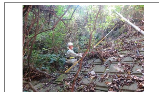
写真14 盛土のり面の状況 張りブロックの崩壊状況
