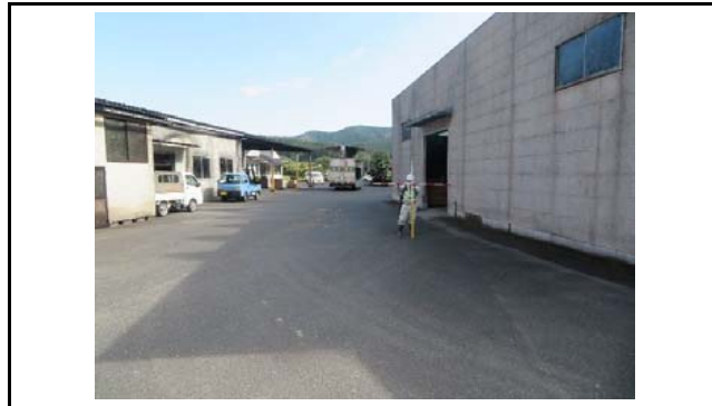
写真6 盛土内の状況(変状なし)
