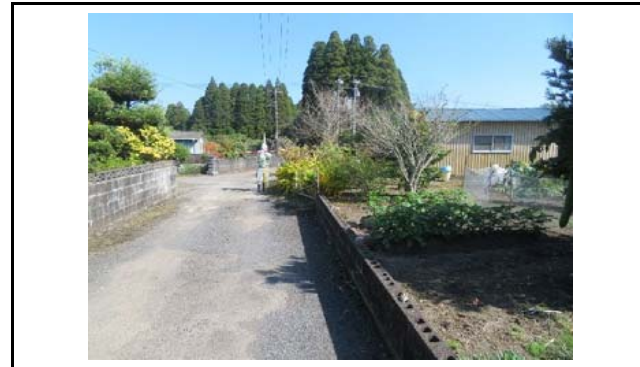
写真6 盛土側方境界部の状況(変状なし)
