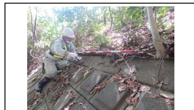
写真19 のり面小段の押し出し状況 初期値:押し出し量20mm
