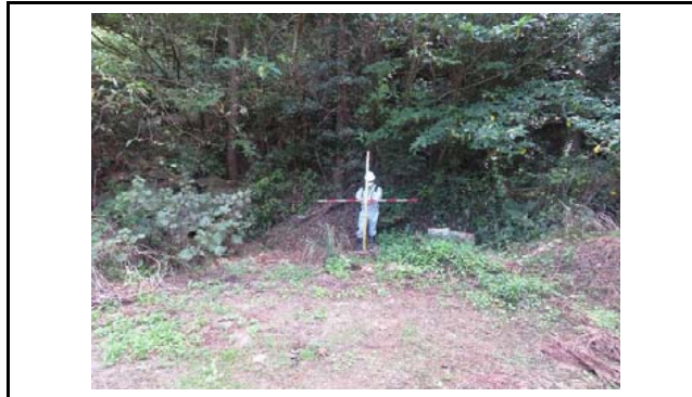
写真1 盛土頭部の状況(変状なし)
