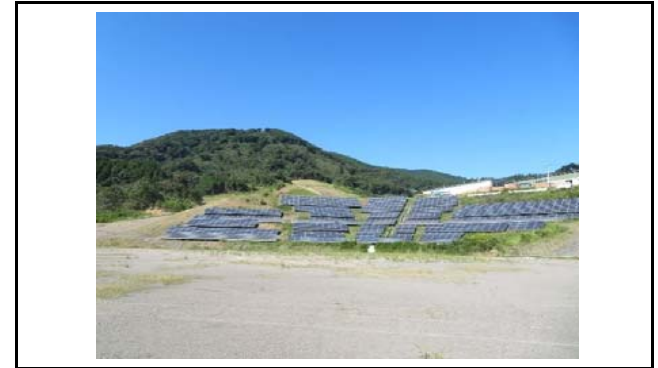
写真4 盛土末端部状況
