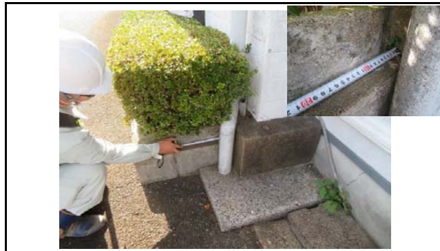
写真10 盛土側方境界部の状況 花壇コンクリートの沈下による開口(初期値:開口30mm)
