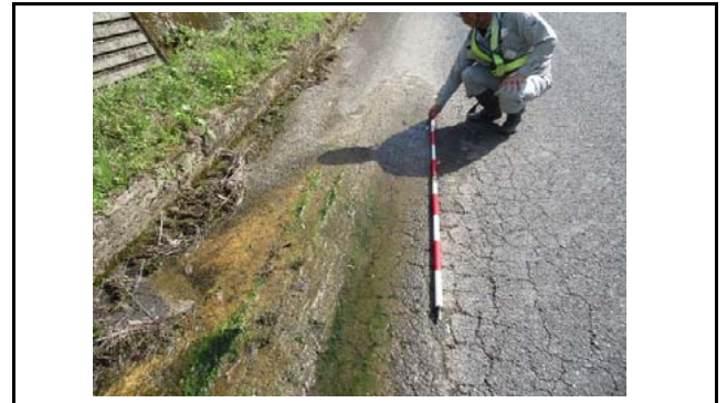
写真8 路面からの湧水状況(広域農道黒潮ロード) 地下水または道路埋設物?の影響なのか不明
