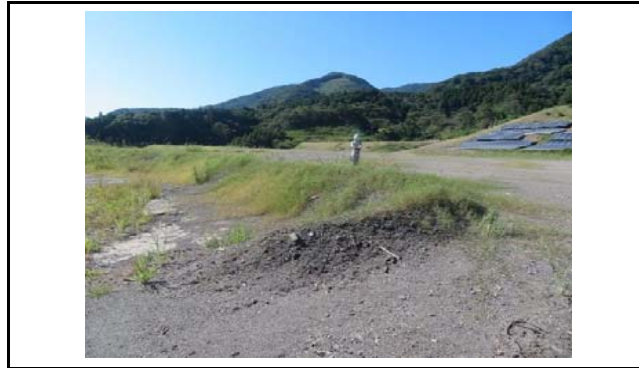
写真2 盛土内の状況
