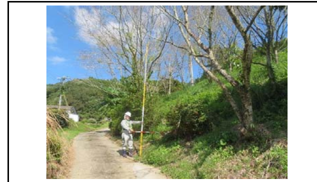
写真7 盛土のり面の状況(変状なし)
