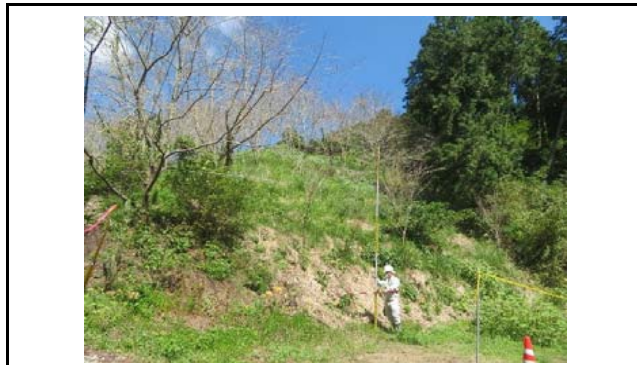
写真9 盛土のり面の状況 のり面下方部で肌落ちが見られる
