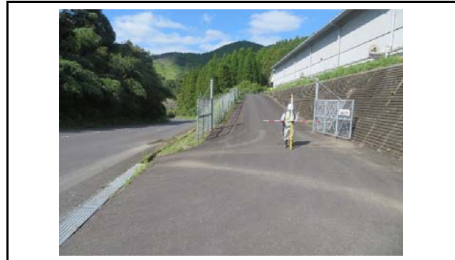
写真11 盛土側方境界部の状況(変状なし)
