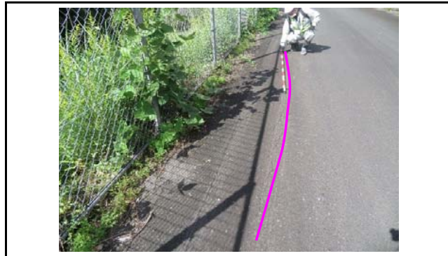
写真6 末端盛土のり面上端部のクラック状況
