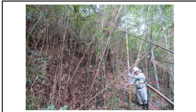
写真5 盛土のり面の状況(変状なし)
