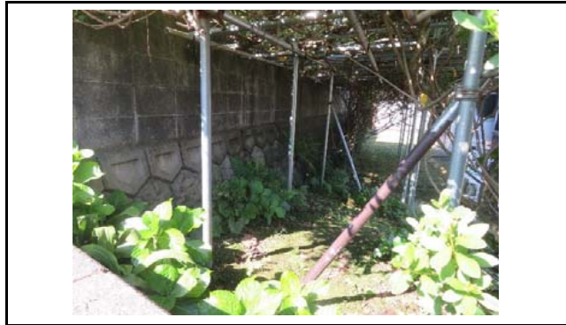
写真1 盛土頭部の状況(変状なし)
