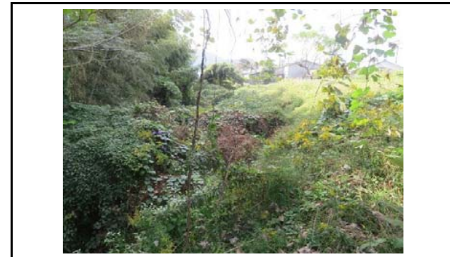
写真11 盛土のり面の状況(変状なし)
