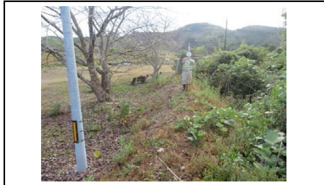
写真2 盛土側方境界部の状況(変状なし)
