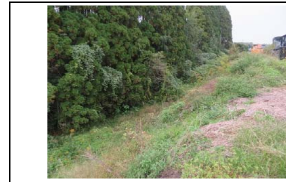
写真12 盛土のり面下方部の状況(変状なし)
