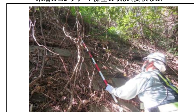
写真21 盛土のり面の状況 張りブロックの押し出し状況
