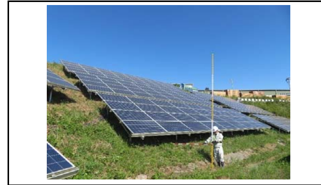
写真3 盛土のり面の状況(変状なし)
