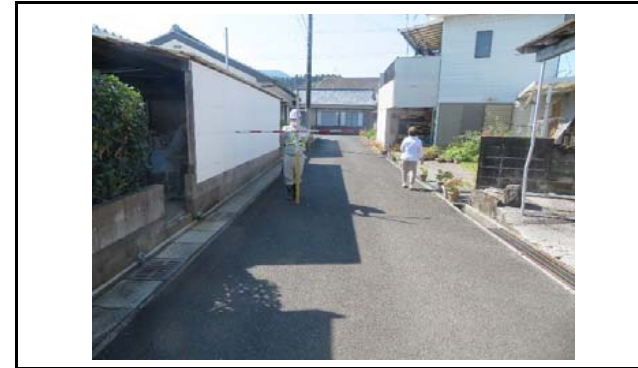
写真3 盛土側方境界部の状況(変状なし)
