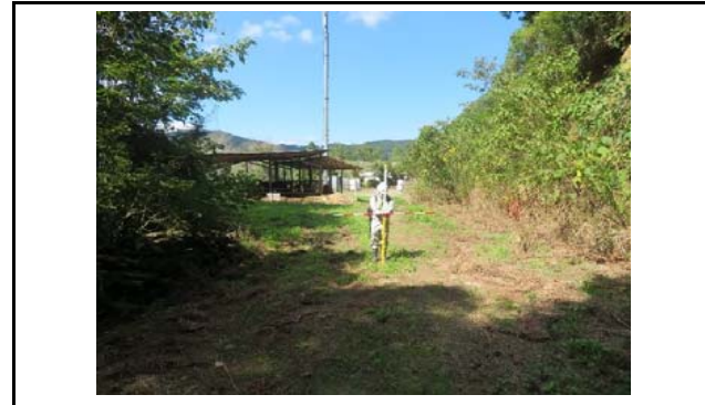
写真2 盛土内の状況(変状なし)
