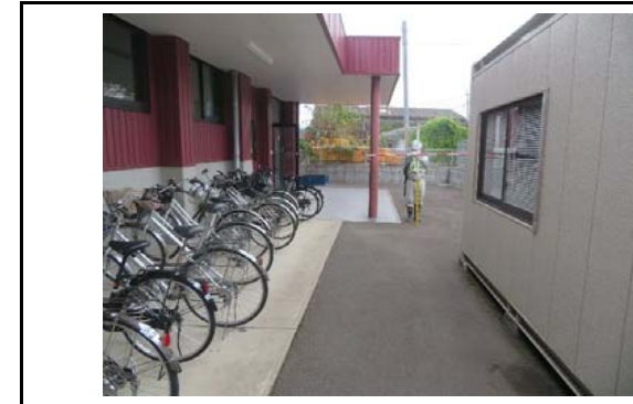
写真4 盛土側方境界部の状況(変状なし)
