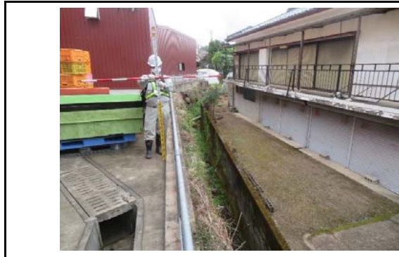
写真1 盛土頭部の状況(変状なし)
