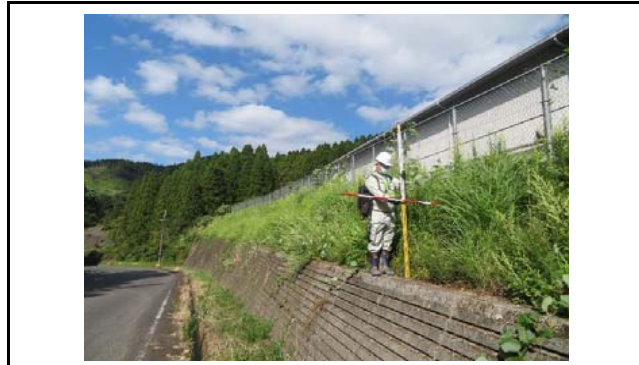
写真10 擁壁上部の盛土のり面の状況(変状なし)
