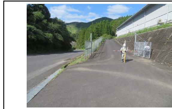
写真6 盛土末端部の状況(変状なし)
