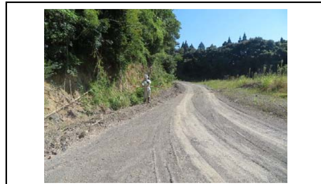
写真10 盛土頭部の状況(変状なし)
