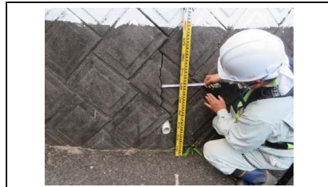
写真12 盛土末端のブロック積擁壁の開口クラック (初期値:開口8mm)
