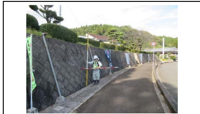
写真11 盛土末端のブロック積擁壁(変状なし)
