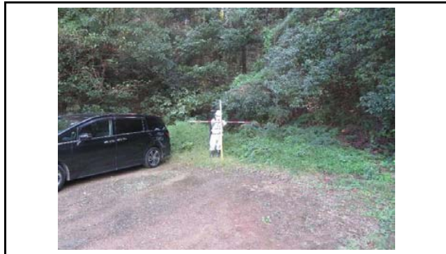
写真5 盛土側方境界部の状況(変状なし)
