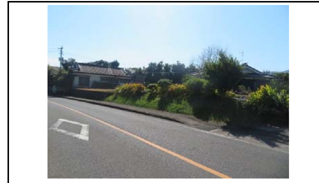
写真7 盛土内の状況(変状なし)
