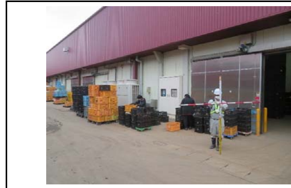
写真2 盛土側方境界部の状況(変状なし)
