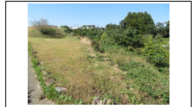
写真12 盛土内の状況(変状なし)
