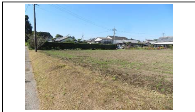
写真13 盛土内の状況(変状なし)
