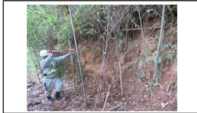
写真3 現地盤状況(盛土範囲から除外)
