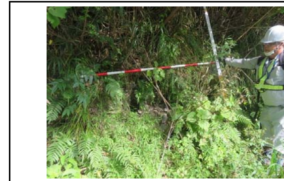
写真8 盛土側方境界部の小崩壊(植生は回復傾向)
