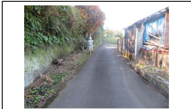
写真9 盛土側方境界部の状況(変状なし)
