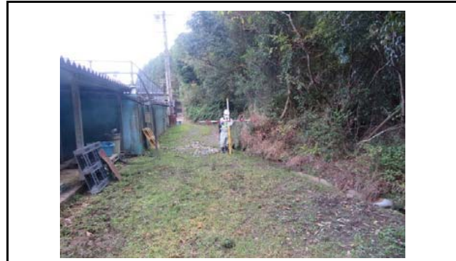
写真3 盛土側方境界部の状況(変状なし)
