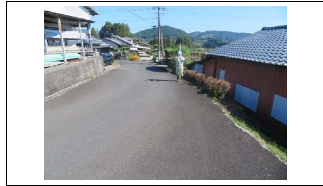
写真2 盛土頭部の状況(変状なし)
