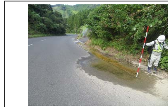
写真7 路面からの湧水状況(広域農道黒潮ロード) 地下水または道路埋設物?の影響なのか不明
