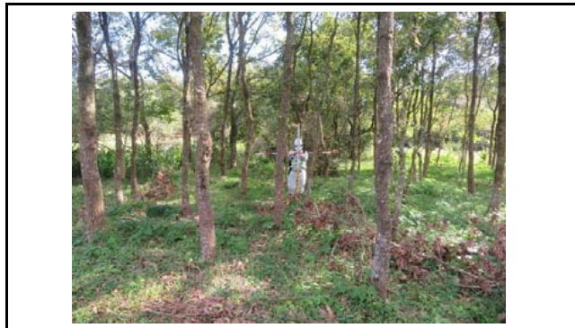
写真9 盛土内の状況(変状なし)
