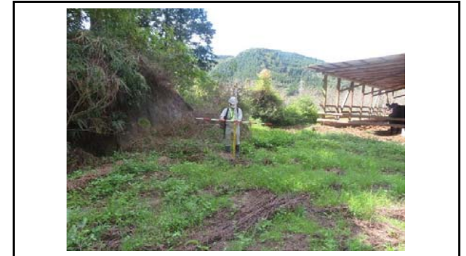
写真4 盛土側方境界部の状況(変状なし)
