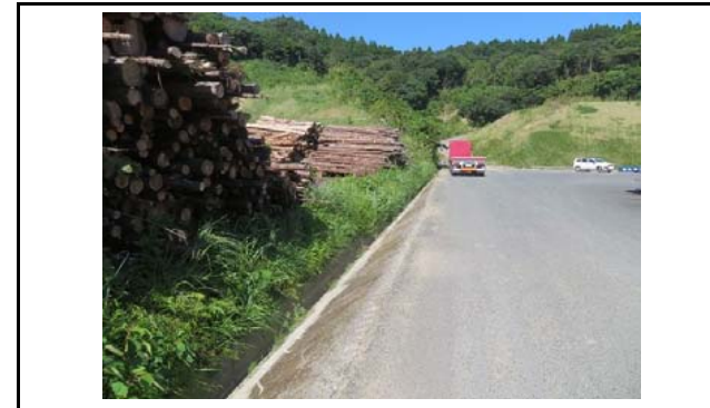
写真7 盛土側方境界部の状況(変状なし)
