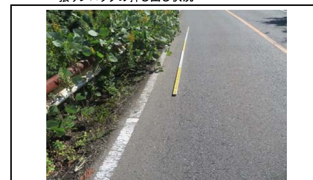
写真25 末端盛土のり面上端部(道路) 路端にヘアクラックが見られる
