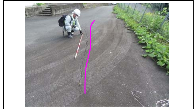
写真4 末端盛土のり面上端部のクラック状況
