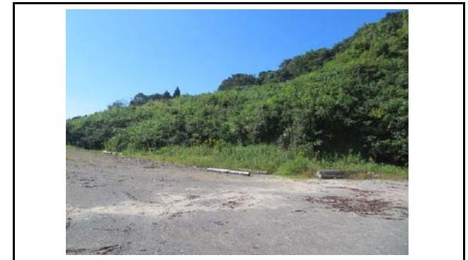
写真12 盛土頭部の状況(変状なし)
