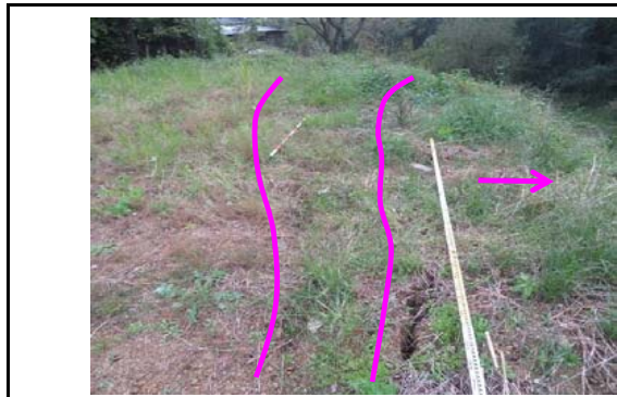
写真9 末端盛土のり面の上部に見られる連続亀裂
