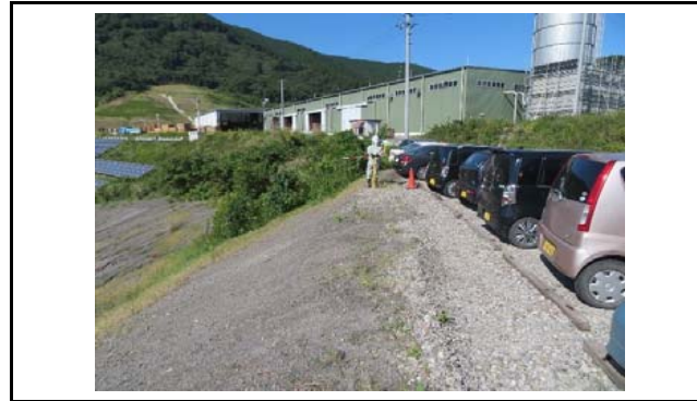
写真3 末端盛土のり面上端部(変状なし)
