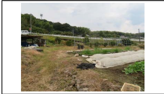
写真1 盛土頭部の状況(変状なし)
