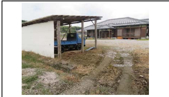
写真5 盛土側方境界部の状況(変状なし)
