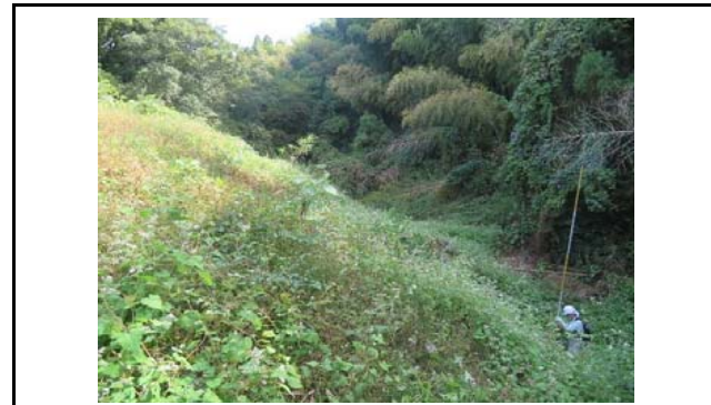
写真10 盛土のり面の状況(変状なし)
