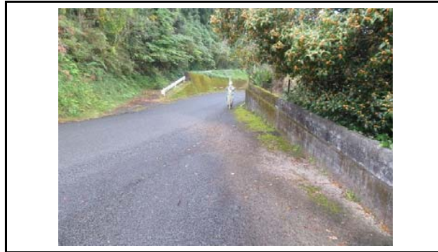
写真2 盛土頭部の状況(変状なし)
