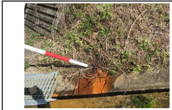
写真5 盛土末端部からの湧水状況
