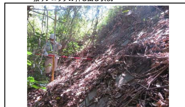
写真20 張りブロックの状況 これより左側は植生繁茂が著しく明確に変状確認困難
