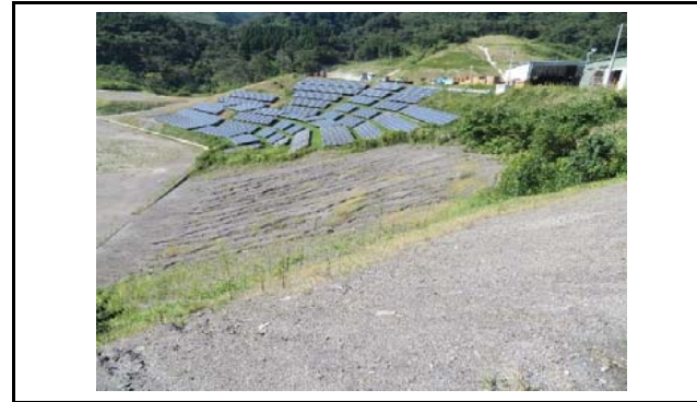
写真4 盛土のり面の状況 のり面全体でガリ浸食が確認できる
