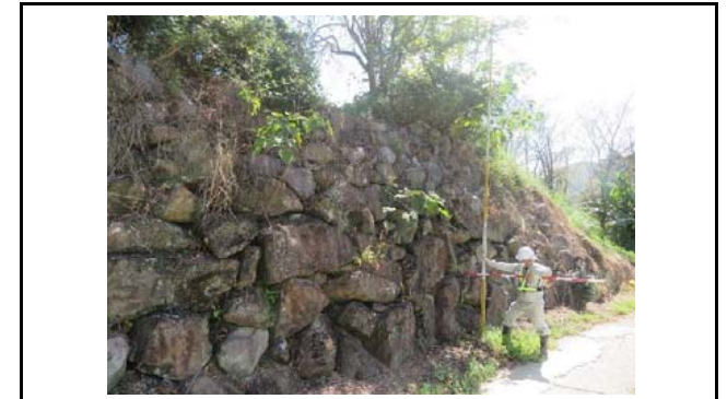
写真8 盛土のり面末端部の石積工の状況(変状なし)
