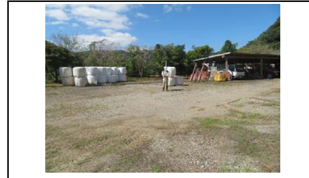
写真3 盛土側方境界部の状況(変状なし)
