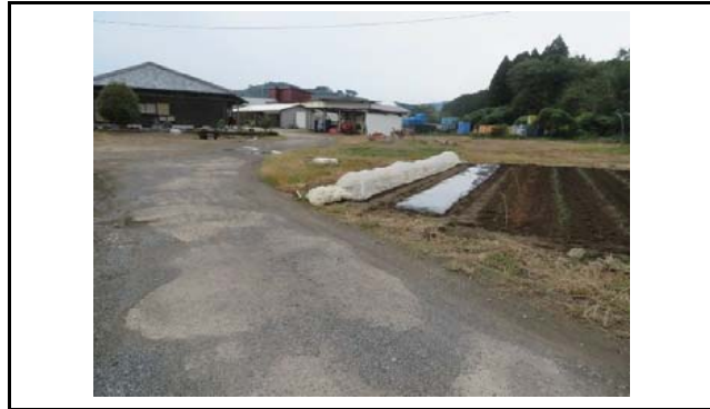
写真2 盛土内の状況(変状なし)
