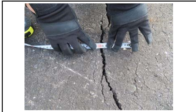
写真5 写真4の近景 初期値:開口10mm
