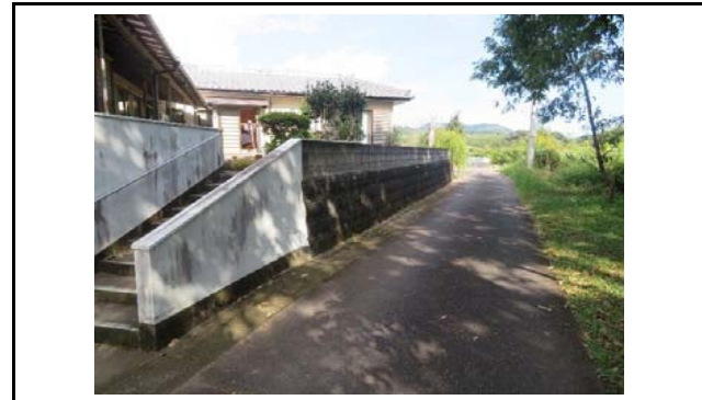
写真6 盛土頭部の状況(変状なし)
