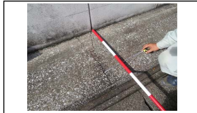
写真8 盛土側方境界部の状況 コンクリートたきのクラック(初期値:開口5mm)
