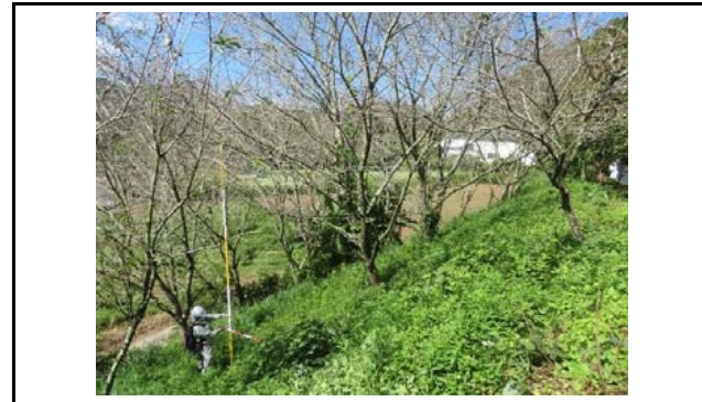
写真6 盛土のり面の状況(変状なし)
