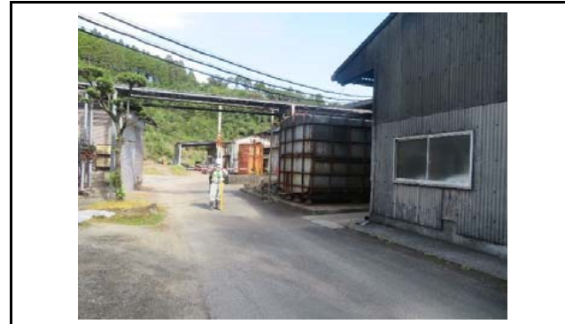
写真4 盛土内の状況(変状なし)
