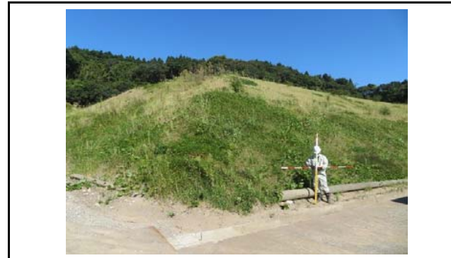
写真6 盛土末端部付近のひな壇のり面の状況(変状なし)
