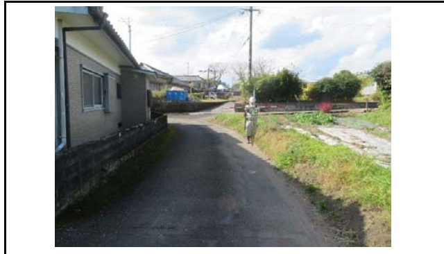
写真1 盛土頭部の状況(変状なし)
