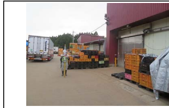
写真6 盛土側方境界部の状況(変状なし)
