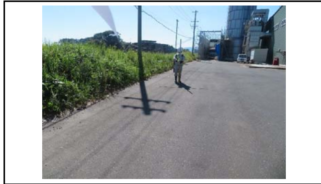
写真2 盛土側方境界部の状況(変状なし)
