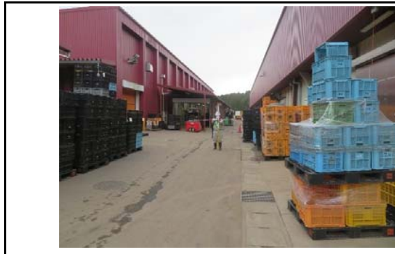
写真5 盛土内の状況(変状なし)
