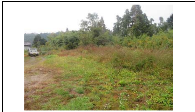
写真9 盛土内の状況(変状なし)
