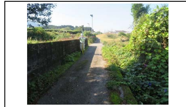
写真11 盛土側方境界部の状況(変状なし)
