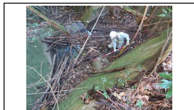
写真18 盛土末端部の排水施設状況(変状なし)
