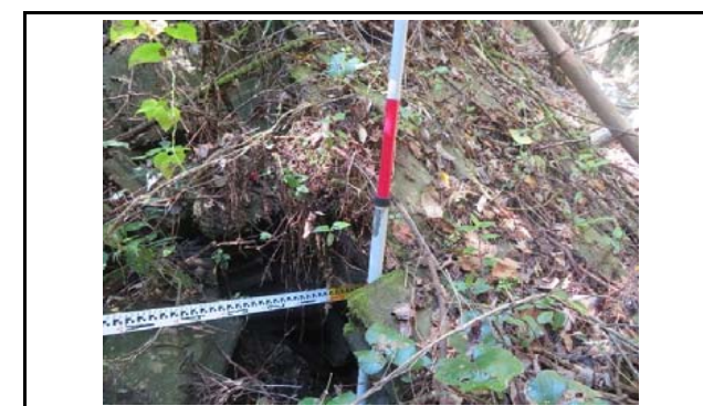
写真15 盛土のり面の状況 張りブロックの空洞化状況
