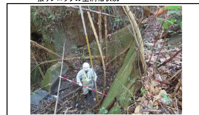
写真17 盛土のり面の状況 末端のコンクリート擁壁の状況(変状なし)
