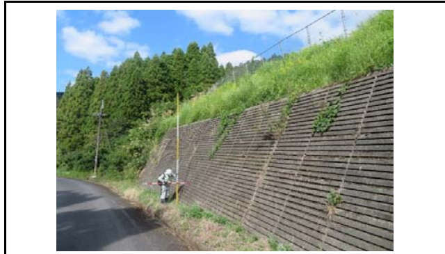
写真9 盛土のり面末端部の擁壁状況(変状なし)
