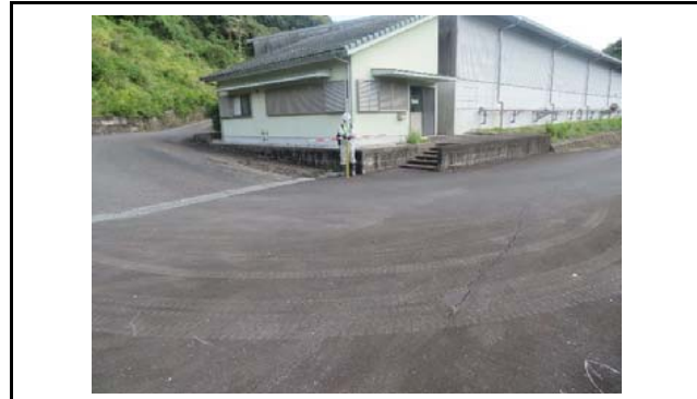
写真3 盛土側方境界部の状況(変状なし)
