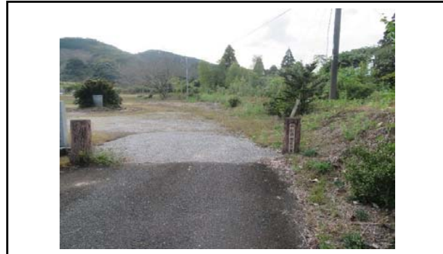
写真3 盛土側方境界部の状況(変状なし)
