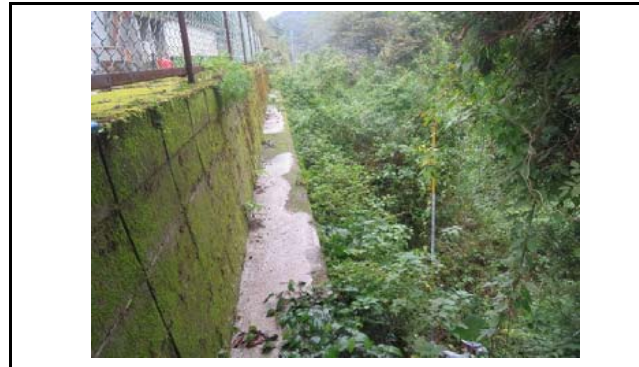
写真7 盛土末端擁壁の状況(変状なし) Co擁壁H=3.6m、ブロック積擁壁H=1.0m、空洞ブロックH=1.1m
