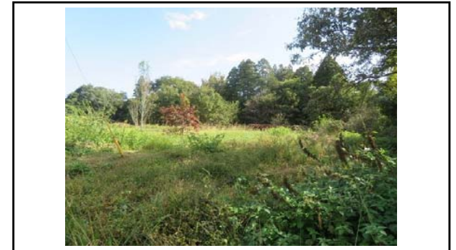
写真8 盛土側方境界部の状況(変状なし)
