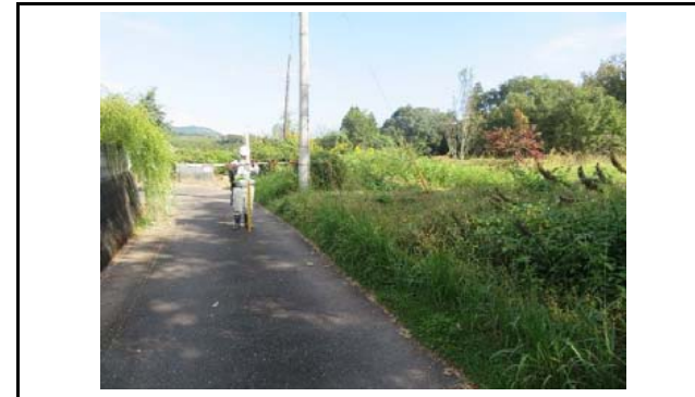
写真7 盛土側方境界部の状況(変状なし)
