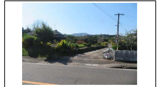
写真8 盛土内の状況(変状なし)
