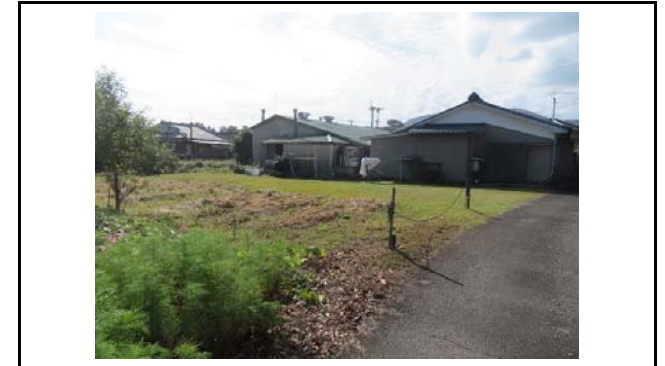
写真4 盛土内の状況(変状なし)
