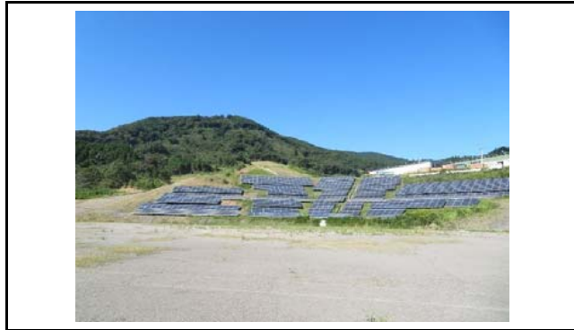
写真1 盛土末端全景
