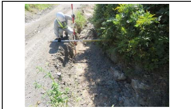
写真9 盛土側方に位置する素掘り排水の浸食状況
