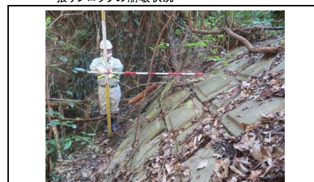
写真16 盛土のり面の状況 張りブロックの押し出し状況
