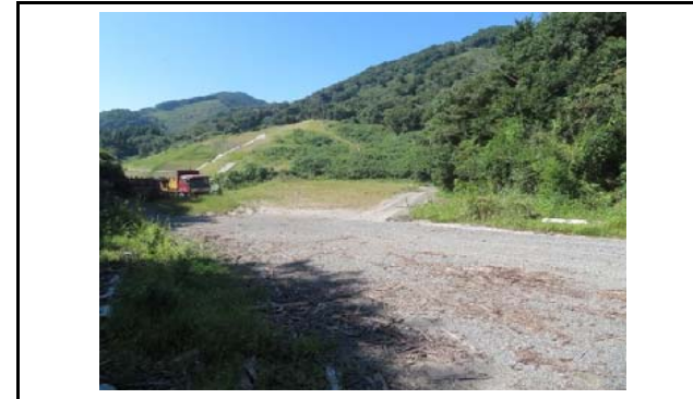
写真3 盛土内の状況(変状なし)
