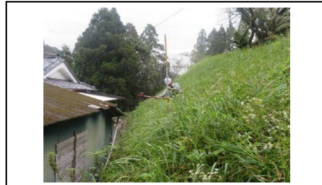
写真8 盛土末端のり面の状況(変状なし)
