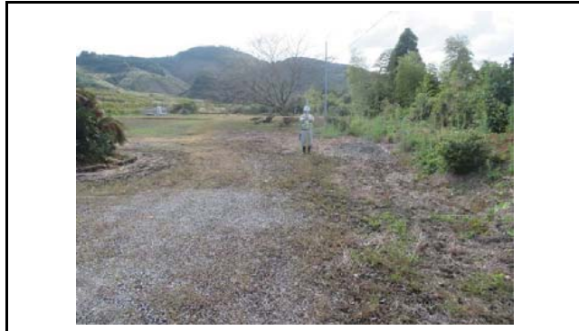
写真1 盛土頭部の状況(変状なし)
