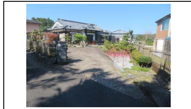
写真10 盛土内の状況(変状なし)
