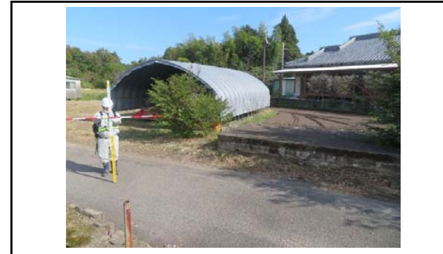
写真3 盛土側方境界部の状況(変状なし)
