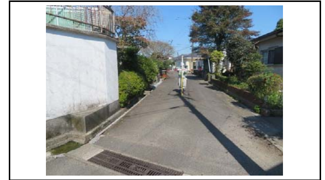
写真4 盛土側方境界部の状況(変状なし)
