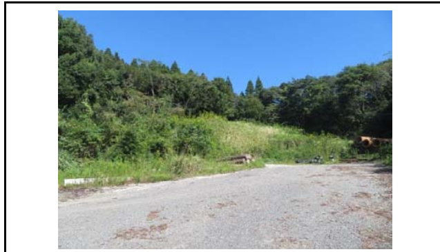
写真5 盛土側方境界部の状況(変状なし)
