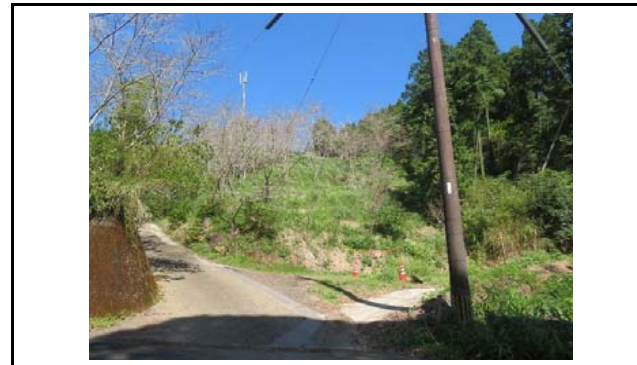
写真10 盛土末端部全景
