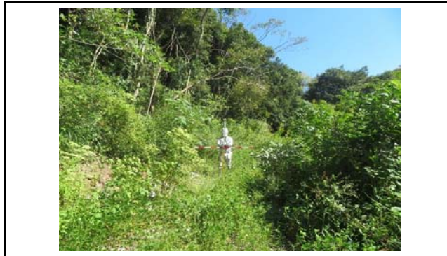
写真1 盛土頭部の状況(変状なし)
