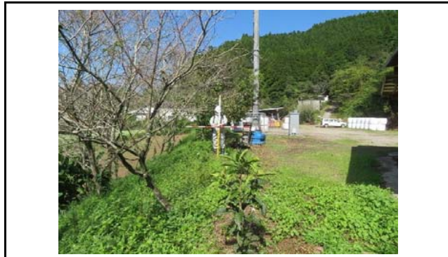
写真5 末端盛土のり面の上部(変状なし)
