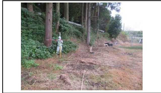
写真3 盛土側方境界部の状況(変状なし)
