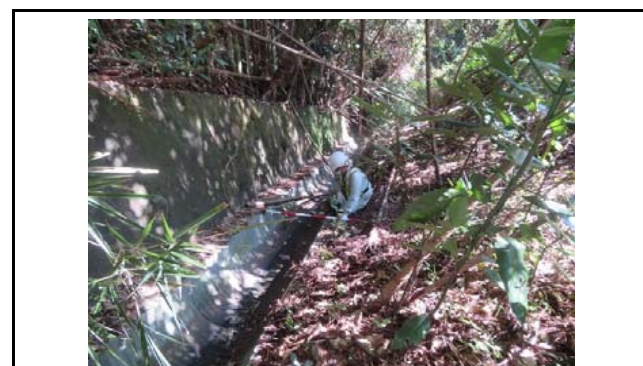
写真22 盛土のり面縦排水の状況(変状なし)
