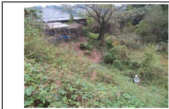
写真13 盛土のり面の状況(変状なし)
