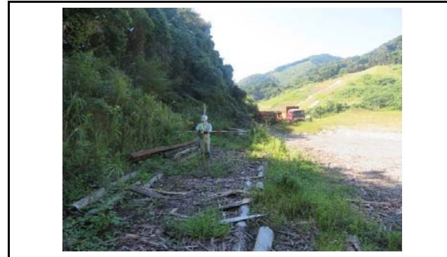
写真2 盛土側方境界部の状況(変状なし)
