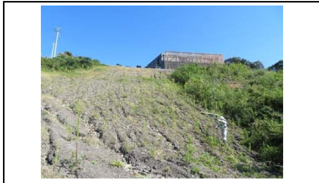
写真5 盛土のり面のガリ浸食状況 のり面の植生工は乏しくのり面が露出している状況
