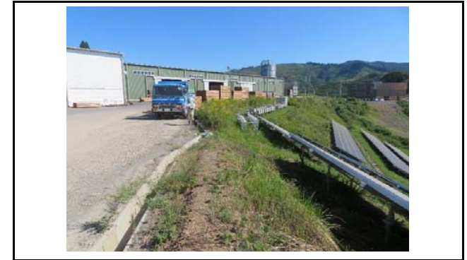
写真4 末端盛土のり面上端部(変状なし)
