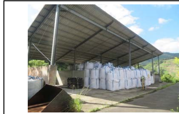
写真2 盛土側方境界部の状況(変状なし)
