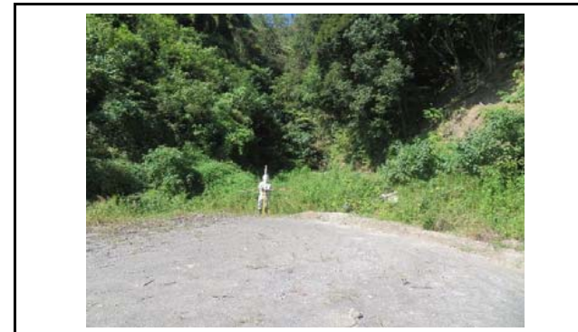
写真11 盛土頭部の状況(変状なし)
