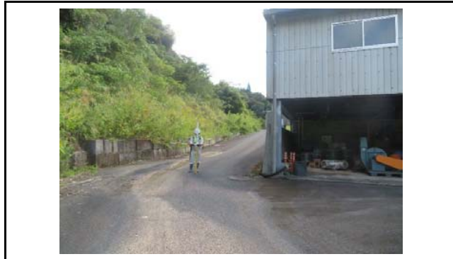
写真1 盛土頭部の状況(変状なし)
