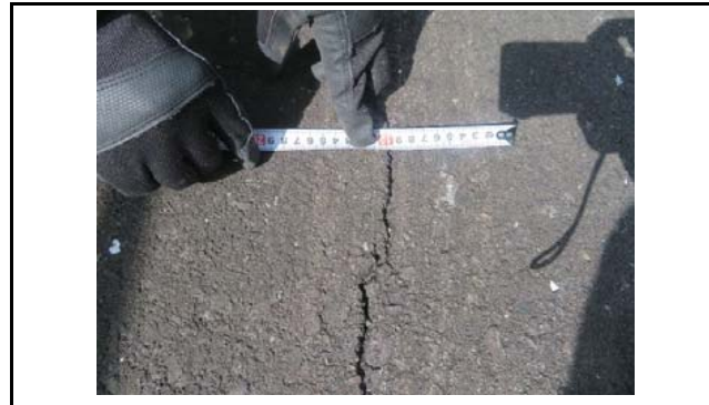
写真7 写真6の近景 初期値:開口5mm
