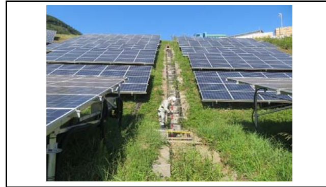
写真2 盛土のり面及び排水施設の状況(変状なし)
