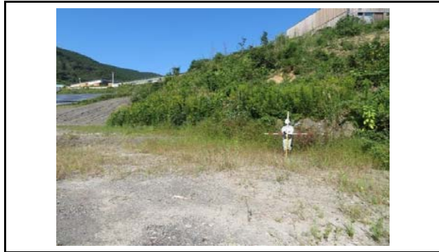
写真1 盛土頭部付近
