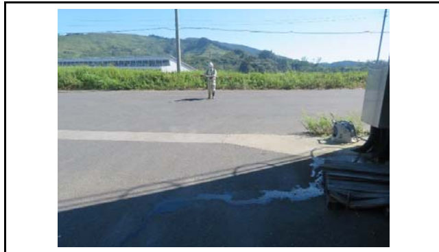
写真5 盛土側方境界部の状況(変状なし)
