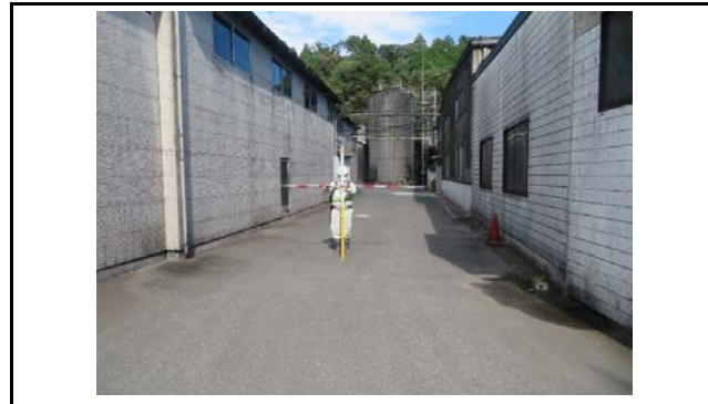
写真7 盛土側方境界部の状況(変状なし)
