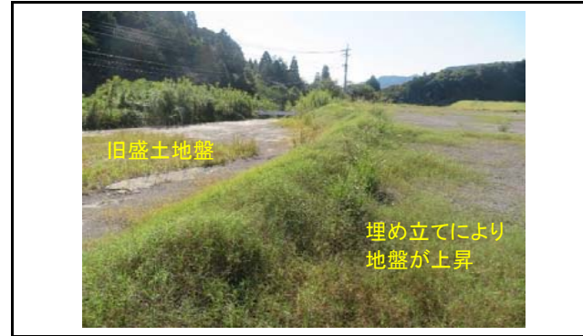
写真3 盛土内の状況 新たな埋め立てにより地盤が上昇している
