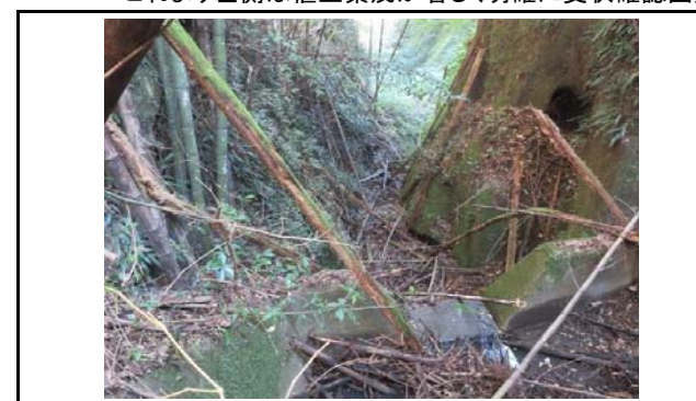
写真24 盛土のり面下方の状況(変状なし)
