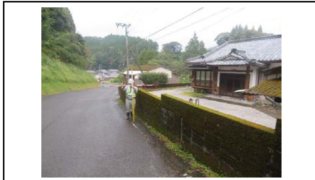
写真5 盛土側方境界部の状況(変状なし)
