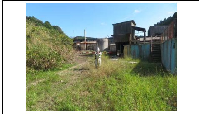
写真2 盛土側方境界部の状況(変状なし)
