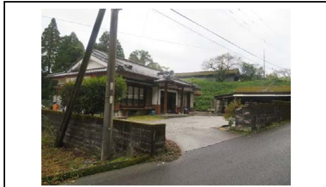
写真6 盛土内の状況(変状なし)
