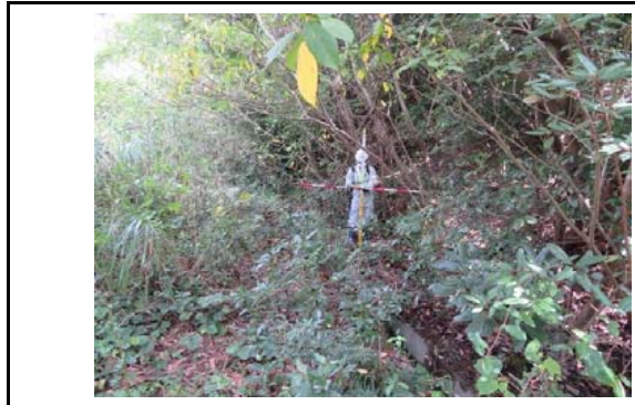
写真1 盛土頭部の状況(変状なし)
