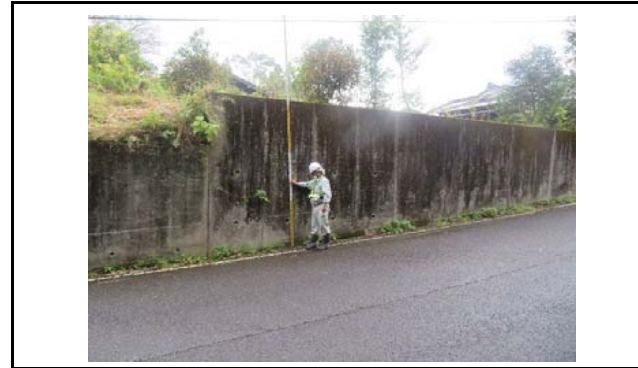
写真4 盛土頭部の状況(変状なし)
