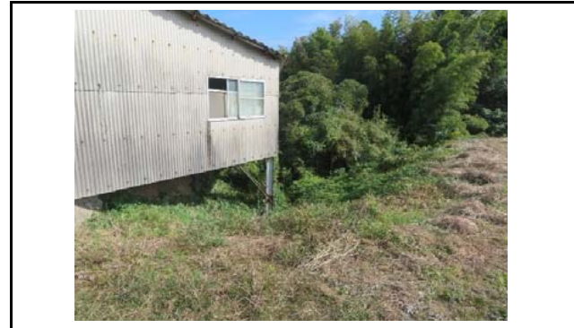
写真2 盛土内の状況(変状なし)
