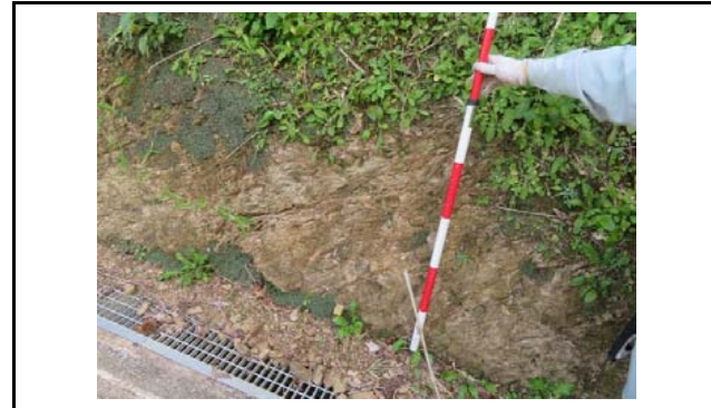
写真4 基盤岩の露頭(盛土範囲を修正)
