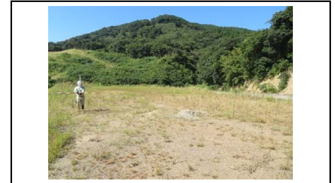
写真4 盛土内の状況(変状なし)
