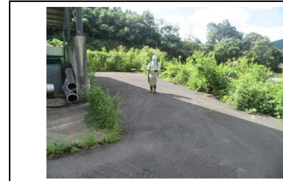
写真4 盛土側方境界部の状況(変状なし)
