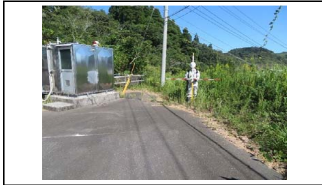
写真1 盛土頭部の状況(変状なし)
