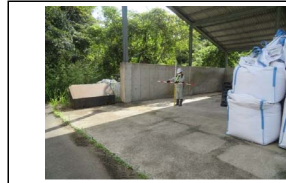
写真3 盛土側方境界部の状況(変状なし)
