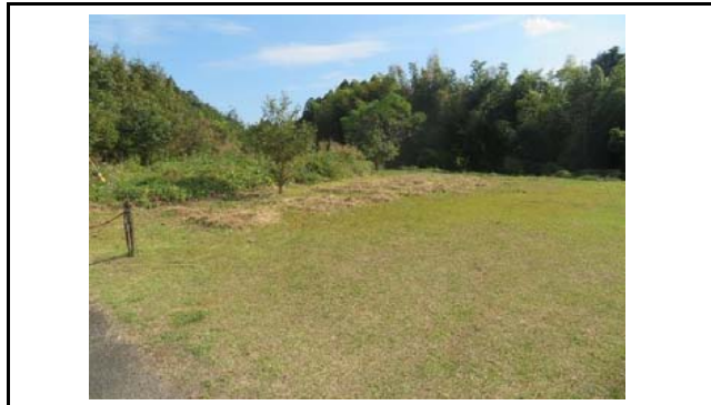
写真5 盛土内の状況(変状なし)
