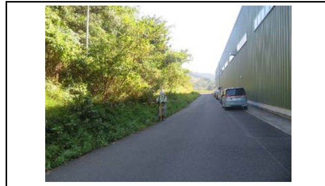
写真6 盛土側方境界部の状況(変状なし)
