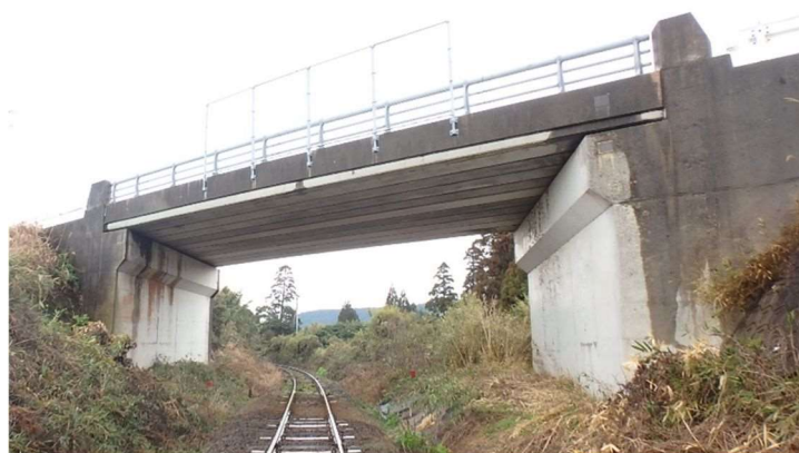
図 9 鉄道を跨ぐ橋梁の例（串間市管理 善田原跨線橋）
