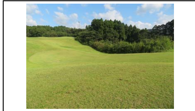
写真3 盛土内の状況(変状なし)
