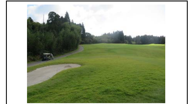
写真8 盛土内の状況(変状なし)
