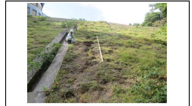
写真8 盛土のり面のガリ浸食状況
