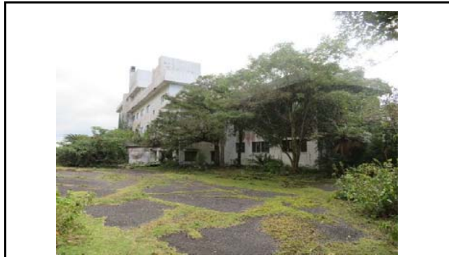
写真5 盛土内の状況(変状なし)
