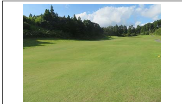
写真5 盛土側方境界部の状況(変状なし)
