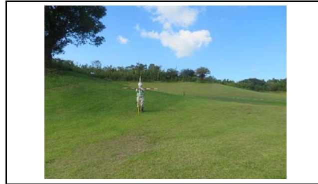
写真2 盛土側方境界部の状況(変状なし)
