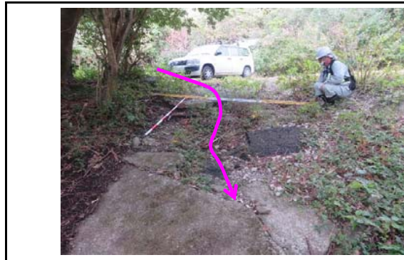
写真6 盛土内の状況 写真5からの雨水により浸食傾向
