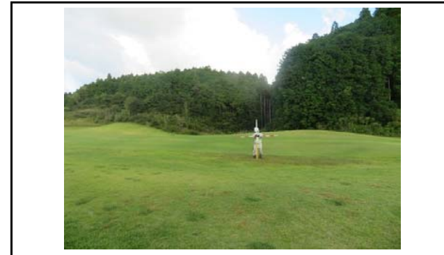
写真7 盛土内の状況(変状なし)
