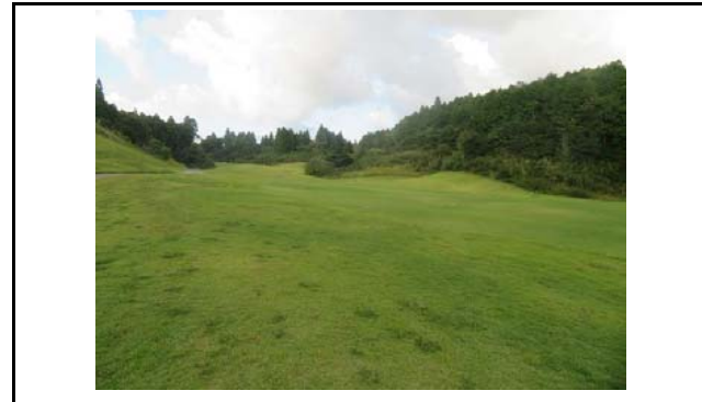
写真6 盛土側方境界部の状況(変状なし)
