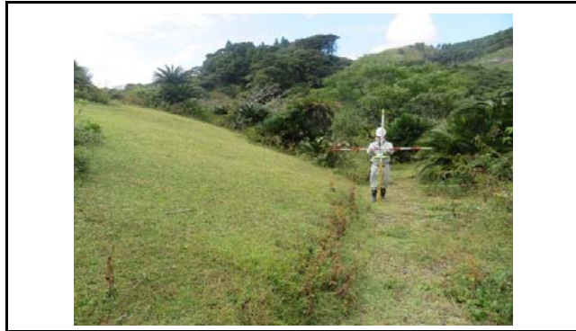
写真1 盛土頭部の状況(変状なし)
