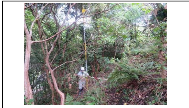
写真5 盛土のり面の状況(変状なし)
