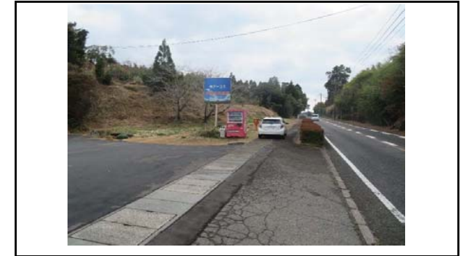
写真4 盛土末端部の状況(変状なし)
