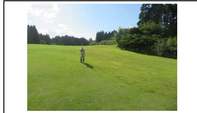
写真2 盛土側方境界部の状況(変状なし)
