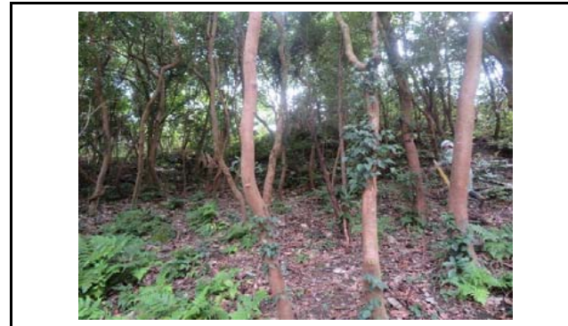
写真8 盛土のり面の状況
