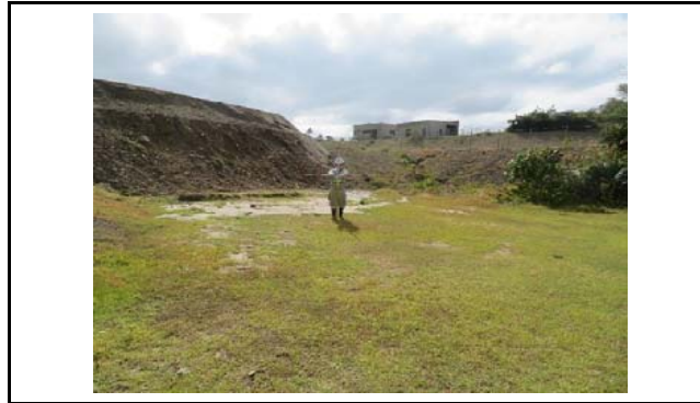
写真2 盛土頭部の状況(変状なし)
