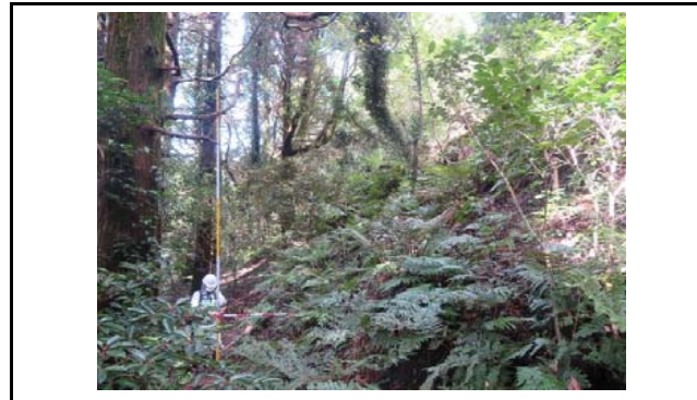
写真7 盛土のり面の状況(変状なし)
