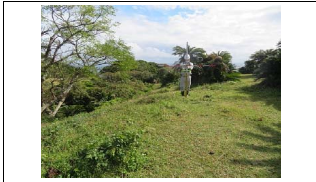
写真5 末端盛土のり面の上部(変状なし)
