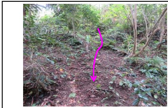
写真9 盛土のり面の肌落ち状況
