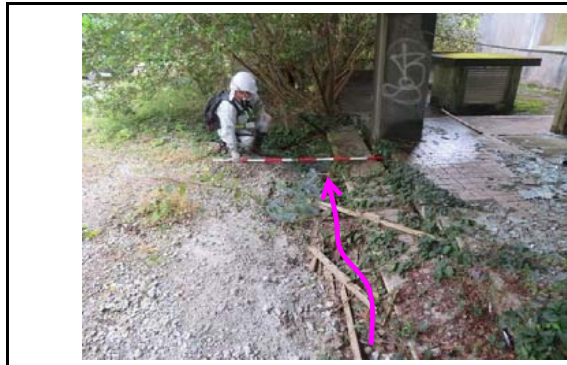
写真5 盛土内の状況 雨水処理が低下しており宅地内が浸食傾向
