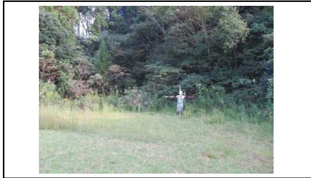
写真1 盛土頭部の状況(変状なし)
