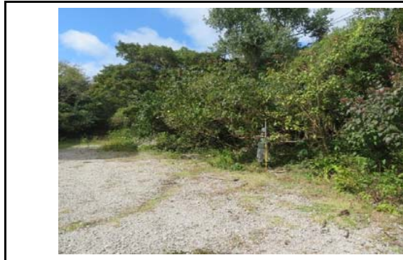
写真1 盛土頭部の状況(変状なし)
