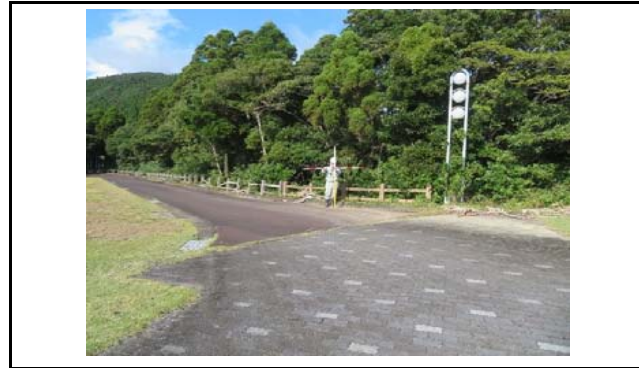
写真3 盛土側方境界部の状況(変状なし)
