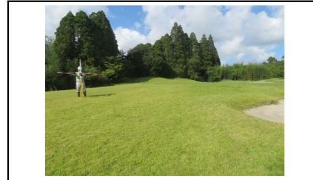
写真3 盛土側方境界部の状況(変状なし)
