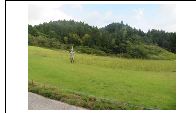
写真3 盛土側方境界部の状況(変状なし)
