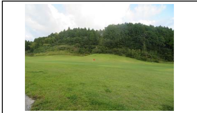
写真5 盛土側方境界部の状況(変状なし)
