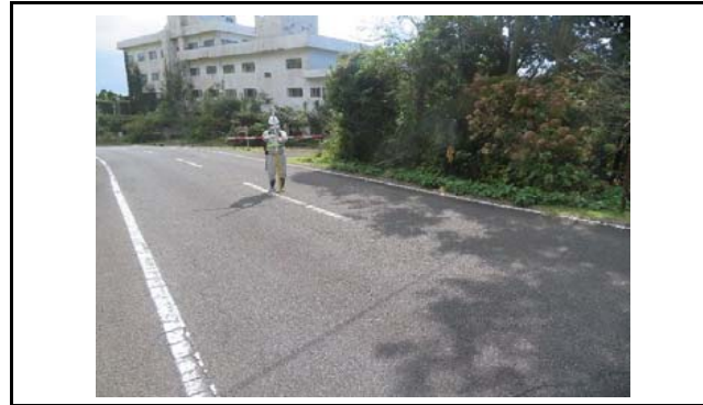
写真3 盛土側方境界部の状況(変状なし)
