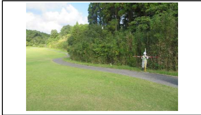
写真1 盛土頭部の状況(変状なし)
