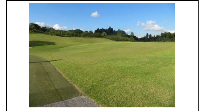
写真4 盛土内の状況(変状なし)
