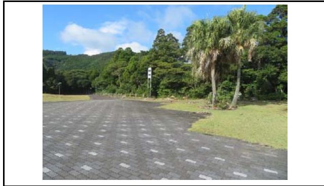
写真1 盛土頭部の状況(変状なし)
