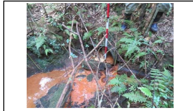
写真6 末端排水施設の状況(変状なし)
