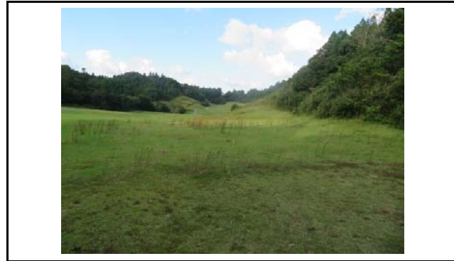
写真3 盛土側方境界部の状況(変状なし)
