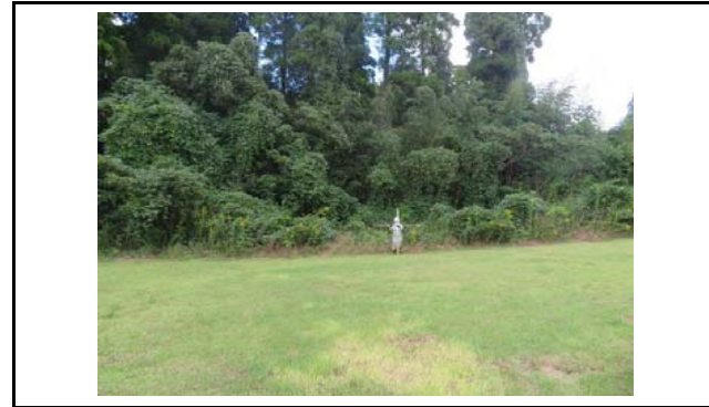
写真2 盛土頭部の状況(変状なし)
