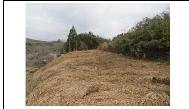
写真2 盛土頭部の状況(変状なし)
