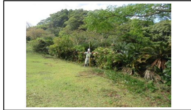
写真4 末端盛土のり面上端部(変状なし)
