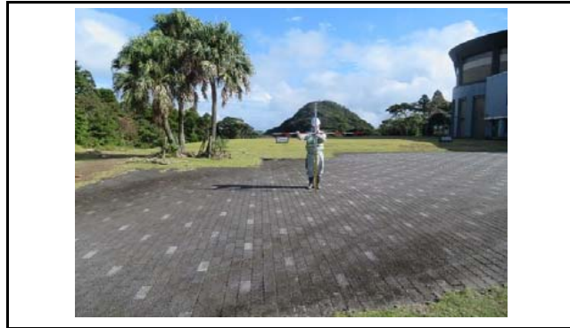
写真2 盛土内の状況(変状なし)
