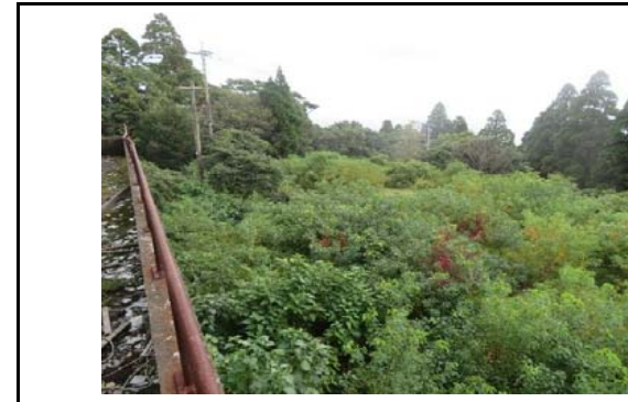
写真8 盛土内の状況(変状なし)
