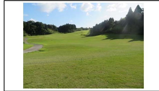
写真3 盛土内の状況(変状なし)
