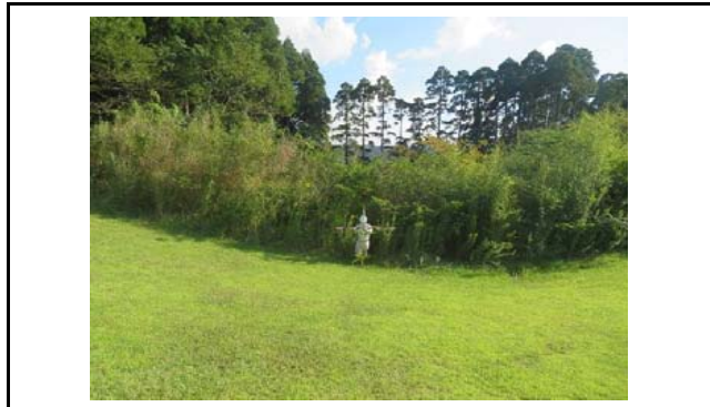
写真5 末端盛土のり面上端部(変状なし)
