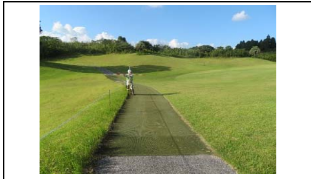
写真5 盛土内の状況(変状なし)
