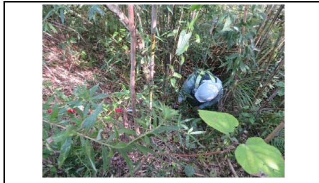
写真6 盛土のり面の状況(変状なし)
