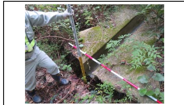
写真10 盛土のり面末端部の排水施設状況 排水直下の洗堀状況
