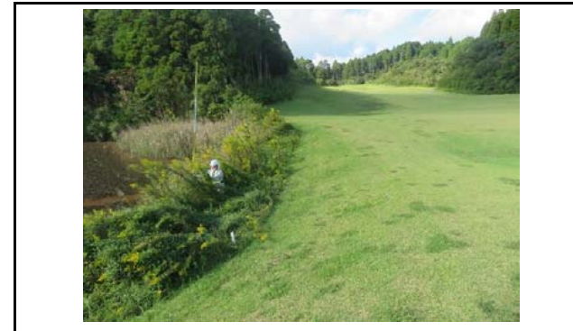
写真7 盛土のり面の状況(変状なし)
