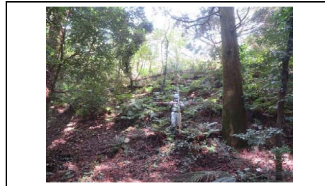
写真8 盛土のり面の状況(変状なし)
