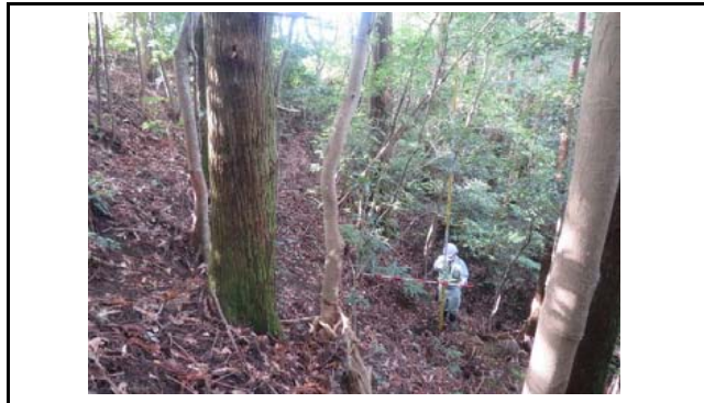
写真5 盛土のり面の状況(変状なし)
