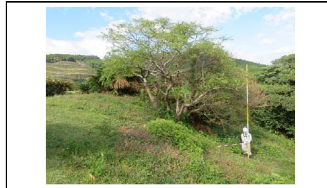
写真6 盛土のり面の状況(変状なし)
