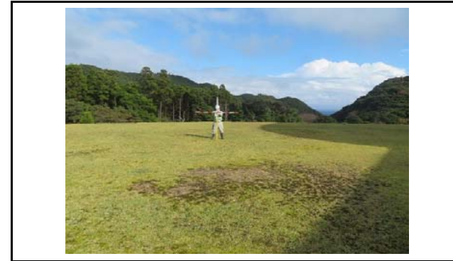
写真3 盛土内の状況(変状なし)
