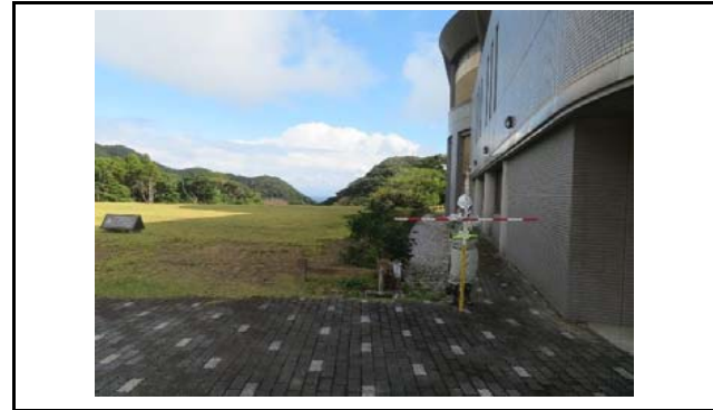
写真2 盛土側方境界部の状況(変状なし)
