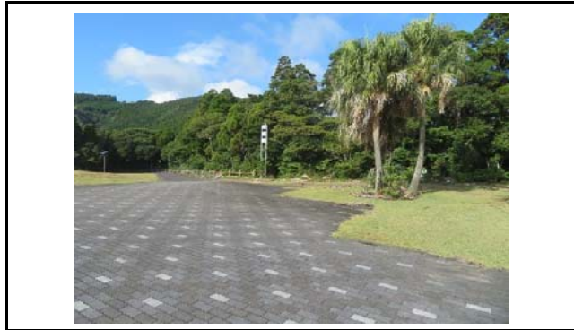
写真1 盛土頭部の状況(変状なし)
