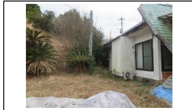
写真6 盛土側方境界部の状況(変状なし)
