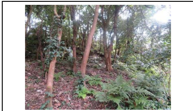
写真9 盛土のり面の状況
