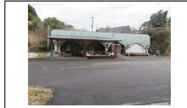
写真7 盛土内の状況(変状なし)
