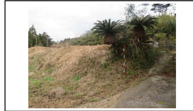
写真3 盛土側方境界部の状況(変状なし)
