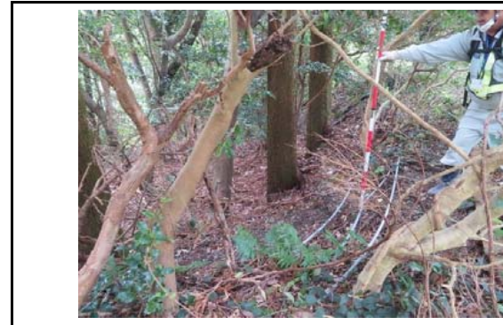
写真3 盛土側方境界部の状況(変状なし)
