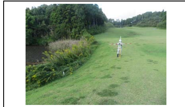
写真6 末端盛土のり面上端部(変状なし)
