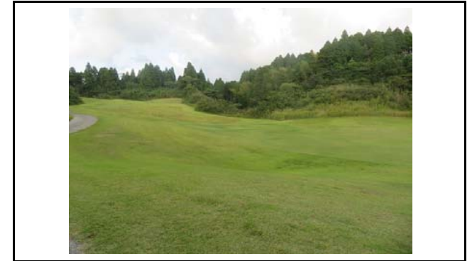
写真4 盛土側方境界部の状況(変状なし)
