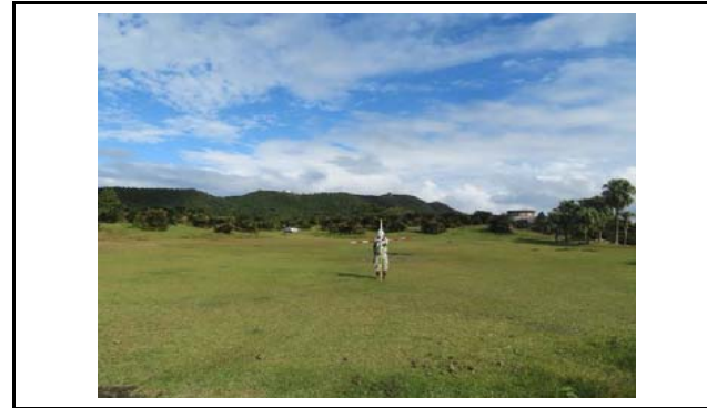
写真2 盛土内の状況(変状なし)
