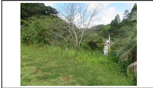
写真1 盛土頭部の状況(変状なし)
