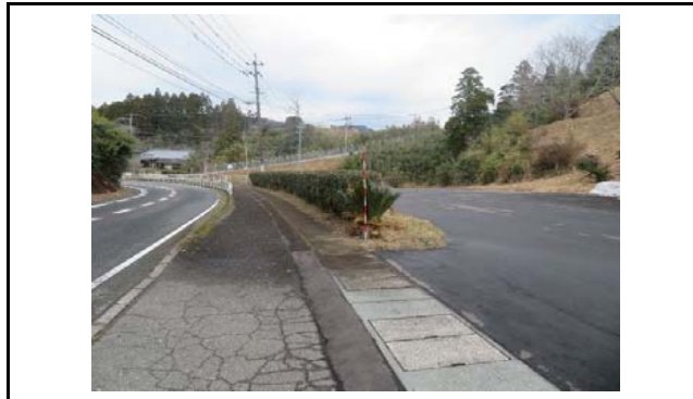
写真5 盛土末端部の状況(変状なし)
