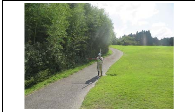
写真1 盛土頭部の状況(変状なし)
