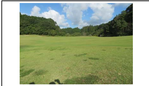
写真5 盛土内の状況(変状なし)
