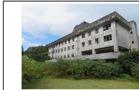
写真11 盛土内の状況(変状なし)
