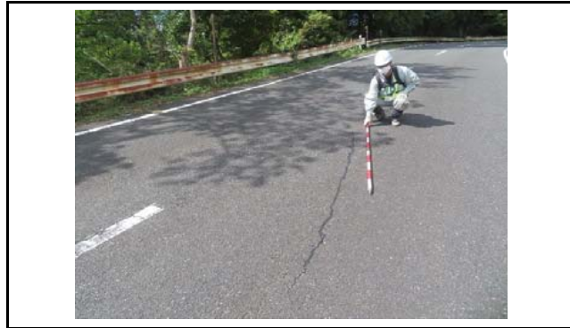
写真2 盛土側方境界部の路面クラックと補修跡
