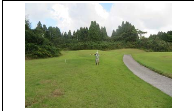
写真1 盛土頭部の状況(変状なし)
