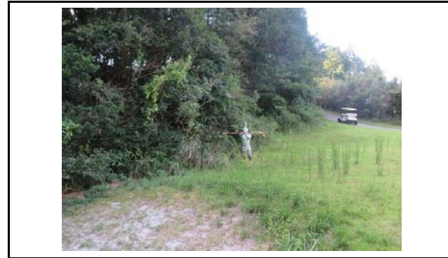
写真4 盛土側方境界部の状況(変状なし)
