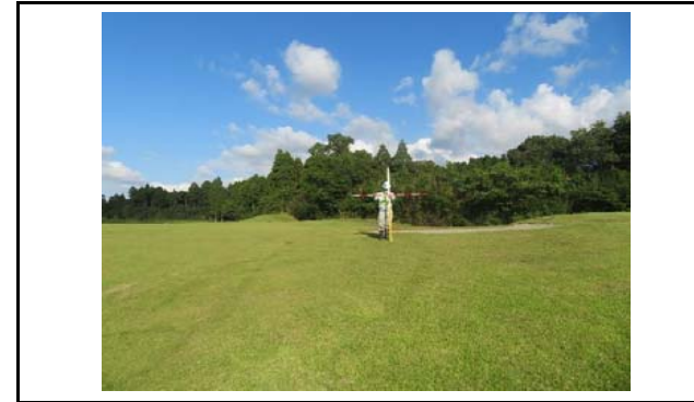
写真3 盛土側方境界部の状況(変状なし)
