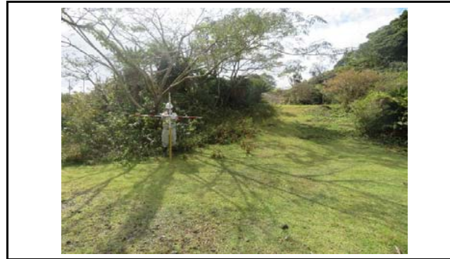
写真3 盛土頭部の状況(変状なし)
