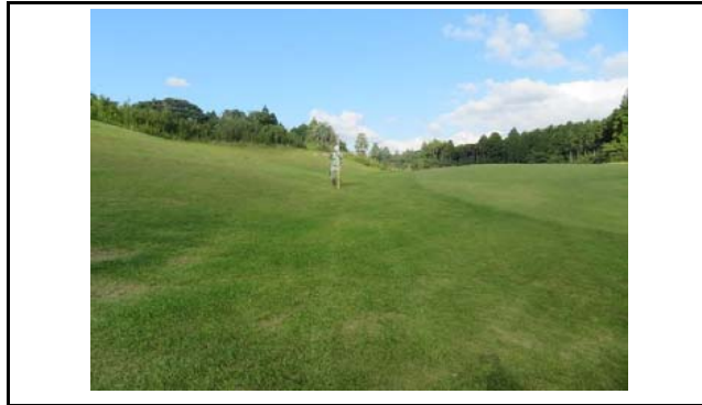
写真1 盛土頭部の状況(変状なし)
