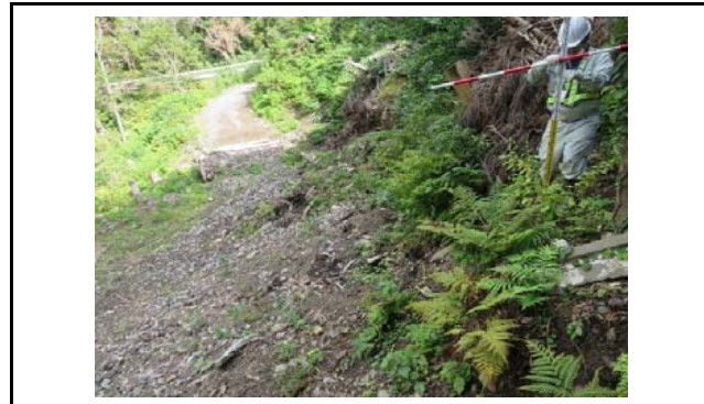
写真7 盛土末端部の状況 道路が通っており盛土末端部は切土されている
