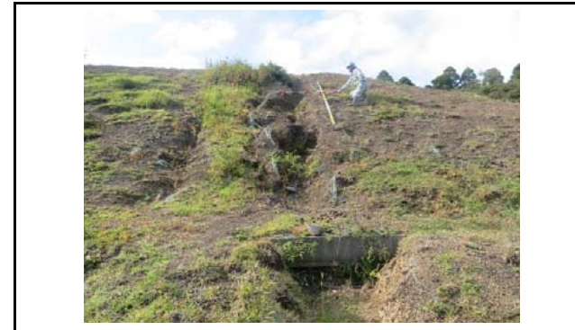
写真7 盛土のり面のガリ浸食状況
