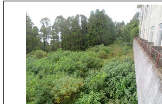
写真7 盛土内の状況(変状なし)
