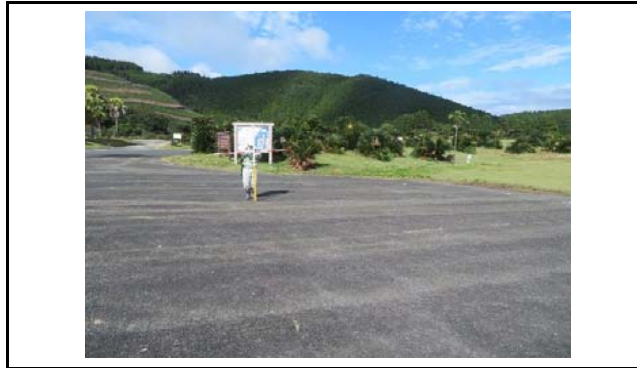
写真1 盛土頭部の状況(変状なし)
