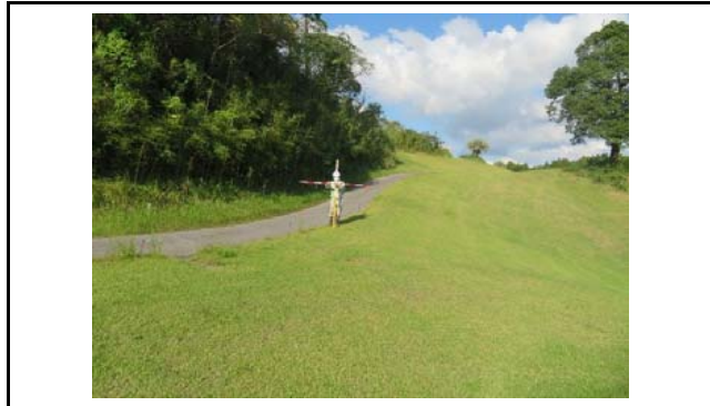
写真1 盛土頭部の状況(変状なし)
