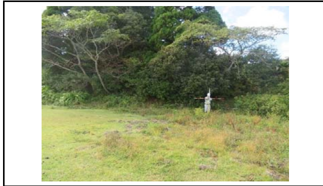
写真1 盛土頭部の状況(変状なし)
