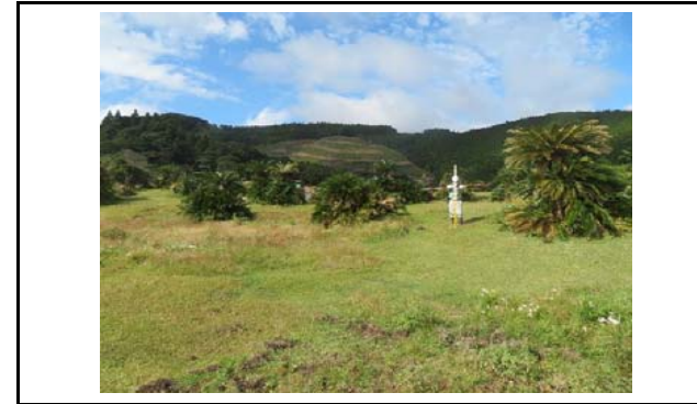
写真3 盛土側方境界部の状況(変状なし)
