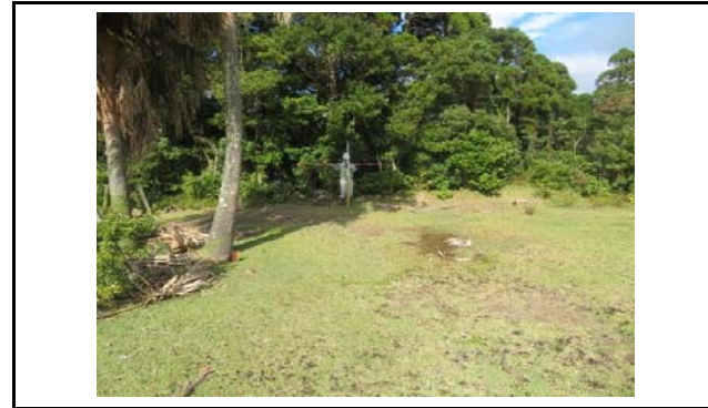
写真4 盛土側方境界部の状況(変状なし)
