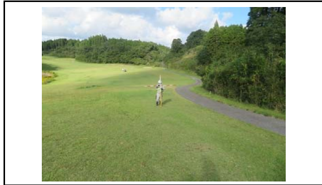
写真2 盛土側方境界部の状況(変状なし)
