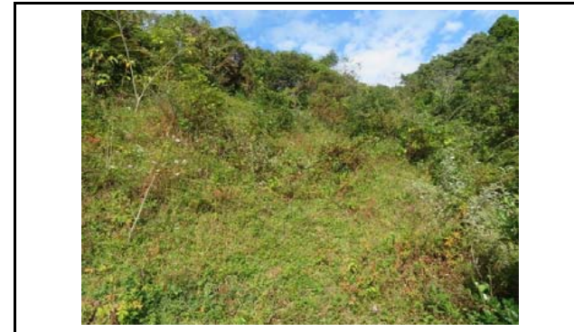
写真7 盛土のり面の状況(変状なし)
