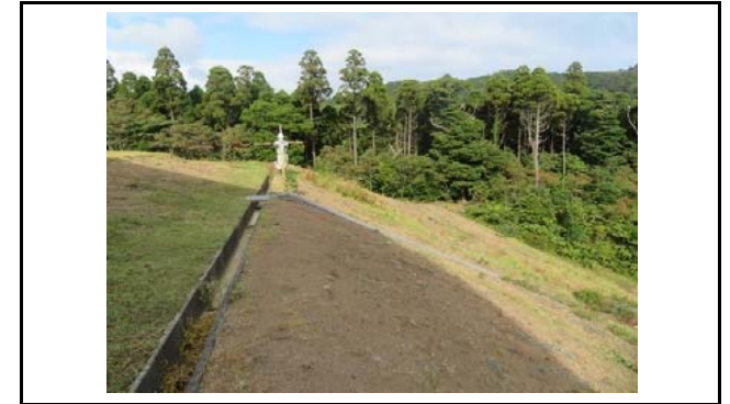
写真4 末端盛土のり面上端部 植生工がなくなっており盛土が露出している
