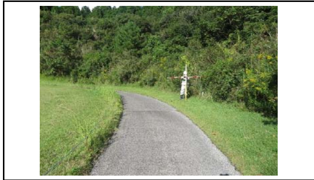
写真1 盛土頭部の状況(変状なし)
