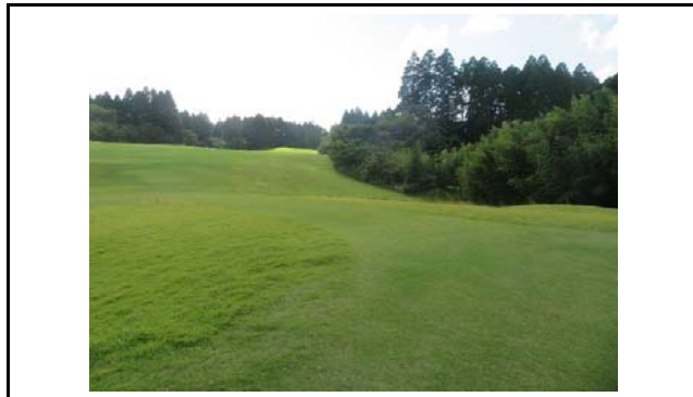
写真9 盛土内の状況(変状なし)
