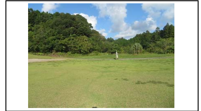
写真4 盛土側方境界部の状況(変状なし)
