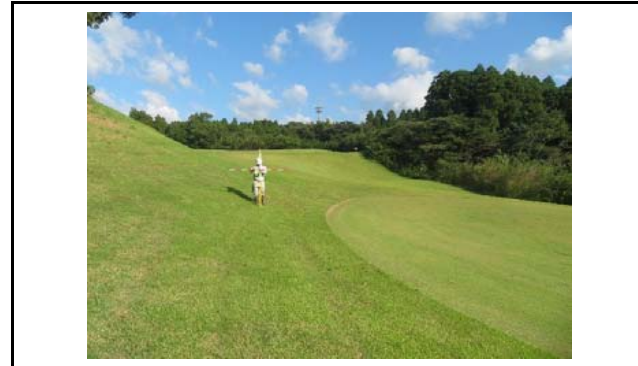
写真4 盛土側方境界部の状況(変状なし)
