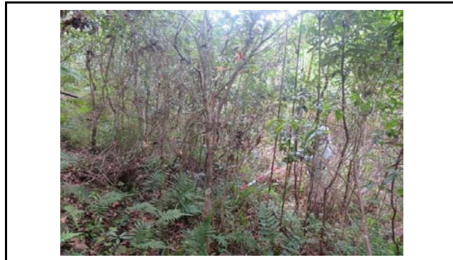
写真6 盛土のり面の状況(変状なし)
