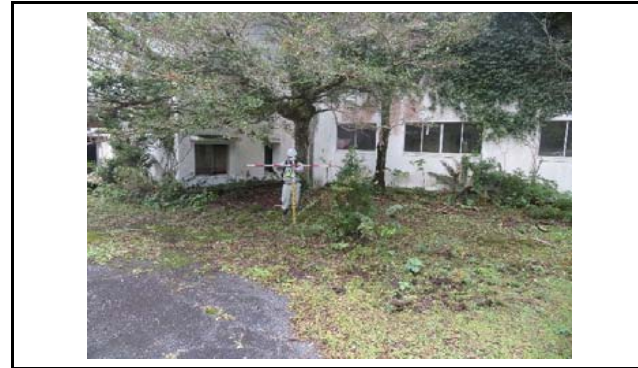
写真4 盛土側方境界部の状況(変状なし)
