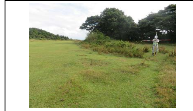
写真3 盛土側方境界部の状況(変状なし)
