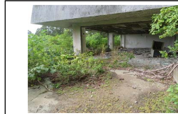
写真4 盛土内の状況(変状なし)
