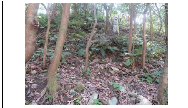
写真6 盛土のり面の状況 のり面の表面は不陸が確認される
