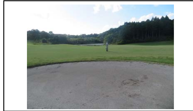
写真2 盛土内の状況(変状なし)
