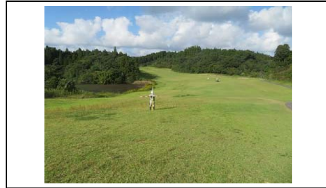
写真4 盛土内の状況(変状なし)
