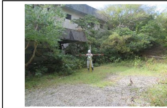
写真2 盛土側方境界部の状況(変状なし)
