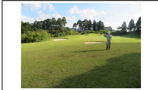
写真2 盛土側方境界部の状況(変状なし)
