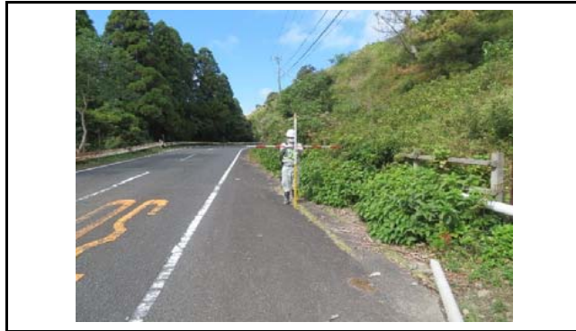
写真1 盛土頭部の状況(変状なし)
