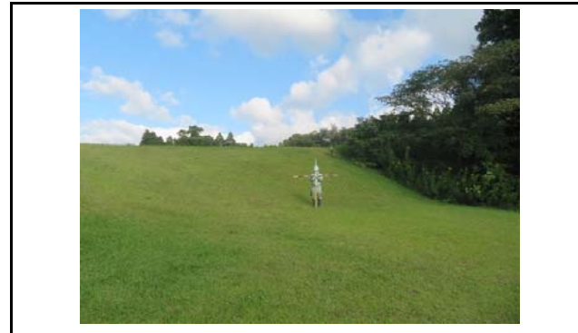
写真6 盛土末端部の状況(変状なし)
