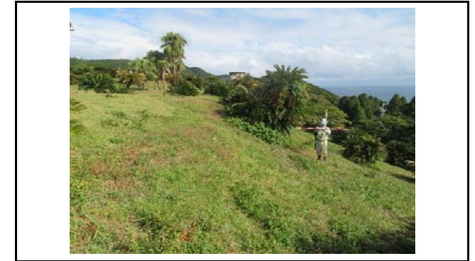
写真4 盛土側方境界部の状況(変状なし)
