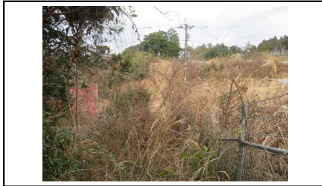
写真1 盛土頭部の状況(変状なし)
