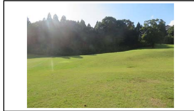
写真2 盛土頭部の状況(変状なし)
