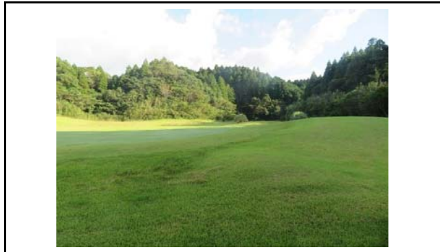
写真5 盛土内の状況(変状なし)
