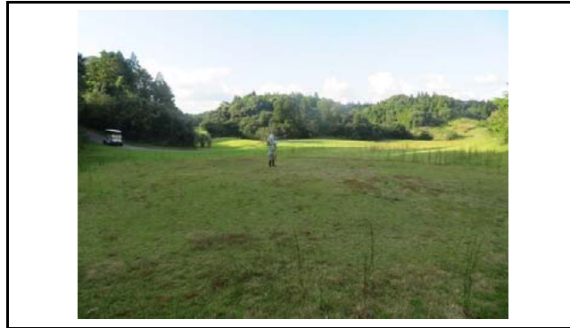
写真2 盛土内の状況(変状なし)
