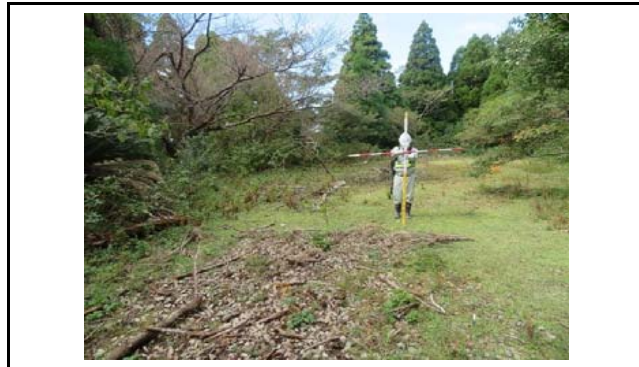
写真6 盛土内の状況(変状なし)
