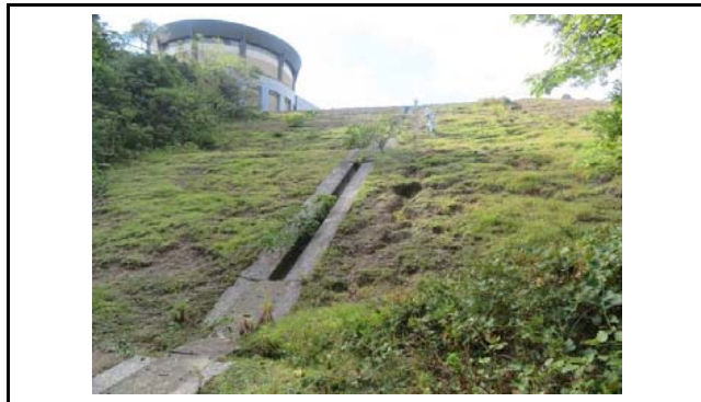
写真9 盛土のり面全景
