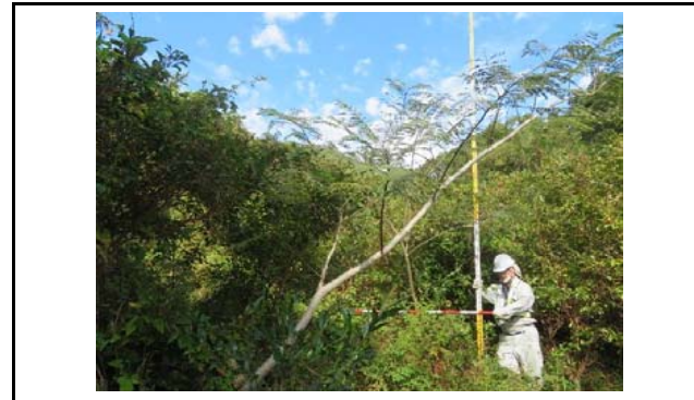
写真6 盛土のり面の状況(変状なし)
