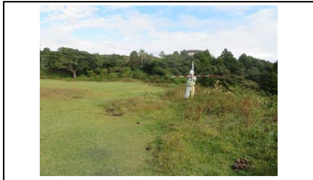
写真5 末端盛土のり面の上部(変状なし)
