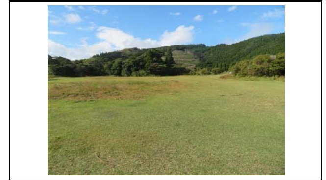
写真4 盛土内の状況(変状なし)
