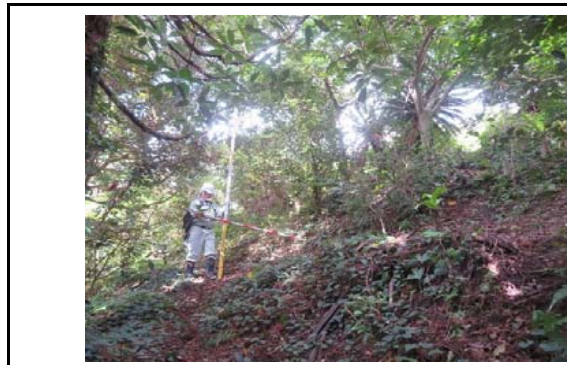
写真10 盛土のり面の状況(変状なし)
