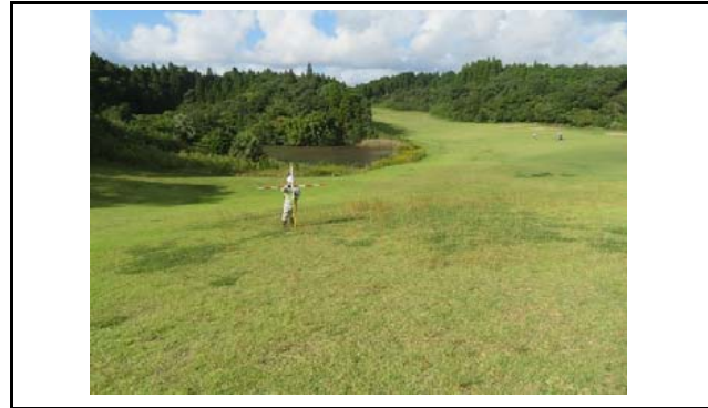
写真3 盛土側方境界部の状況(変状なし)
