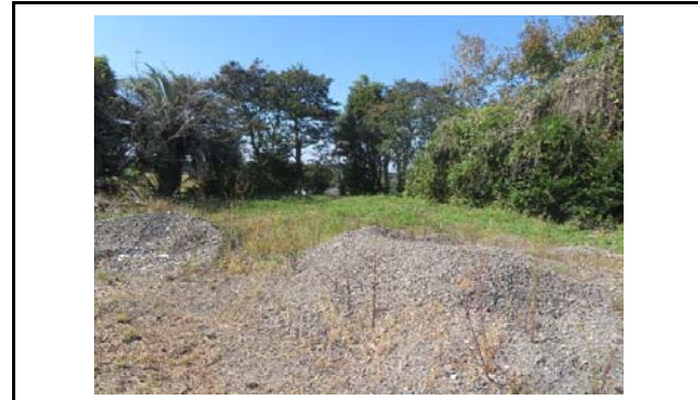
写真4 末端盛土のり面上端部の状況(変状なし)
