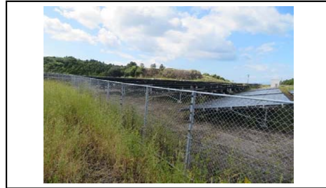
写真2 盛土側方境界部の状況(変状なし)
