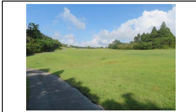
写真5 盛土内の全景(変状なし)
