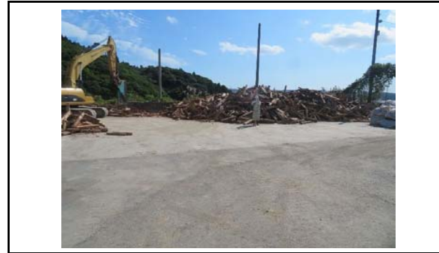
写真2 盛土側方境界部の状況(変状なし)
