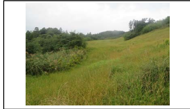
写真4 盛土側方境界部の状況(変状なし)
