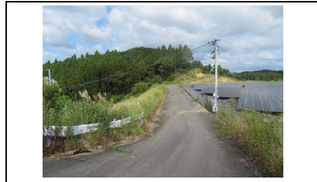
写真6 末端盛土のり面上端部(変状なし)
