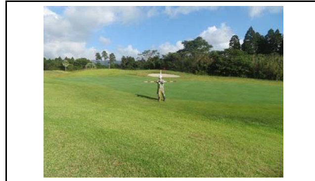
写真2 盛土頭部の状況(変状なし)
