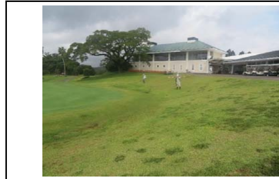
写真4 盛土側方境界部の状況(変状なし)
