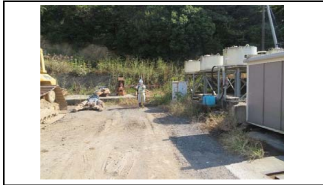
写真1 盛土頭部の状況(変状なし)
