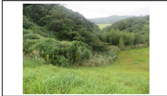
写真2 盛土側方境界部の状況(変状なし)
