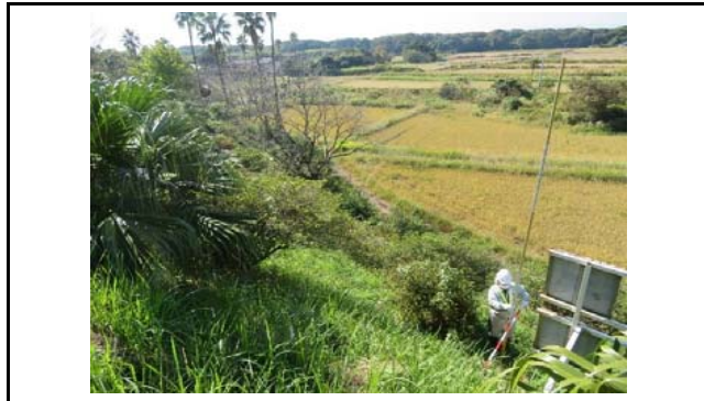
写真5 盛土のり面の状況(変状なし)
