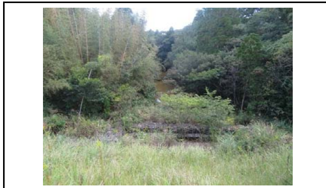
写真9 盛土下方のため池状況
