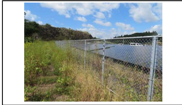
写真2 盛土頭部の状況(変状なし)
