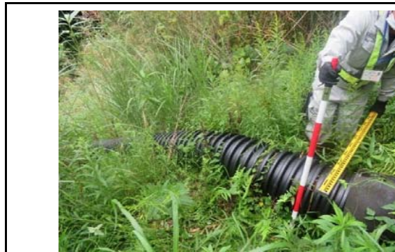
写真10 盛土のり面(3段目)の排水施設状況(変状なし)
