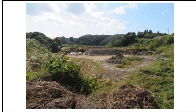
写真2 盛土内の状況(変状なし)
