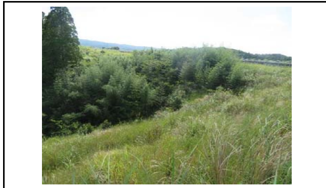
写真5 盛土側方境界部の状況(変状なし)
