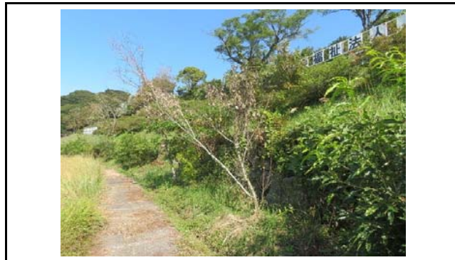
写真10 盛土のり面の状況(変状なし)
