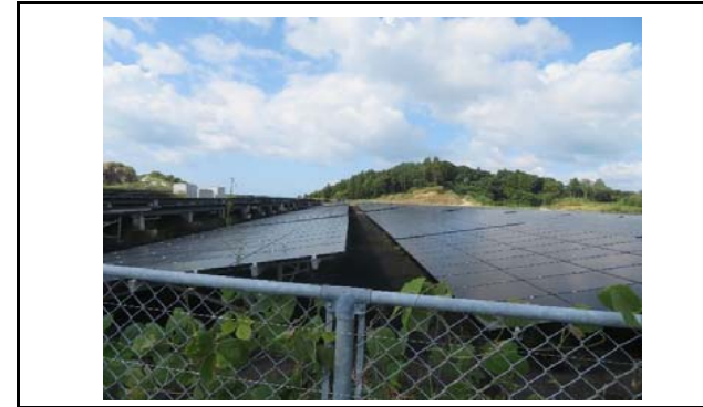
写真3 盛土側方境界部の状況(変状なし)
