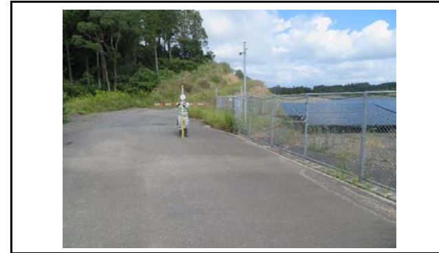
写真3 盛土側方境界部の状況(変状なし)
