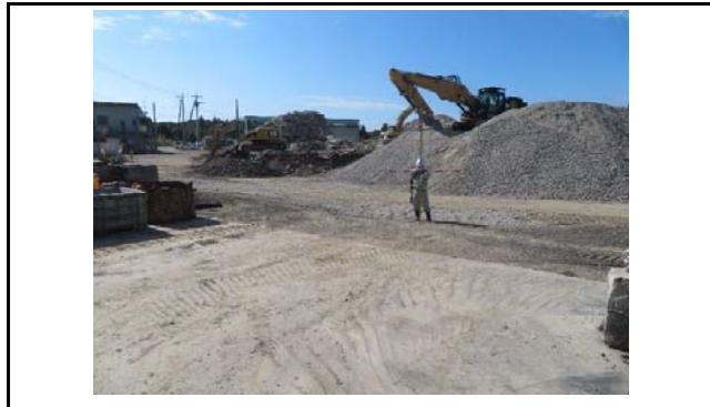
写真5 盛土末端部の状況
