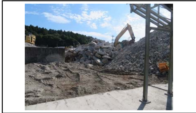
写真1 盛土頭部の状況(変状なし)
