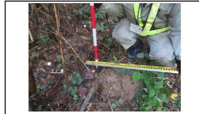
写真7 盛土のり面小段の排水施設 土砂堆積により排水機能が低下している
