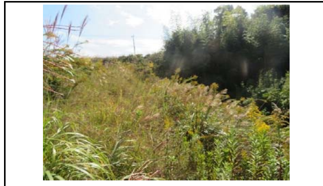
写真8 盛土のり面の状況(変状なし)
