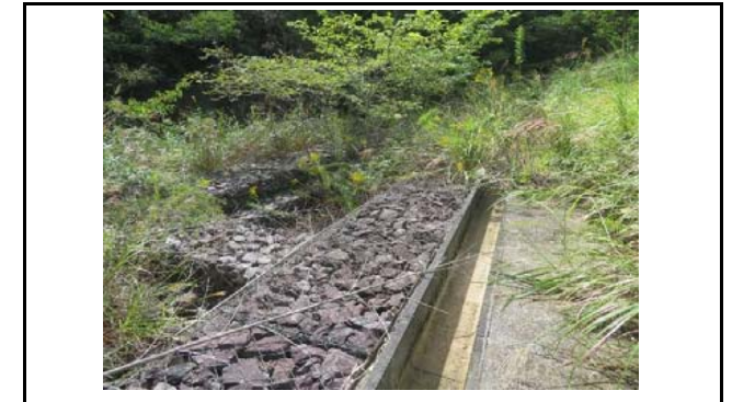
写真8 盛土のり面下方の排水施設とフトン籠(変状なし)
