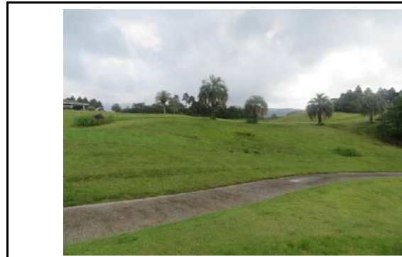
写真7 盛土内の状況(変状なし)
