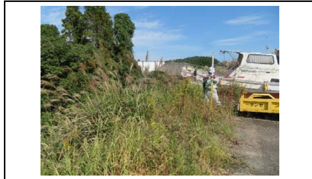
写真4 盛土側方境界部の状況(変状なし)
