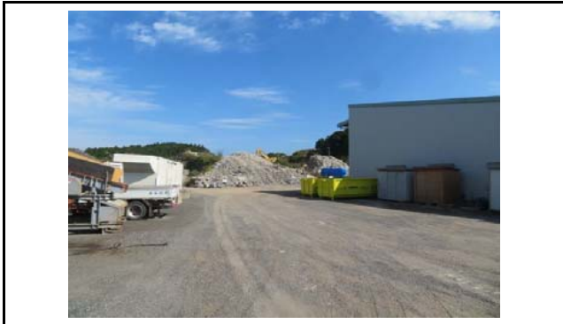
写真3 盛土内の状況(変状なし)
