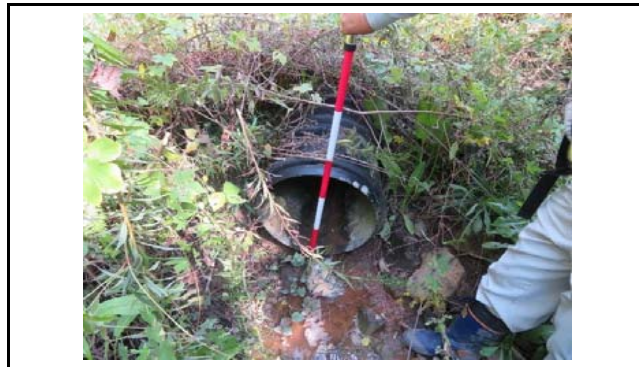
写真10 盛土末端部の排水施設状況(変状なし)
