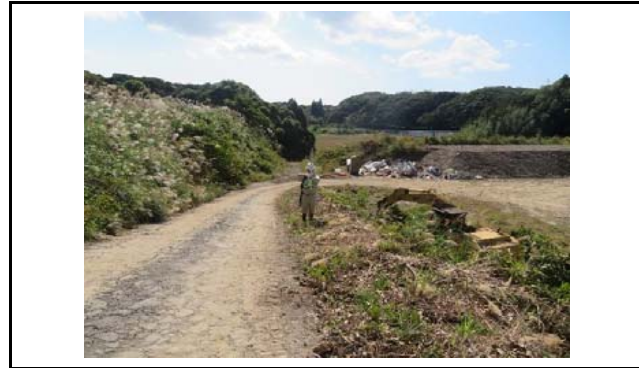
写真3 盛土側方境界部の状況(変状なし)
