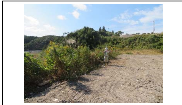
写真6 末端盛土のり面上端部(変状なし)
