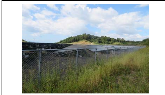
写真1 盛土頭部の状況(変状なし)
