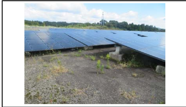
写真1 盛土頭部の状況(変状なし)
