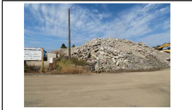
写真1 盛土頭部の状況(変状なし)
