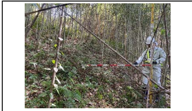
写真5 盛土のり面の状況(変状なし)
