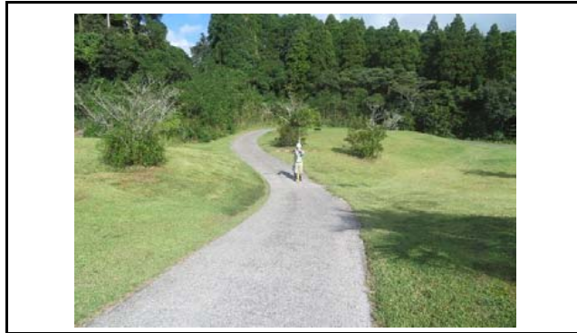
写真1 盛土頭部の状況(変状なし)
