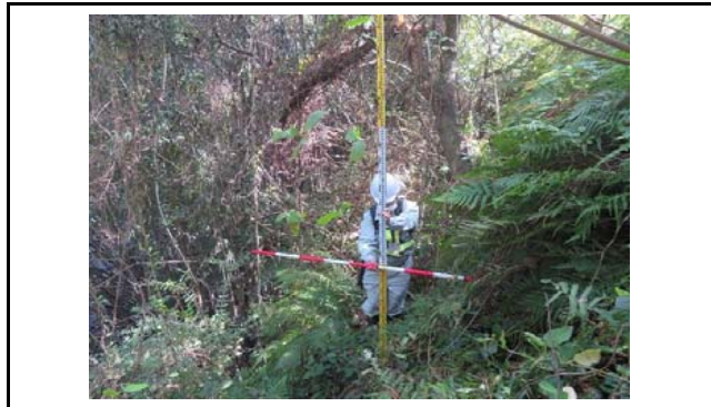
写真5 盛土のり面の状況(変状なし)
