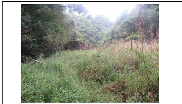
写真9 盛土下方の状況(えん堤の堆砂域)
