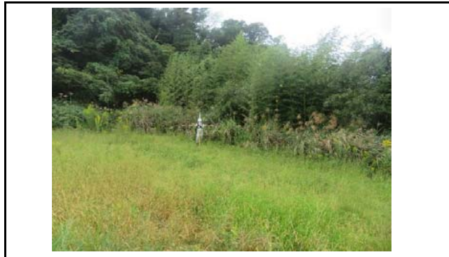
写真5 末端盛土のり面の上部(変状なし)
