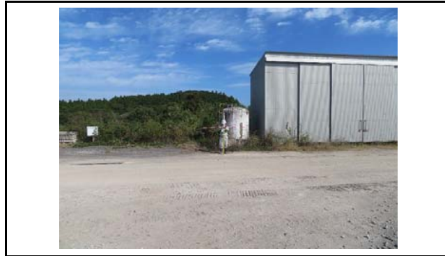
写真2 盛土側方境界部の状況(変状なし)
