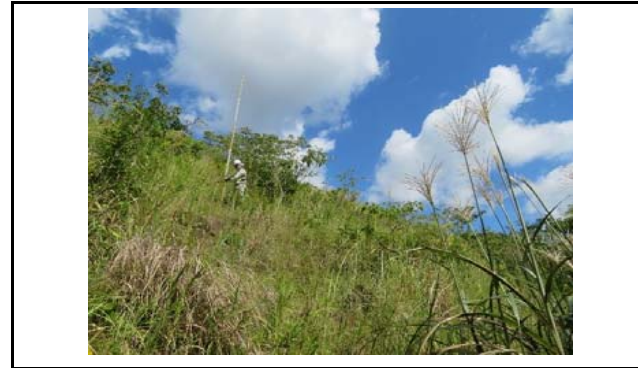
写真4 盛土のり面の状況(変状なし)
