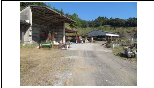
写真1 盛土頭部の状況(変状なし)
