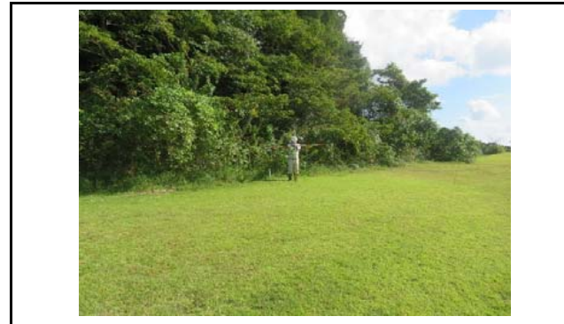
写真6 盛土側方境界部の状況(変状なし)
