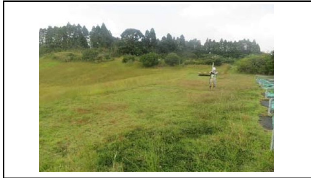
写真1 盛土頭部の状況(変状なし)
