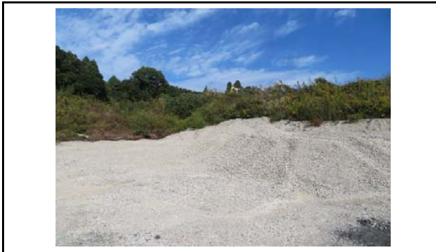
写真7 盛土内の状況(変状なし)
