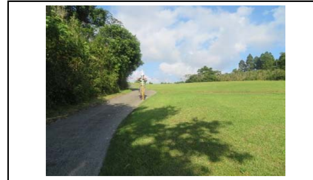
写真3 盛土側方境界部の状況(変状なし)
