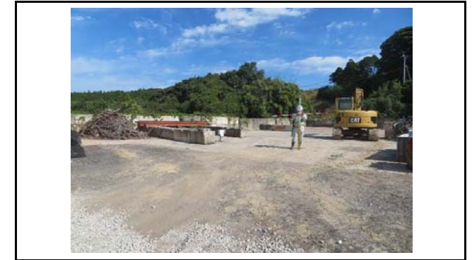
写真4 盛土側方境界部の状況(変状なし)
