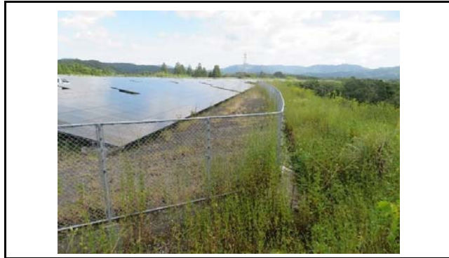
写真1 盛土内の状況(変状なし)
