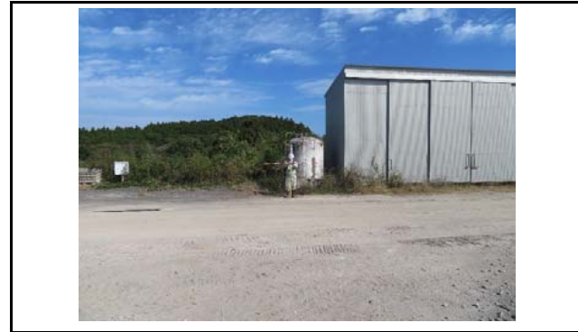
写真2 盛土側方境界部の状況(変状なし)
