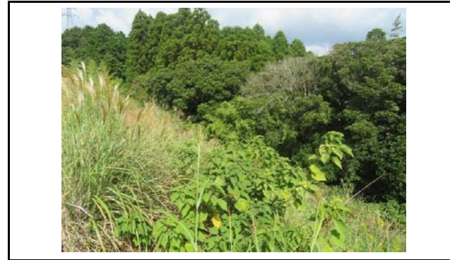
写真2 盛土側方境界部の状況(変状なし)
