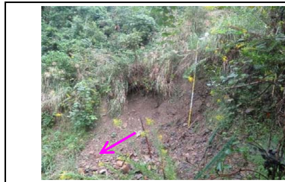
写真11 盛土のり面2段目の状況 2段目のり面の小段付近から崩壊が確認される
