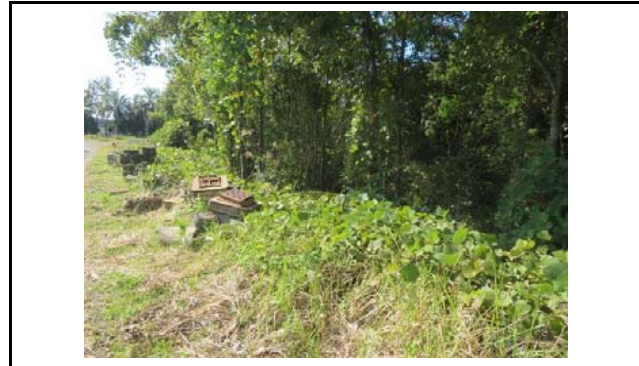
写真3 盛土側方境界部の状況(変状なし)
