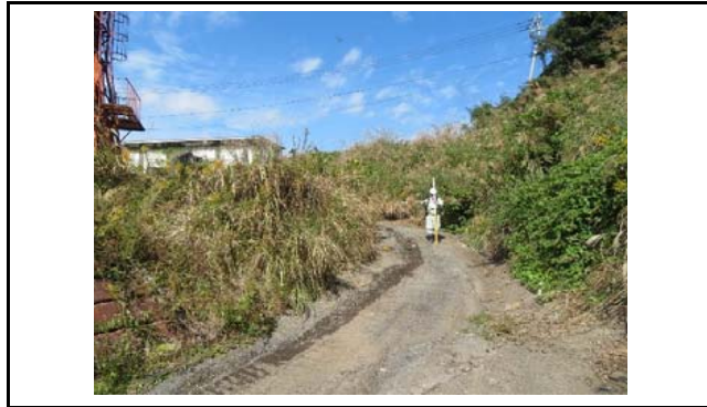
写真1 盛土頭部の状況(変状なし)
