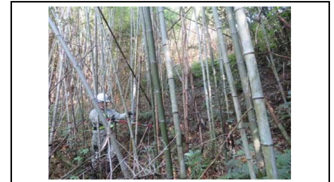
写真8 盛土のり面の状況(変状なし)
