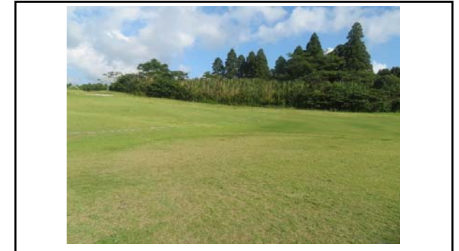
写真4 盛土側方境界部の状況(変状なし)
