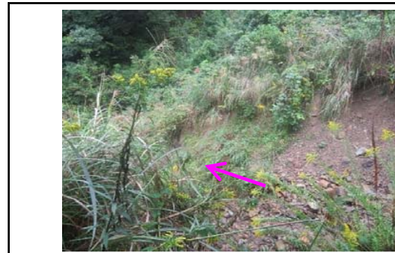
写真12 盛土のり面1段目の状況 2段目のり面(写真11)から末端まで連続して崩壊
