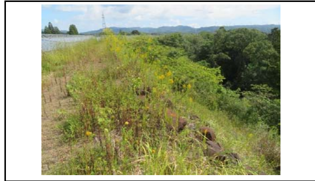
写真3 盛土頭部の状況(変状なし)
