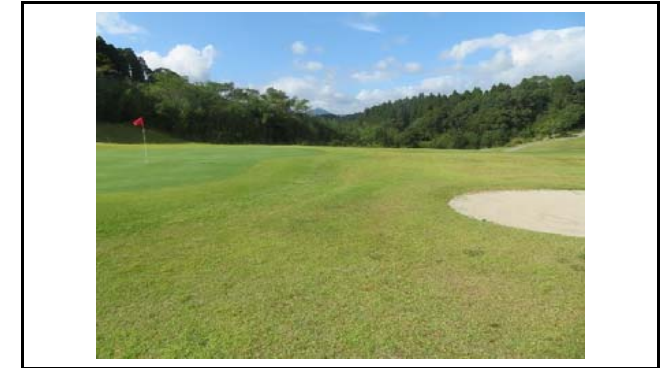
写真4 盛土側方境界部の状況(変状なし)
