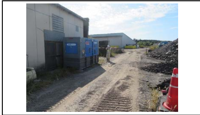
写真1 盛土頭部の状況(変状なし)
