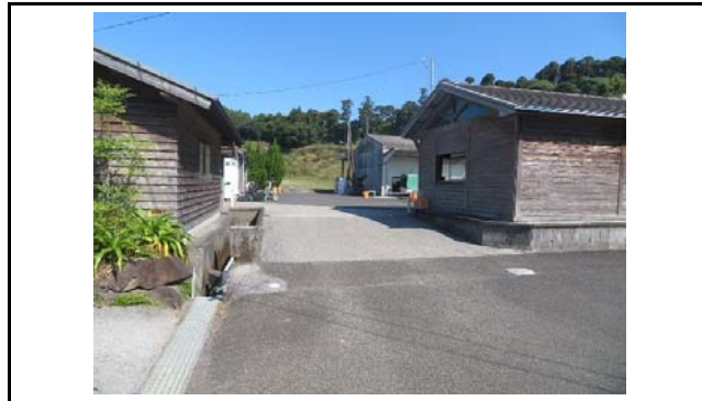
写真6 盛土内の状況(変状なし)
