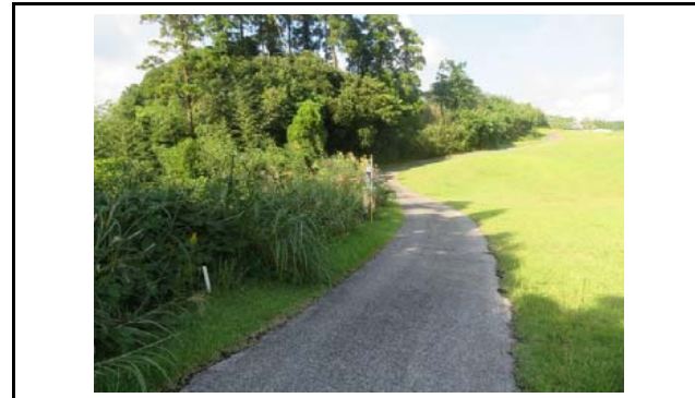
写真6 末端盛土のり面上端部(変状なし)
