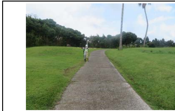
写真6 盛土側方境界部の状況(変状なし)
