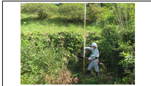
写真11 盛土のり面末端部の石積工の状況(変状なし)
