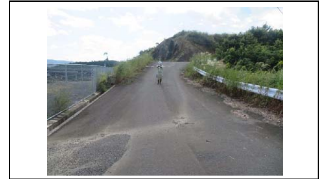
写真4 盛土側方境界部の状況(変状なし)
