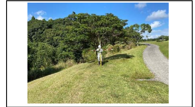
写真4 末端盛土のり面上端部の状況(変状なし)
