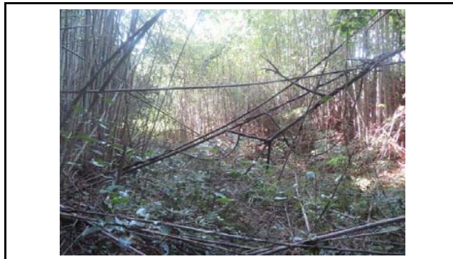
写真9 盛土のり面下方の状況
