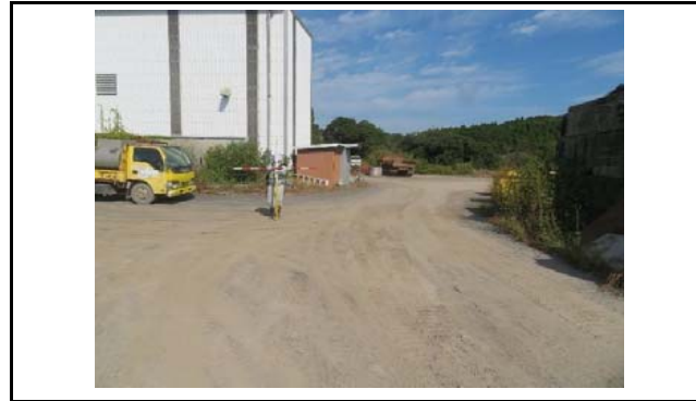
写真3 盛土側方境界部の状況(変状なし)
