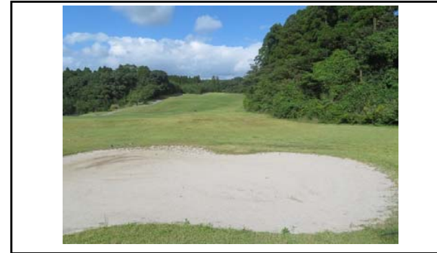
写真3 盛土側方境界部の状況(変状なし)
