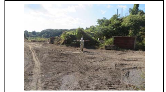
写真4 盛土末端部の状況(変状なし)
