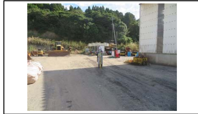
写真4 盛土側方境界部の状況(変状なし)
