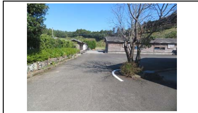
写真7 盛土側方境界部の状況(変状なし)
