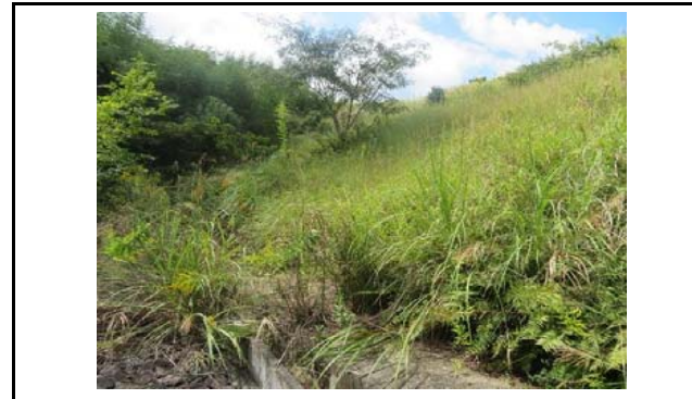
写真6 盛土のり面の状況(変状なし)
