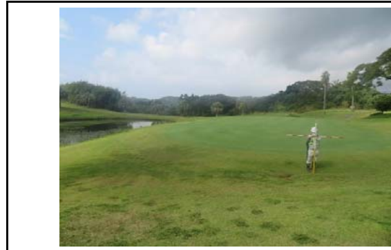
写真3 盛土内の状況(変状なし)
