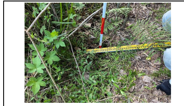
写真6 盛土のり面小段の排水施設の状況(変状なし)
