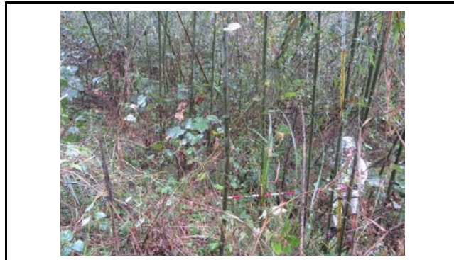
写真6 盛土のり面の状況(変状なし)
