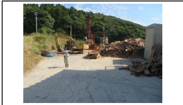
写真5 盛土側方境界部の状況(変状なし)
