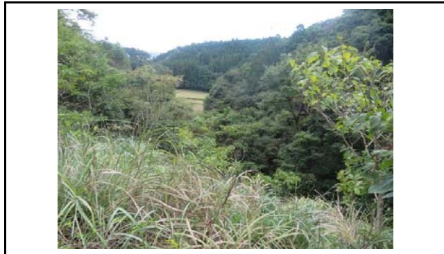
写真5 盛土のり面の状況(変状なし)
