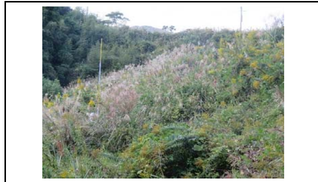
写真7 盛土のり面の状況(変状なし)
