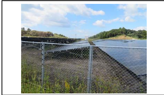
写真1 盛土頭部の状況(変状なし)
