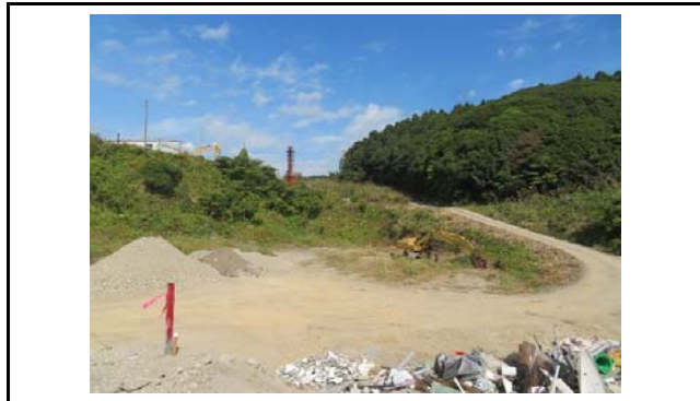
写真5 盛土内の状況(変状なし)
