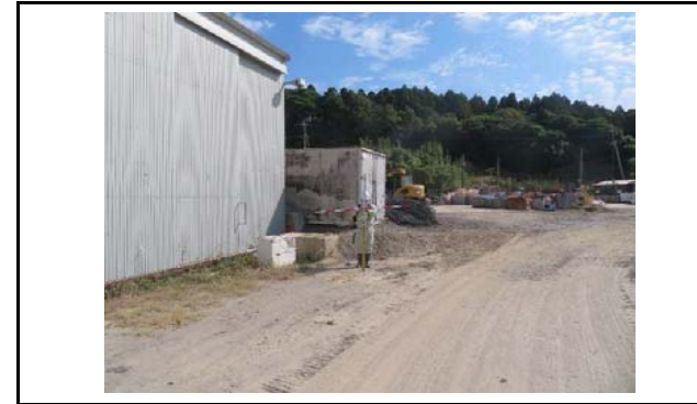
写真3 末端盛土のり面上端部(変状なし)
