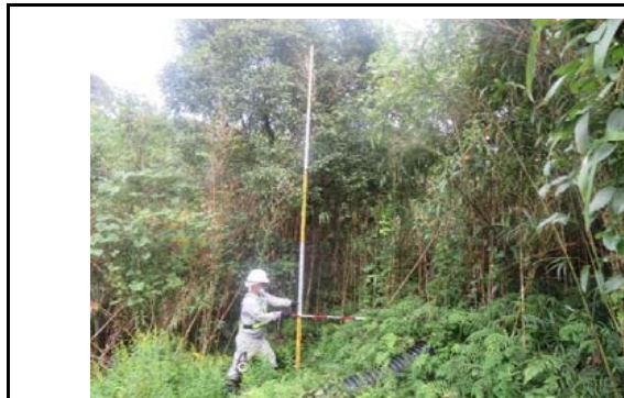
写真9 盛土のり面(3段目)の状況(変状なし)
