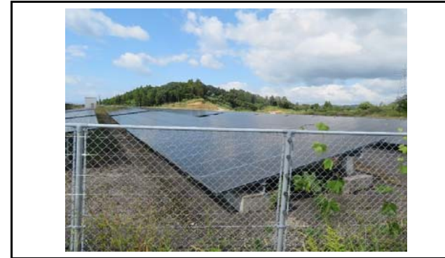
写真3 盛土側方境界部の状況(変状なし)
