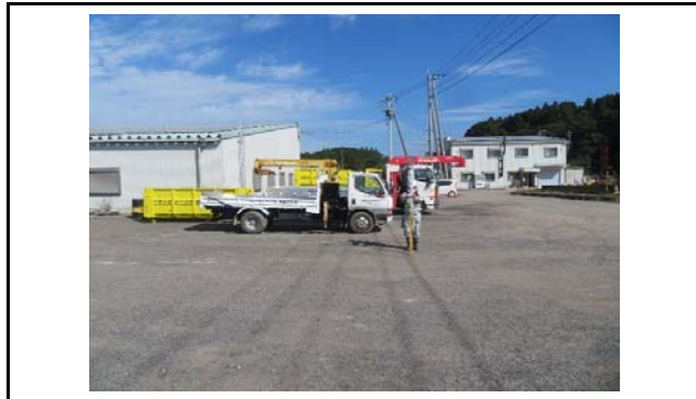
写真5 盛土側方境界部の状況(変状なし)
