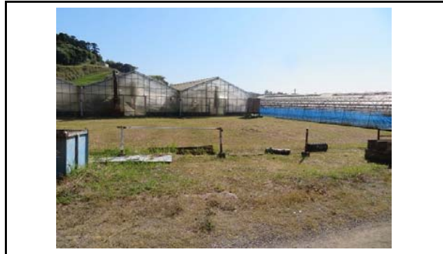
写真2 盛土内の状況(変状なし)
