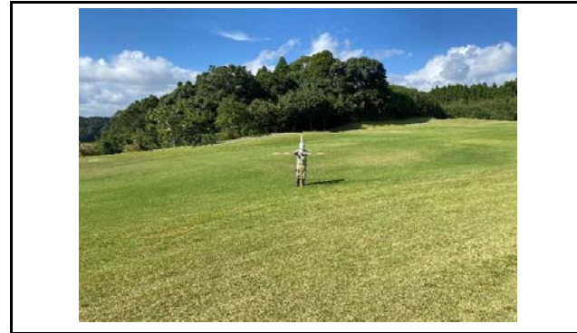
写真2 盛土側方境界部の状況(変状なし)
