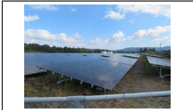
写真5 盛土側方境界部の状況(変状なし)
