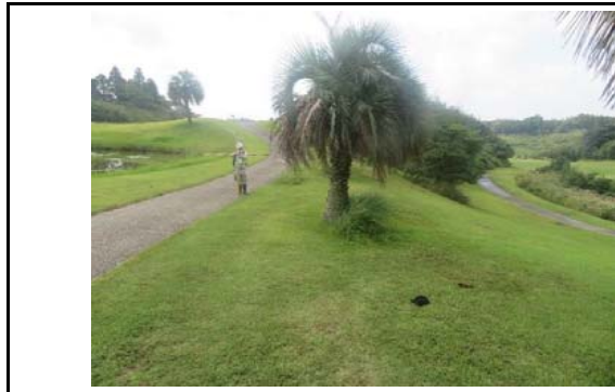
写真5 盛土内の状況(変状なし)
