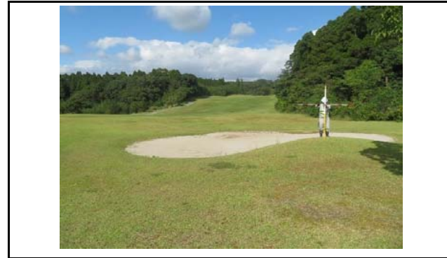
写真2 盛土内の状況(変状なし)
