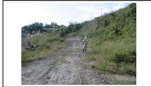
写真4 盛土側方境界部の状況(変状なし)
