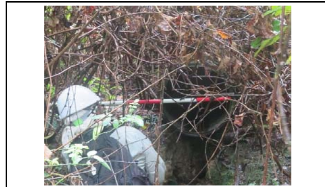
写真8 盛土のり面末端部の排水施設状況(変状なし)
