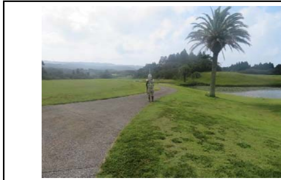
写真1 盛土頭部の状況(変状なし)
