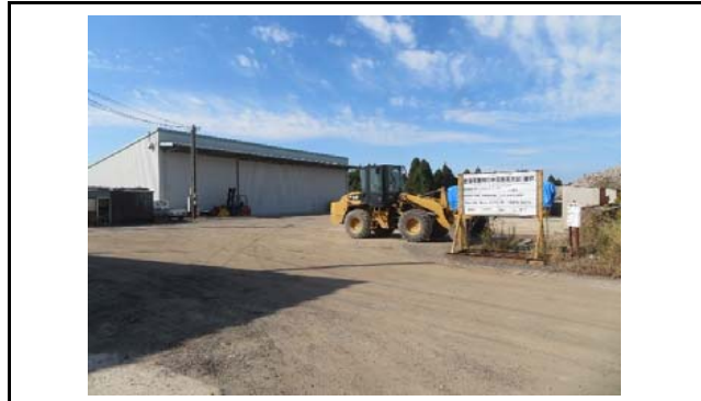
写真2 盛土内の状況(変状なし)
