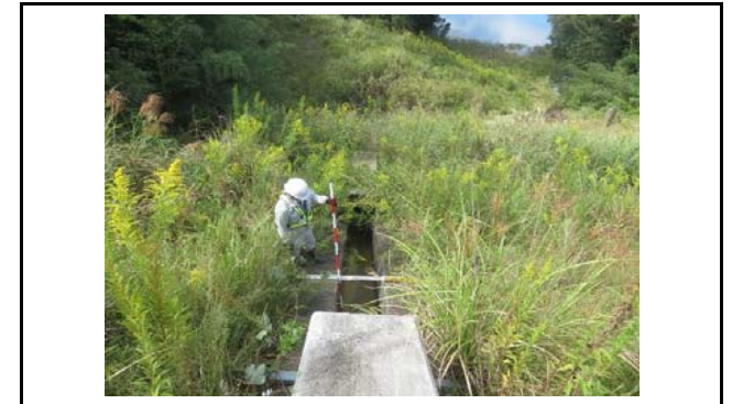
写真8 のり面排水の状況(変状なし)
