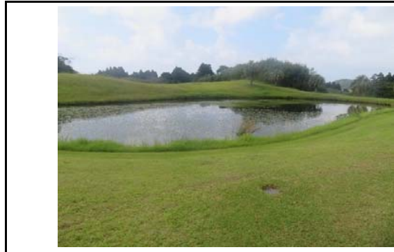
写真2 盛土頭部の状況(変状なし)
