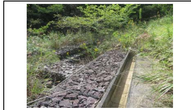
写真6 盛土のり面下方の排水施設とフン籠(変状なし)
