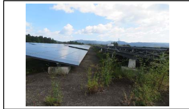
写真2 盛土内の状況(変状なし)
