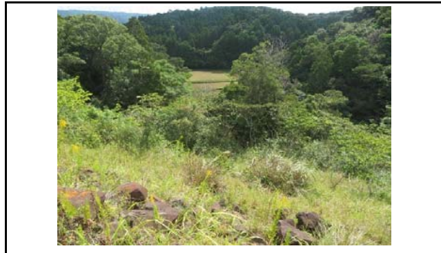
写真6 盛土のり面の状況(変状なし)
