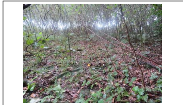
写真7 盛土のり面の状況(変状なし)
