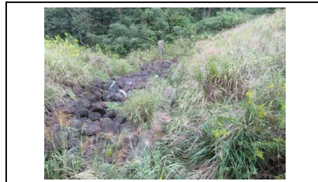
写真10 盛土末端部の捨て石状況(変状なし)
