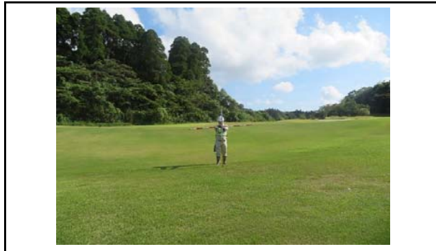
写真5 盛土末端部(29-1との境界)の状況(変状なし)
