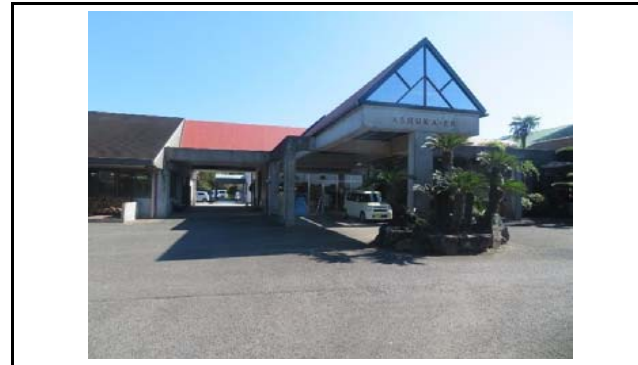
写真8 盛土側方境界部の状況(変状なし)
