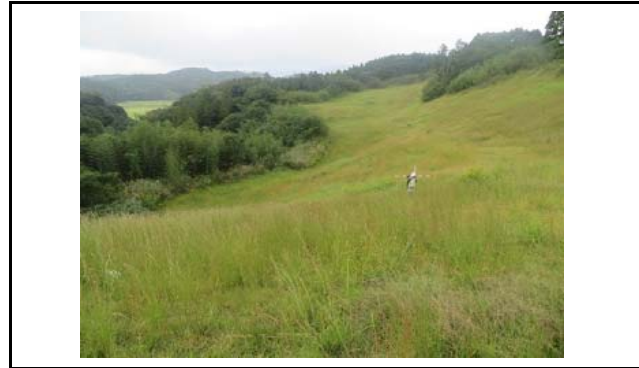
写真3 盛土内の状況(変状なし)
