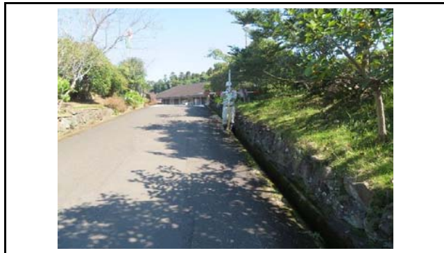
写真9 盛土側方境界部の状況(変状なし)
