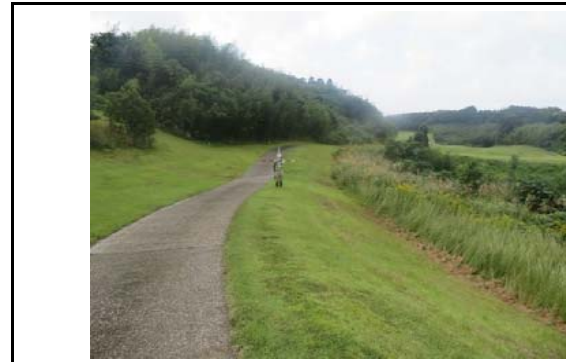
写真8 末端盛土のり面の上部付近(変状なし)
