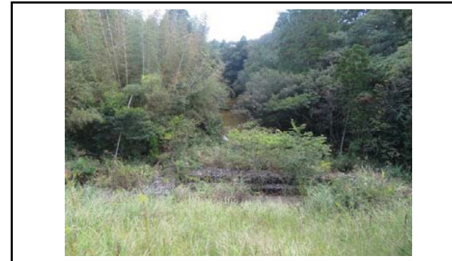
写真7 盛土下方のため池状況
