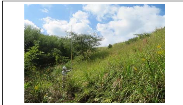
写真5 盛土のり面の状況(変状なし)
