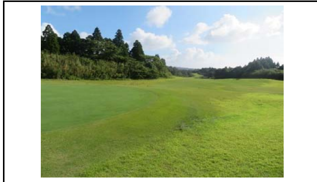
写真1 盛土内の全景(変状なし)
