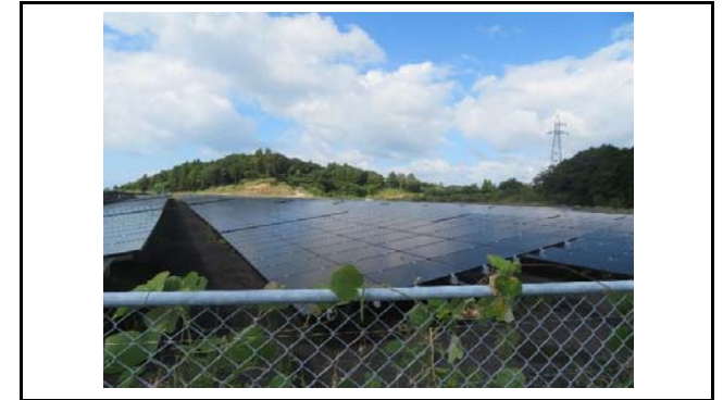
写真4 盛土内の状況(変状なし)
