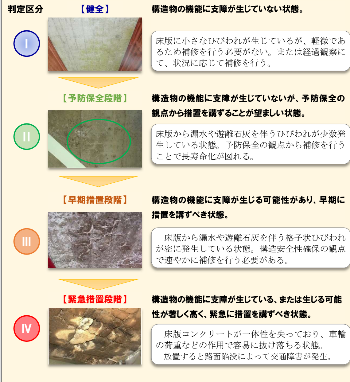
図 15 橋の健全度の事例
