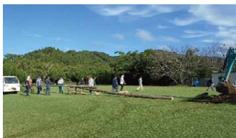
柱松を立て込む「穴堀」
