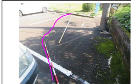
写真6 宅地内の駐車場に発生した弧状のクラック
