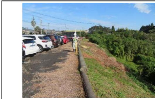
写真5 末端盛土のり面の上部(変状なし)
