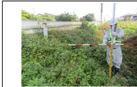
写真11 盛土のり面の状況(変状なし)
