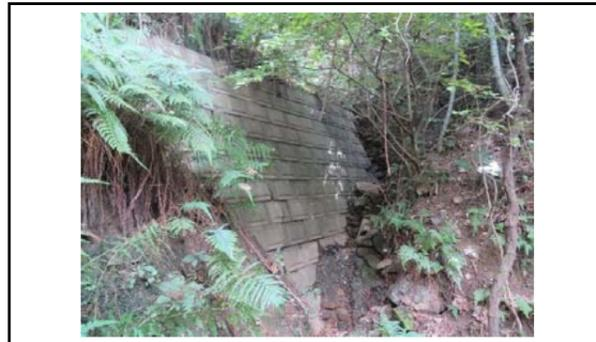
写真11 2段目ブロック積擁壁側部のガリ浸食状況
