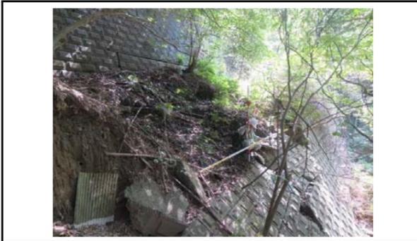
写真9 写真8背後の崩壊状況(W=7m)
