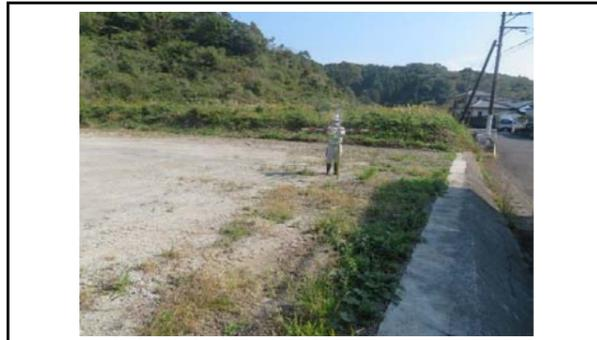
写真6 盛土末端部の状況(変状なし)
