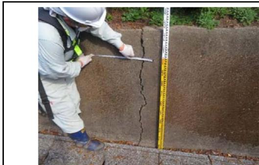
写真9 盛土側方境界部の擁壁の変状
