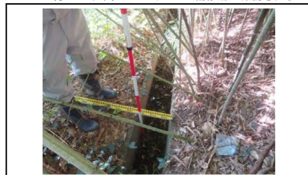
写真15 盛土のり面小段の排水施設状況(変状なし)
