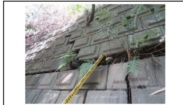
写真10 2段目ブロック積擁壁の開口沈下状況
