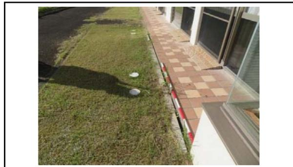
写真5 盛土内の宅盤の開口と沈下状況
