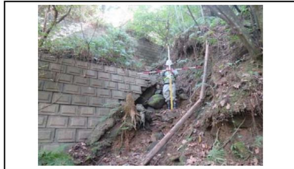
写真7 盛土擁壁側部のガリ浸食及び洗堀状況
