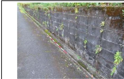
写真5 盛土側方境界部の状況(排水施設の沈下)
