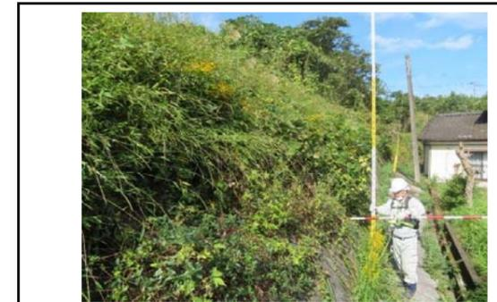
写真12 盛土のり面末端部の井桁擁壁の状況(変状なし)
