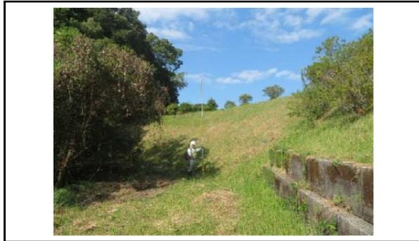
写真1 ひな壇部の盛土のり面(変状なし)
