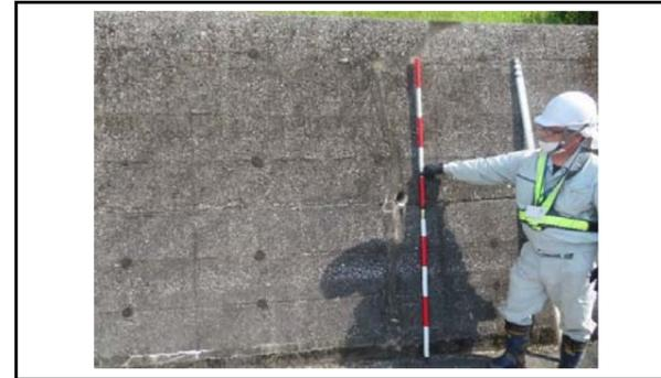
写真4 ひな壇擁壁の縦クラックの補修跡
