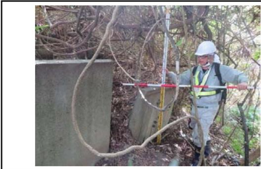
写真15 ブロック積擁壁上部のL型擁壁の傾倒
