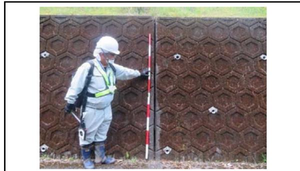
写真9 盛土側方境界部付近のブロック積擁壁の目地の開口
