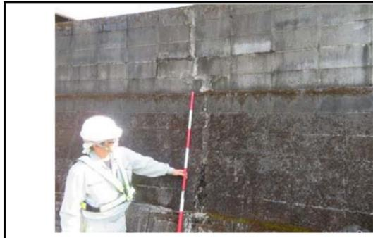
写真5 盛土内の空洞ブロックの補修跡
