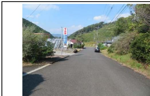
写真13 盛土末端部の状況(変状なし)
