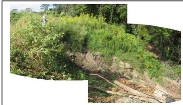
写真5 末端盛土のり面の上部崩壊跡
