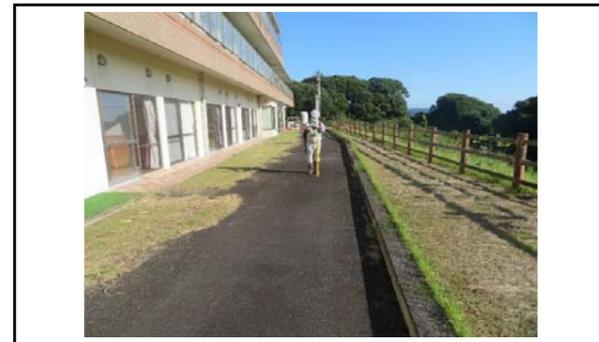
写真8 末端盛土のり面の先端部の状況(変状なし)
