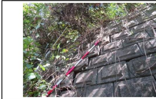
写真13 2段目ブロック積擁壁の開口亀裂と押し出し状況
