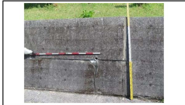
写真5 ひな壇擁壁の縦クラックの補修跡と打ち継ぎ目部分の押し出し状況
