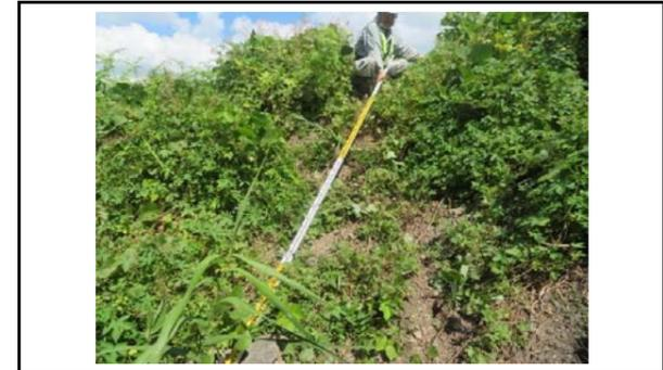
写真16 盛土のり面の肌落ち状況
