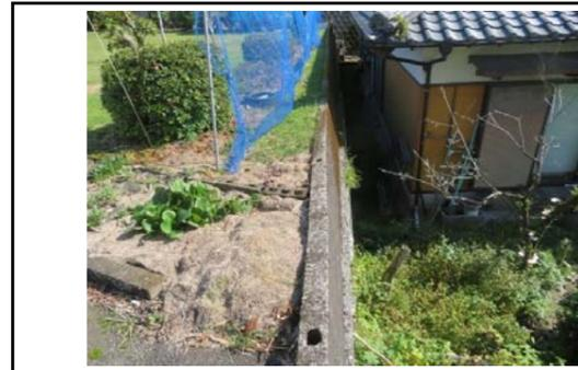
写真8 宅地背後のコンクリート擁壁の孕み出し状況
