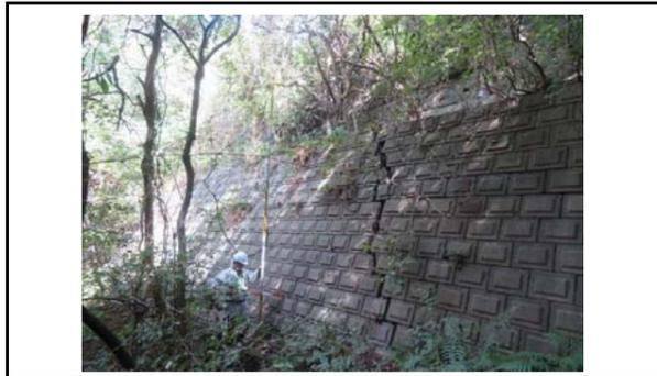
写真5 盛土末端擁壁の変状状況
