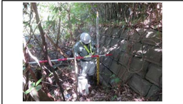
写真13 3段目ブロック積擁壁の状況(変状なし)
