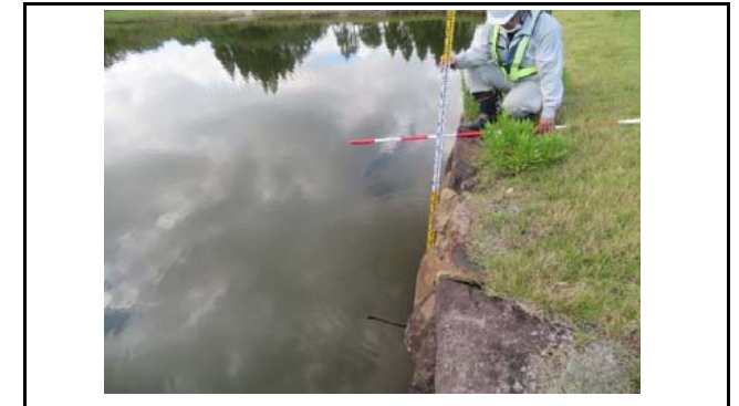
写真8 盛土末端石積擁壁の状況(変状なし)
