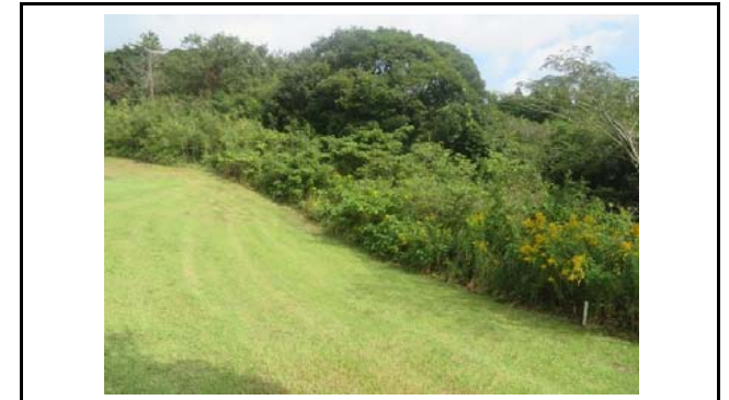
写真8 末端盛土のり面上端部(変状なし)
