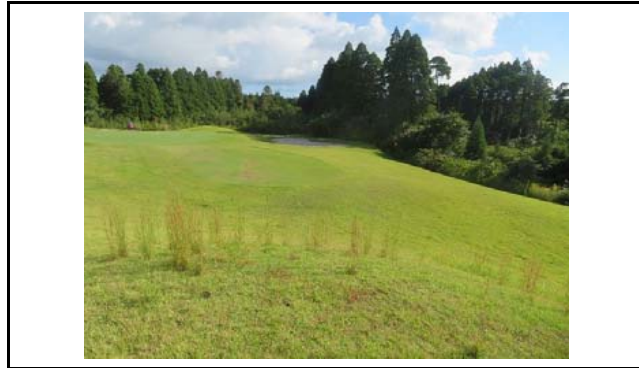
写真2 盛土側方境界部の状況(変状なし)
