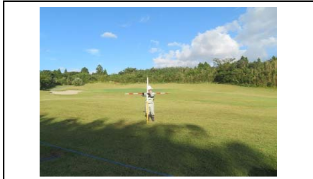
写真1 盛土頭部の状況(変状なし)
