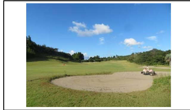
写真4 盛土側方境界部の状況(変状なし)
