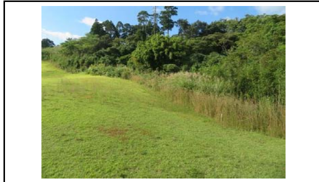
写真2 盛土側方境界部の状況(変状なし)
