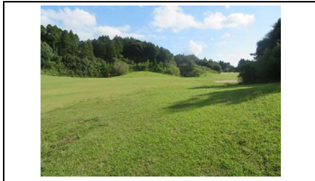
写真5 盛土側方境界部の状況(変状なし)
