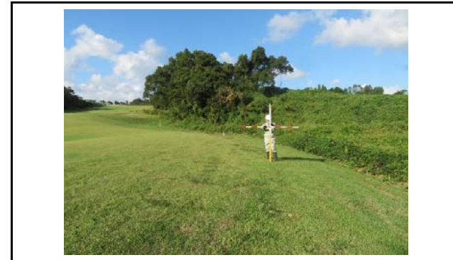
写真7 末端盛土のり面上端部(変状なし)
