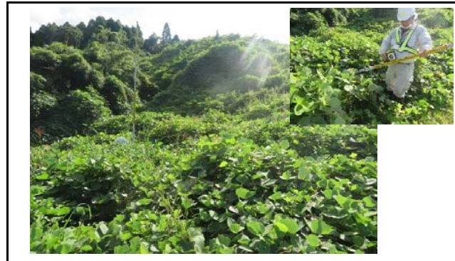
写真7 盛土のり面の状況(変状なし)
