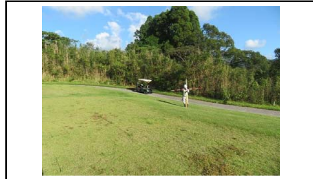
写真2 盛土側方境界部の状況(変状なし)
