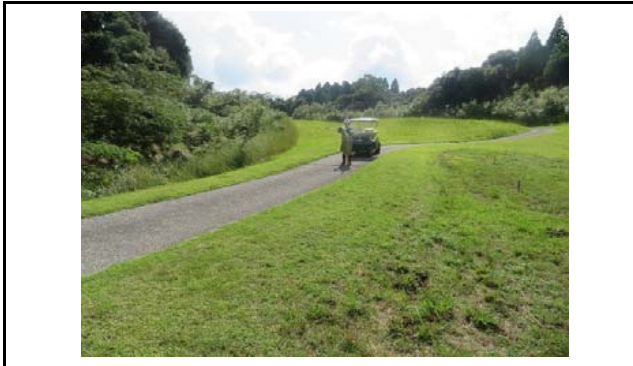
写真3 盛土側方境界部の状況(変状なし)
