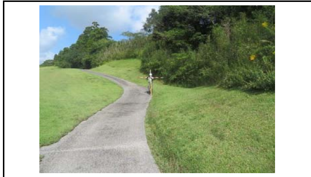
写真1 盛土頭部の状況(変状なし)
