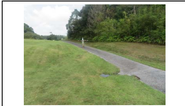
写真5 盛土側方境界部の状況(変状なし)
