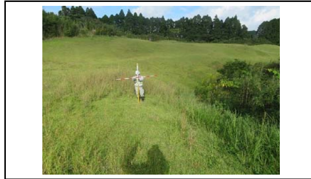
写真3 末端盛土のり面の上部(変状なし)
