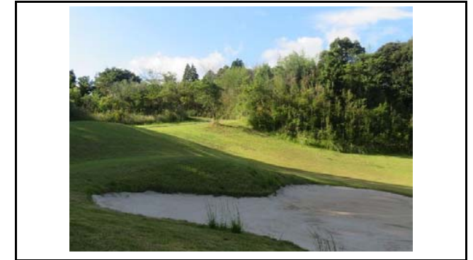
写真4 盛土側方境界部の状況(変状なし)
