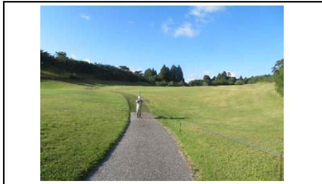
写真5 盛土末端部の状況
