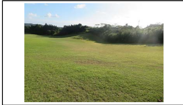
写真2 盛土内の状況(変状なし)
