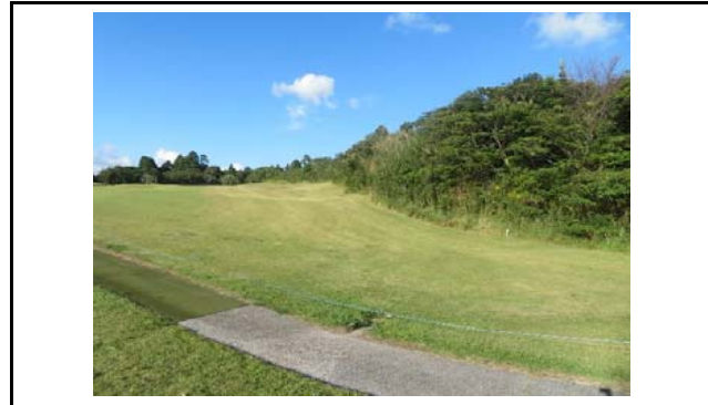
写真3 盛土側方境界部の状況(変状なし)
