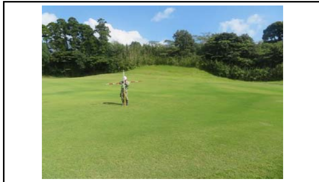
写真5 盛土末端部(31-4との境界)の状況(変状なし)
