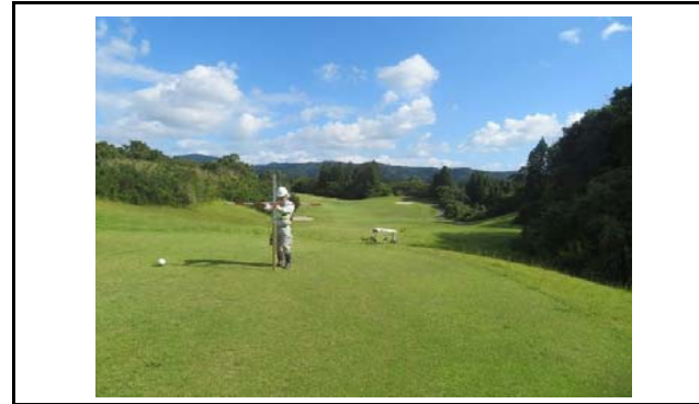
写真2 盛土内の状況(変状なし)
