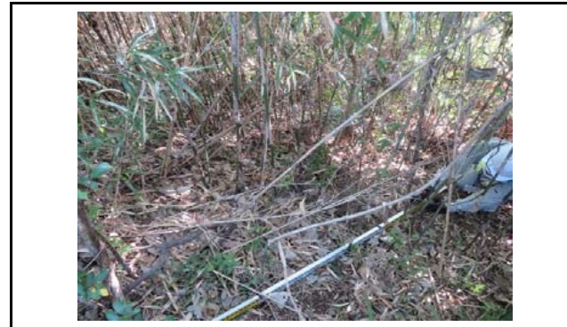
写真6 盛土のり面の状況(変状なし)
