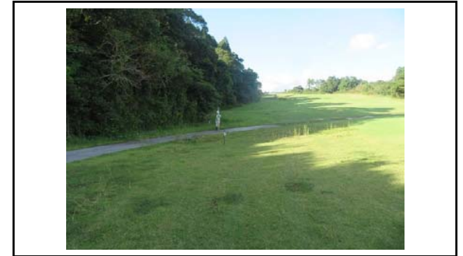
写真4 盛土側方境界部の状況(変状なし)
