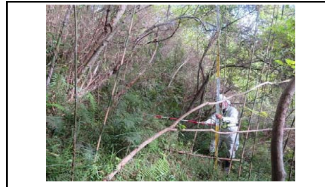
写真7 盛土のり面の状況(変状なし)
