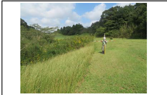
写真5 末端盛土のり面上端部(変状なし)
