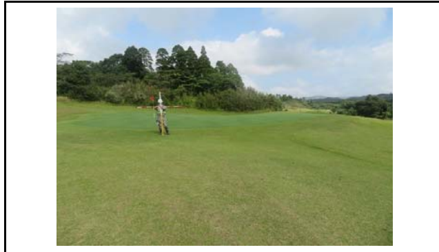
写真1 盛土頭部の状況(変状なし)
