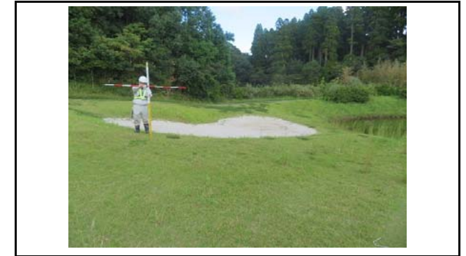
写真4 盛土側方境界部の状況(変状なし)
