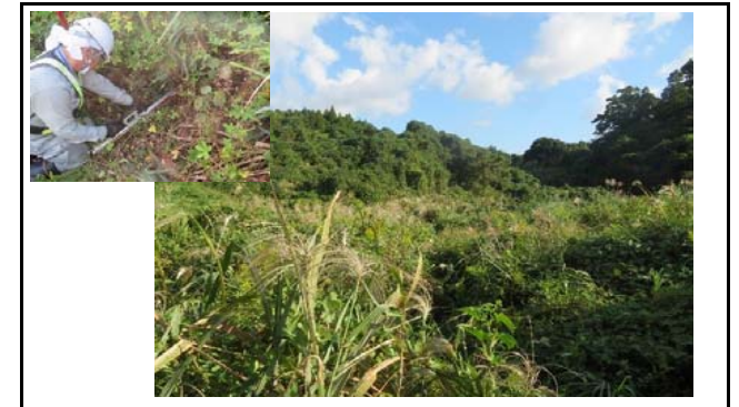
写真8 盛土のり面の状況(変状なし)
