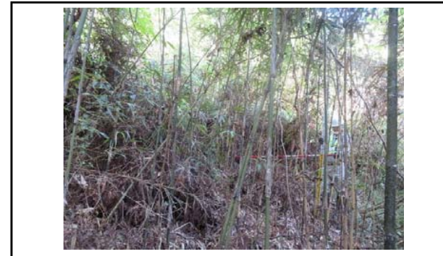
写真7 盛土のり面の状況(変状なし)
