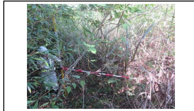
写真6 盛土のり面の状況(変状なし)
