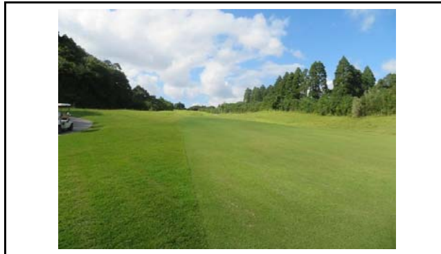
写真5 盛土内の全景(変状なし)
