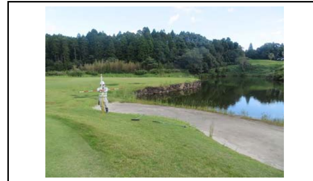
写真7 盛土内の状況(変状なし)
