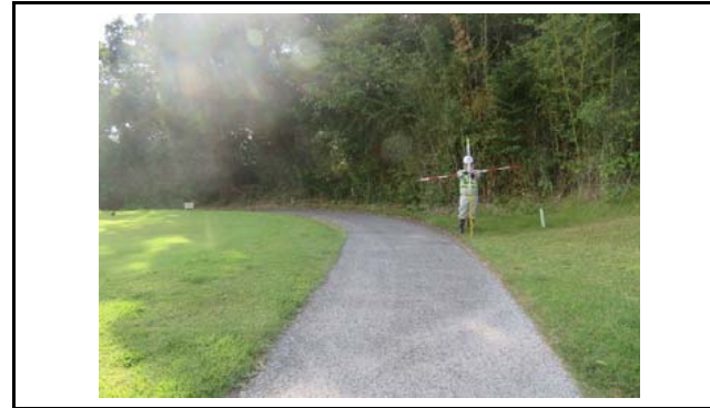
写真2 盛土側方境界部の状況(変状なし)
