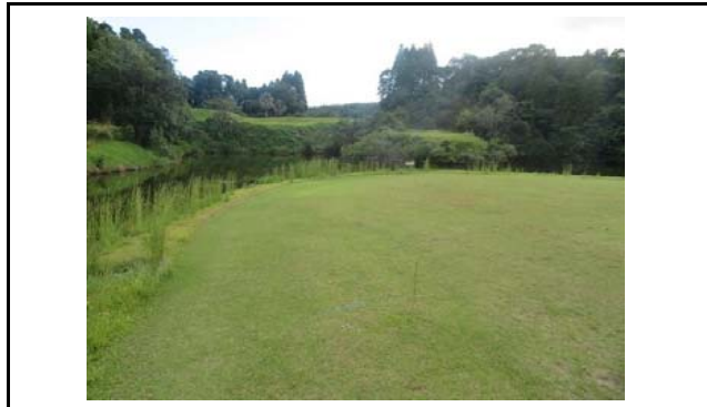
写真5 盛土内の状況(変状なし)
