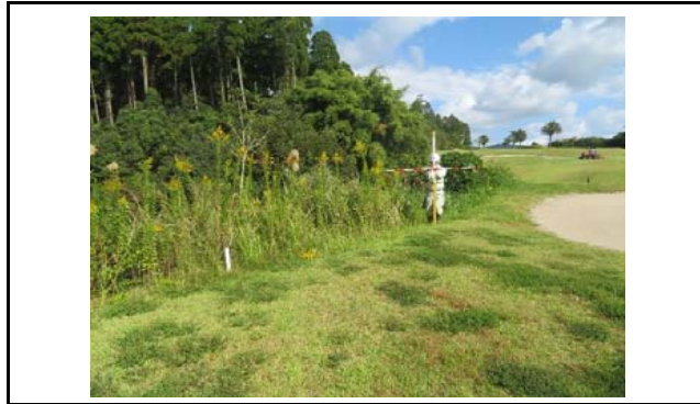
写真1 盛土頭部の状況(変状なし)
