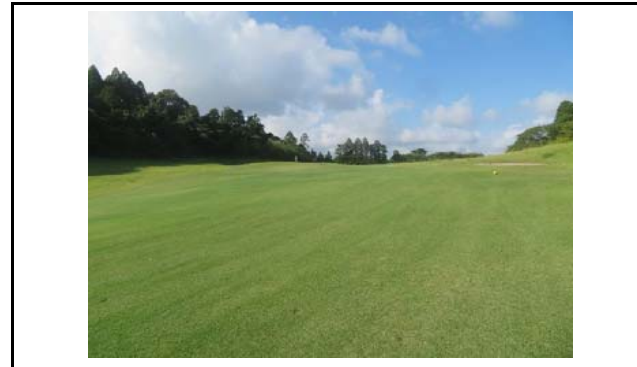
写真6 盛土内の全景(変状なし)
