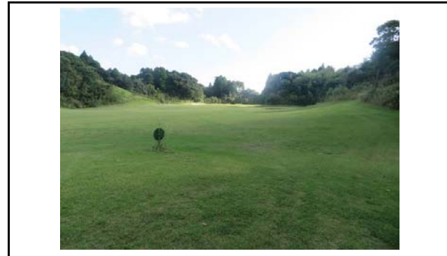
写真6 盛土側方境界部の状況(変状なし)
