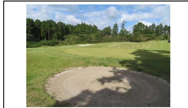
写真6 盛土内の状況(変状なし)
