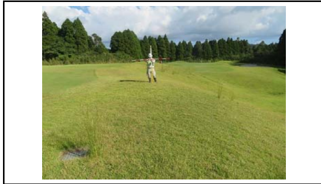
写真1 盛土頭部の状況(変状なし)
