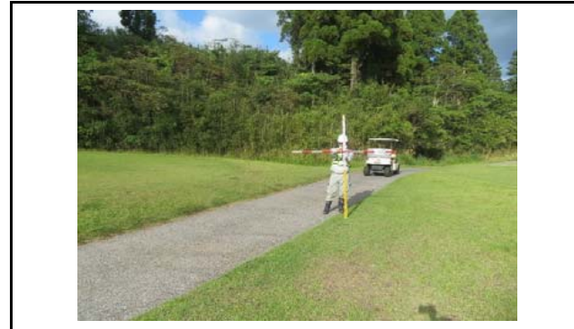
写真4 盛土側方境界部の状況(変状なし)
