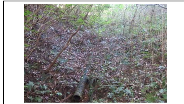
写真6 盛土のり面と末端部の排水施設状況(変状なし)
