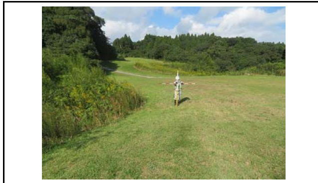
写真5 末端盛土のり面上端部(変状なし)
