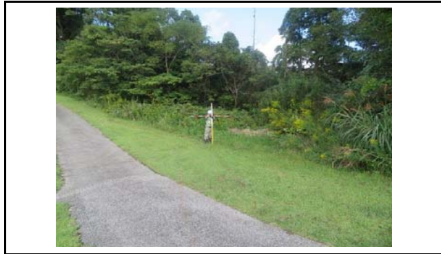
写真1 盛土頭部付近の状況(変状なし)
