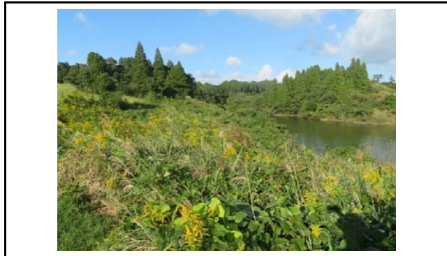
写真5 盛土側方境界部の状況(変状なし)
