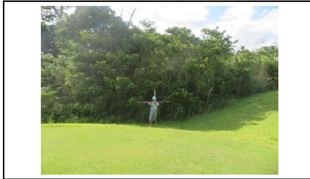
写真1 盛土頭部の状況(変状なし)
