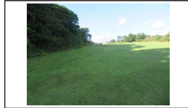
写真3 盛土内の状況(変状なし)
