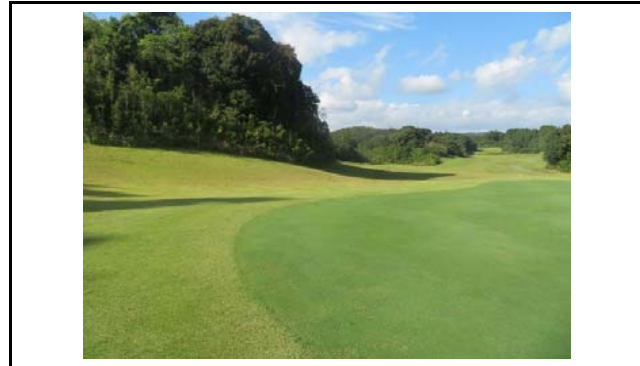
写真1 盛土頭部の状況(変状なし)
