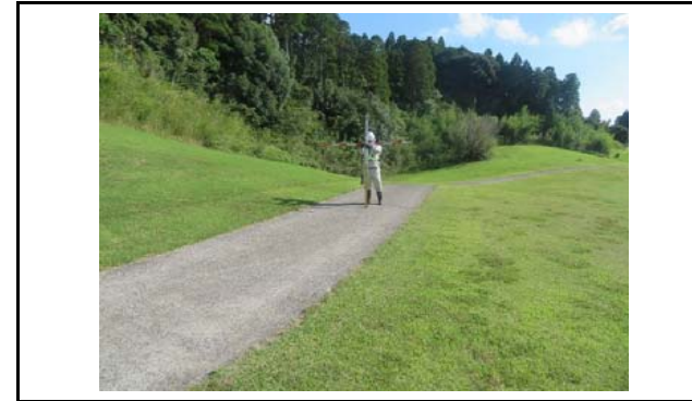
写真3 盛土側方境界部の状況(変状なし)
