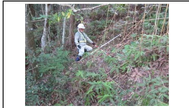
写真7 盛土のり面の肌落ち状況
