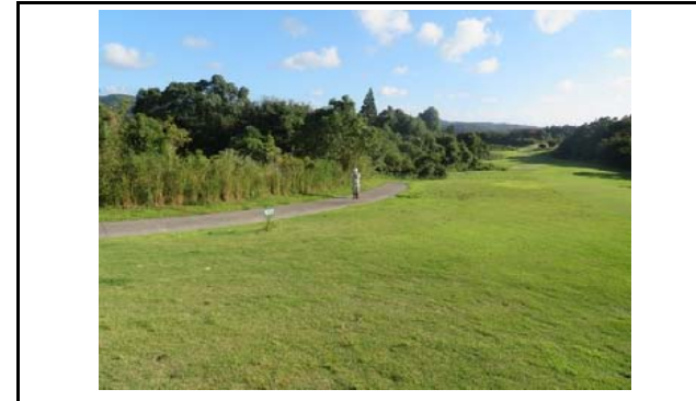
写真3 盛土側方境界部の状況(変状なし)
