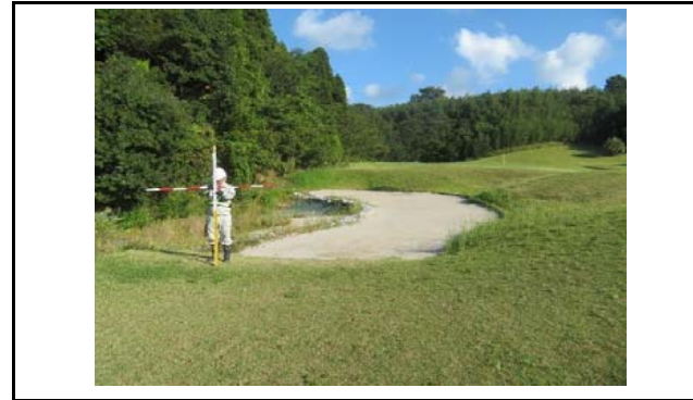
写真2 盛土側方境界部の状況(変状なし)
