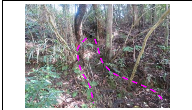
写真9 のり面1段目小段付近からの塩ビ排水の状況 排水下方に幅1m程度のガリ浸食あり
