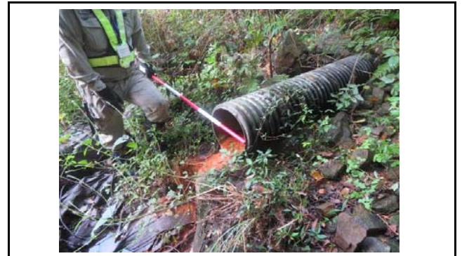
写真8 盛土のり面末端部の排水施設の状況(変状なし)
