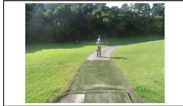
写真2 盛土側方境界部の状況(変状なし)
