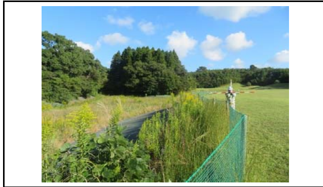
写真1 盛土頭部の状況(変状なし)
