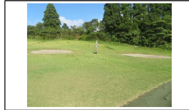
写真3 盛土側方境界部の状況(変状なし)
