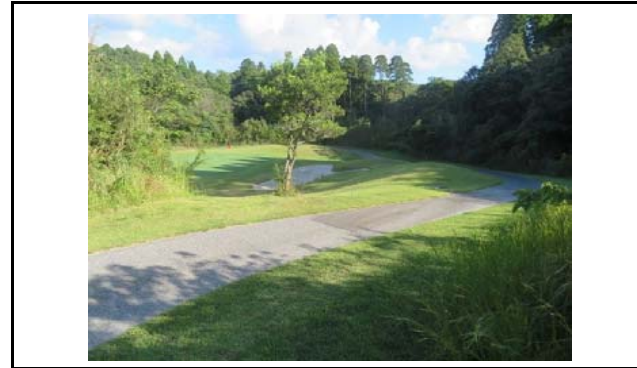
写真2 盛土内の状況(変状なし)
