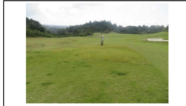
写真2 盛土内の状況(変状なし)
