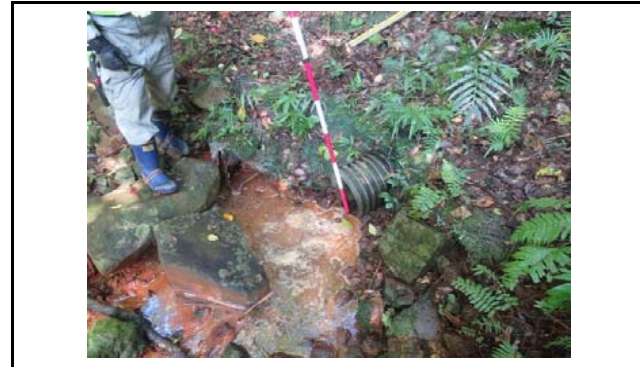
写真10 のり面末端部の排水施設状況(変状なし)
