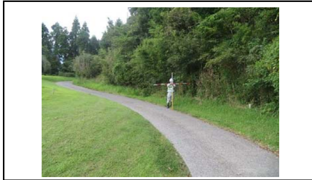
写真1 盛土頭部の状況(変状なし)
