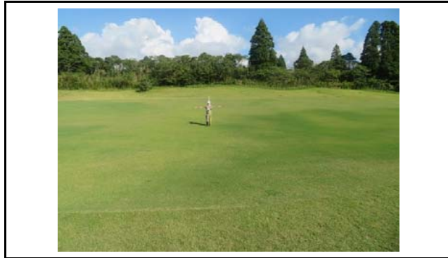
写真1 盛土頭部の状況(変状なし)
