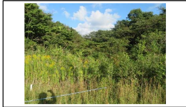
写真3 盛土内の状況(変状なし)
