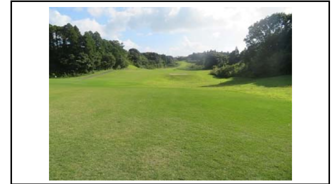
写真4 盛土内の状況(変状なし)
