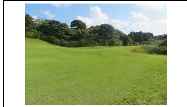
写真4 盛土側方境界部の状況(変状なし)
