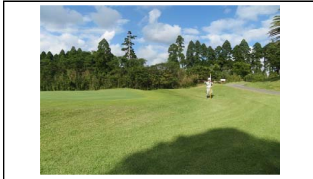
写真1 盛土頭部の状況(変状なし)
