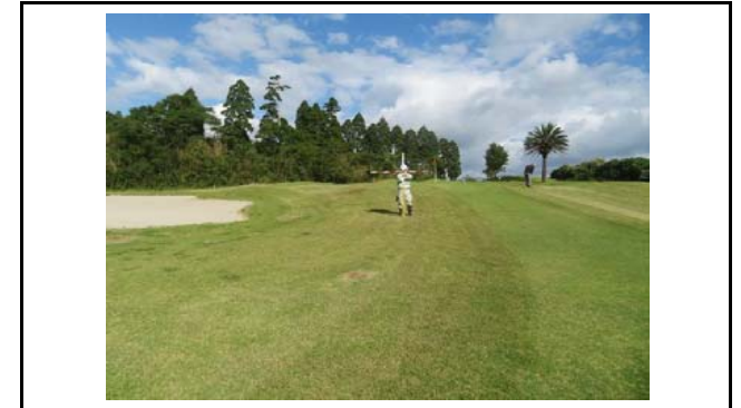
写真4 盛土内の状況(変状なし)
