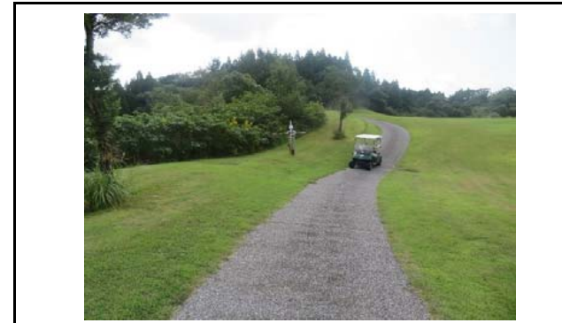
写真7 盛土側方境界部の状況(変状なし)
