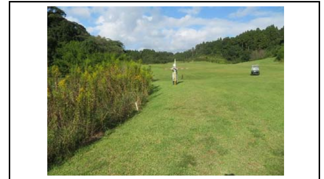
写真8 末端盛土のり面の上部(変状なし)
