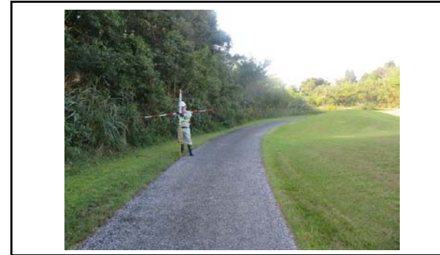
写真3 盛土側方境界部の状況(変状なし)
