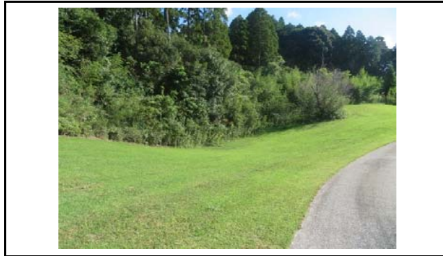
写真1 盛土頭部の状況(変状なし)
