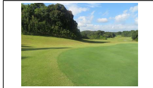
写真3 盛土側方境界部の状況(変状なし)
