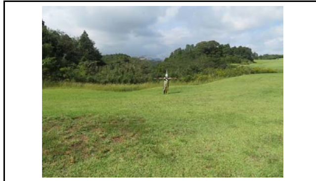
写真2 盛土内の状況(変状なし)
