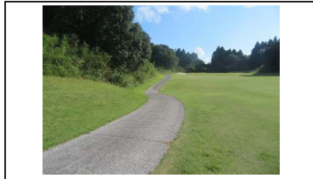
写真5 盛土側方境界部の状況(変状なし)
