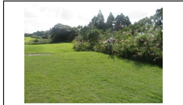
写真6 末端盛土のり面上端部(変状なし)
