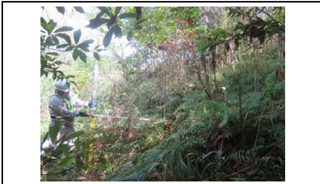
写真7 盛土のり面の状況(変状なし)
