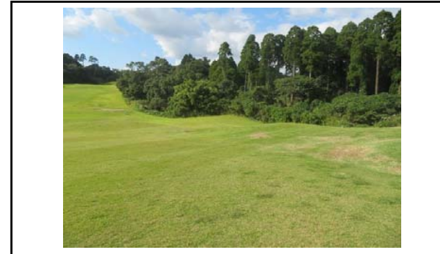
写真3 盛土側方境界部の状況(変状なし)
