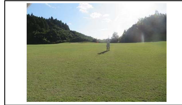
写真3 盛土内の状況(変状なし)
