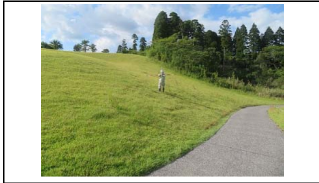
写真1 盛土頭部の状況(変状なし)
