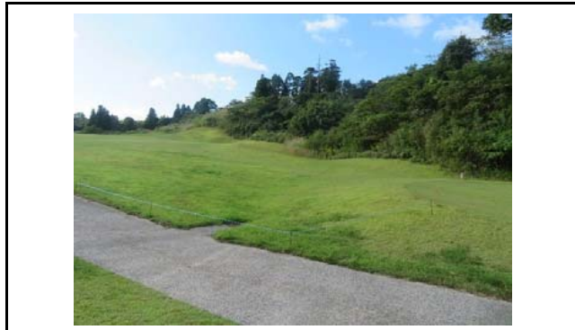
写真5 盛土内の全景(変状なし)
