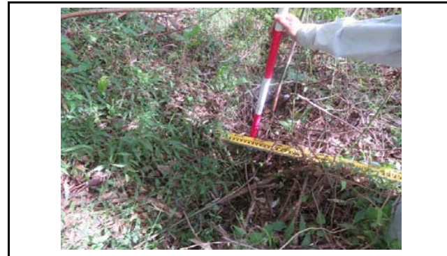
写真6 盛土のり面小段の排水施設状況(変状なし)
