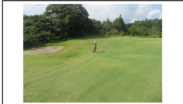
写真2 盛土側方境界部の状況(変状なし)
