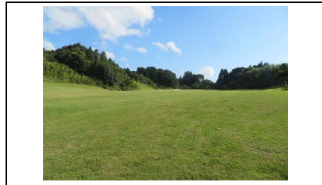
写真10 盛土内の状況(変状なし)
