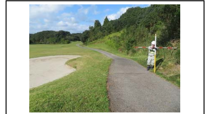
写真4 盛土側方境界部の状況(変状なし)
