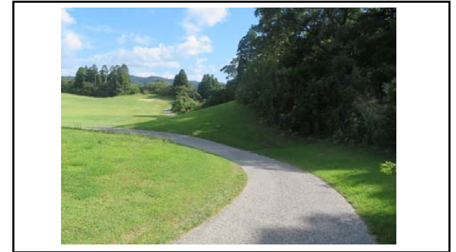
写真4 盛土側方境界部の状況(変状なし)
