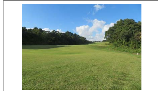
写真6 盛土内の状況(変状なし)
