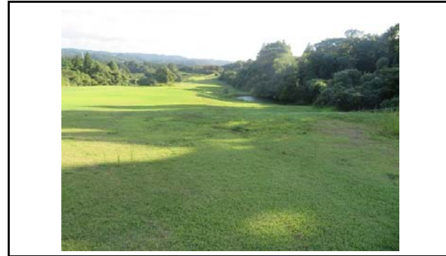
写真2 盛土内の状況(変状なし)
