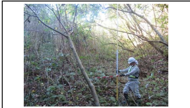
写真5 盛土のり面の状況(変状なし)
