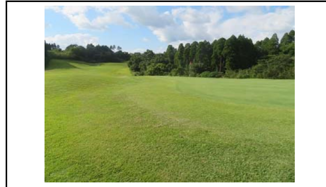
写真2 盛土内の状況(変状なし)
