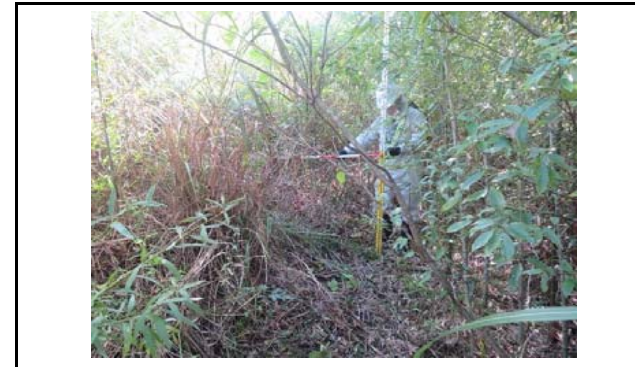
写真7 盛土のり面の状況(変状なし)
