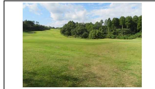
写真7 盛土内の状況(変状なし)
