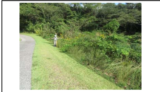
写真1 盛土頭部付近の状況(変状なし)
