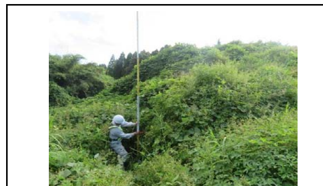
写真3 盛土のり面の状況(変状なし)
