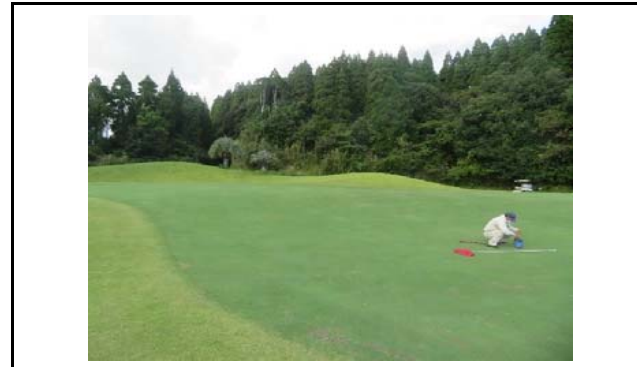
写真6 盛土内の状況(変状なし)
