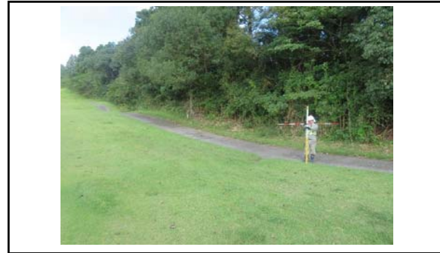
写真2 盛土頭部付近の状況(変状なし)
