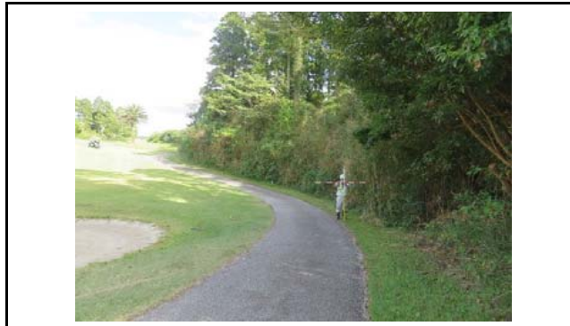
写真5 盛土側方境界部の状況(変状なし)
