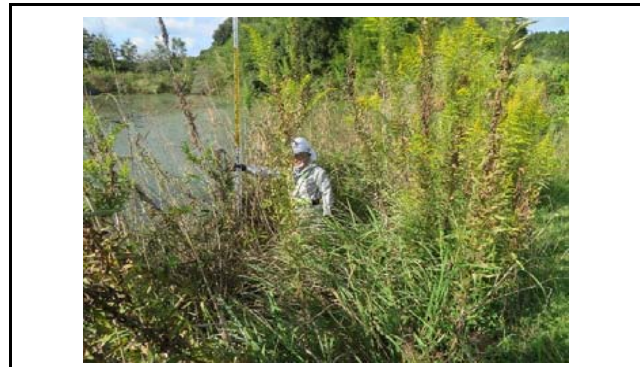
写真9 盛土のり面の状況(変状なし)
