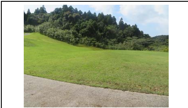
写真11 盛土内の全景(変状なし)
