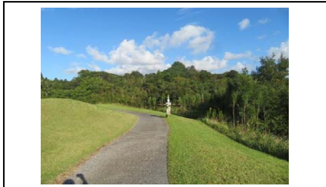
写真5 末端盛土のり面の上部(変状なし)
