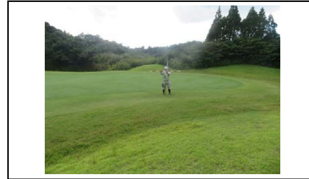
写真3 盛土側方境界部の状況(変状なし)
