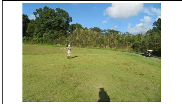
写真1 盛土頭部の状況(変状なし)
