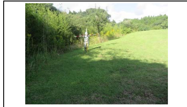
写真6 末端盛土のり面上端部(変状なし)
