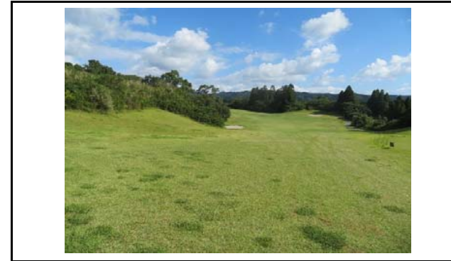
写真3 盛土側方境界部の状況(変状なし)
