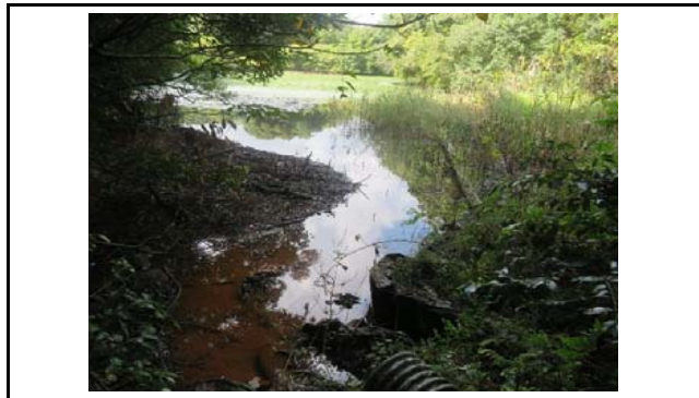
写真9 盛土末端部下方の状況(ため池)
