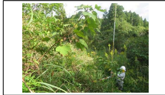
写真4 盛土のり面の状況(変状なし)
