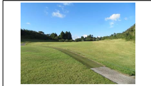
写真4 盛土内の状況(変状なし)
