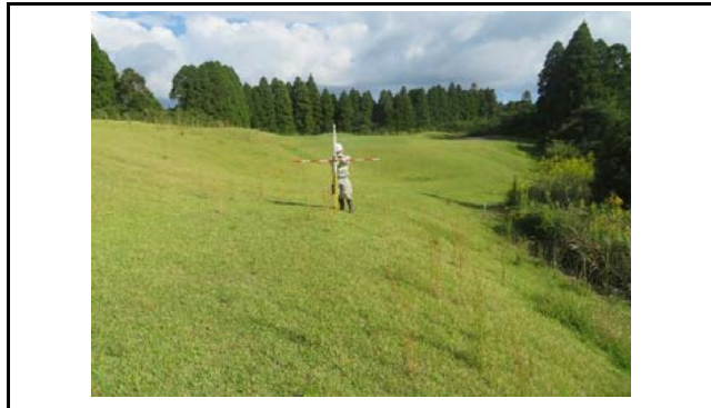
写真5 末端盛土のり面の上部(変状なし)
