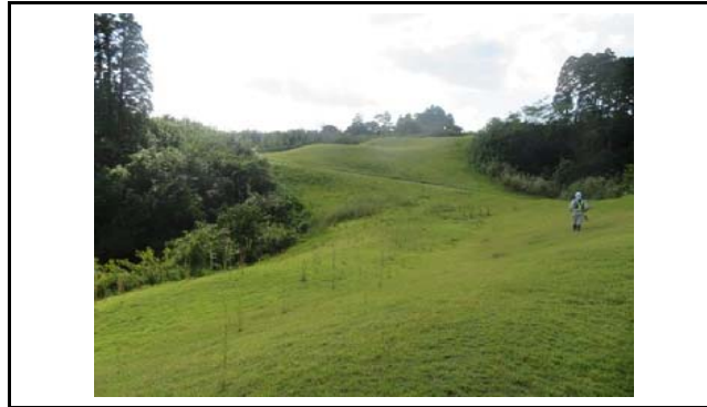
写真2 盛土内及び盛土側方境界部の状況(変状なし)
