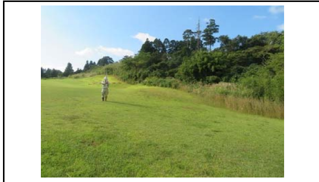
写真1 盛土頭部の状況(変状なし)
