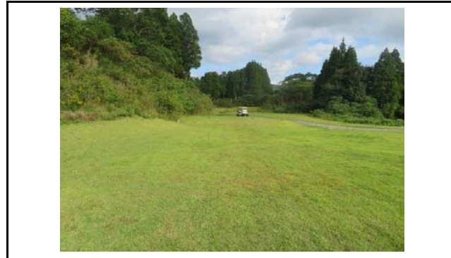
写真3 盛土側方境界部の状況(変状なし)
