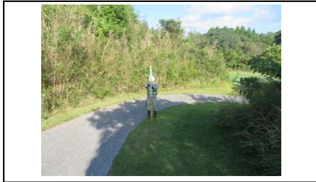
写真1 盛土頭部の状況(変状なし)
