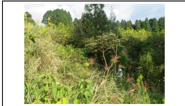
写真6 盛土のり面の状況(変状なし)
