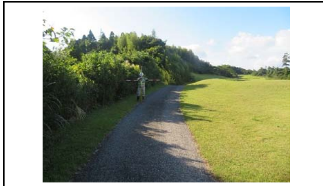
写真5 末端盛土のり面の上部(変状なし)
