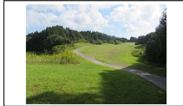
写真3 盛土内の全景(変状なし)
