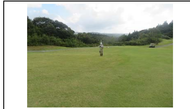
写真6 盛土内の状況(変状なし)
