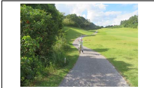
写真5 末端盛土のり面の上部(変状なし)
