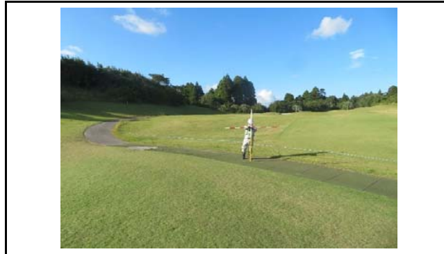
写真2 盛土側方境界部の状況(変状なし)
