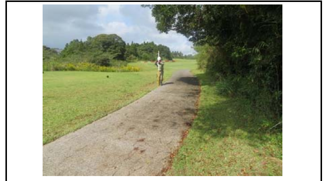
写真4 盛土側方境界部の状況(変状なし)
