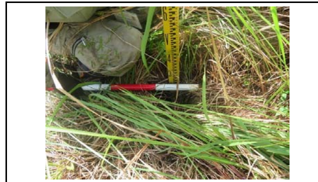
写真10 盛土のり面小段の排水施設の状況(変状なし)
