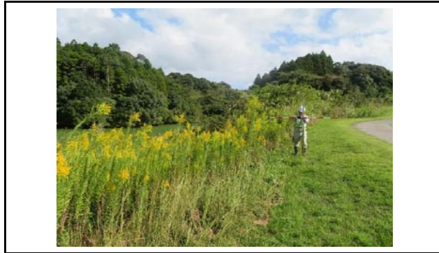
写真1 盛土頭部付近の状況(変状なし)
