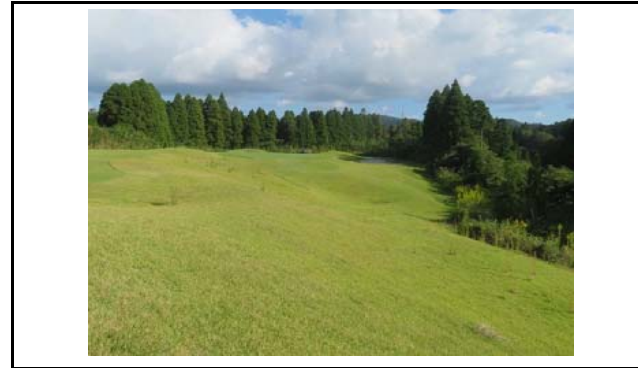
写真4 盛土内の全景(変状なし)
