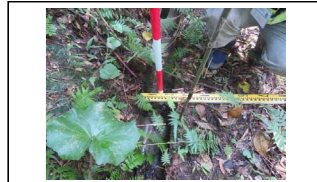
写真7 盛土のり面小段の排水施設の状況(変状なし)
