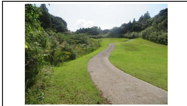
写真10 盛土内の全景(変状なし)
