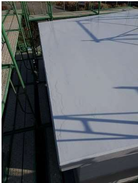
写真6 ポンプ室屋根防水
