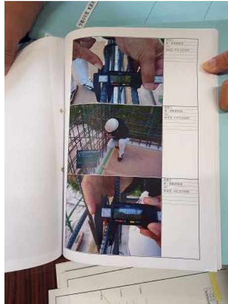
写真2 監督員による鉄筋検査
