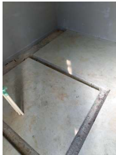
写真7 ポンプ室内床
