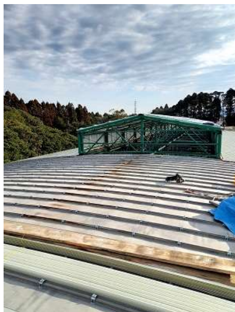
写真11 屋根上の状況
