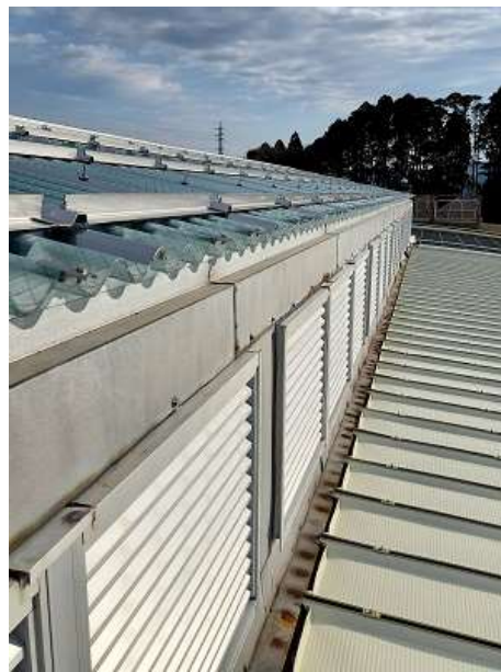
写真 14 トップライト部屋根及び壁下部
