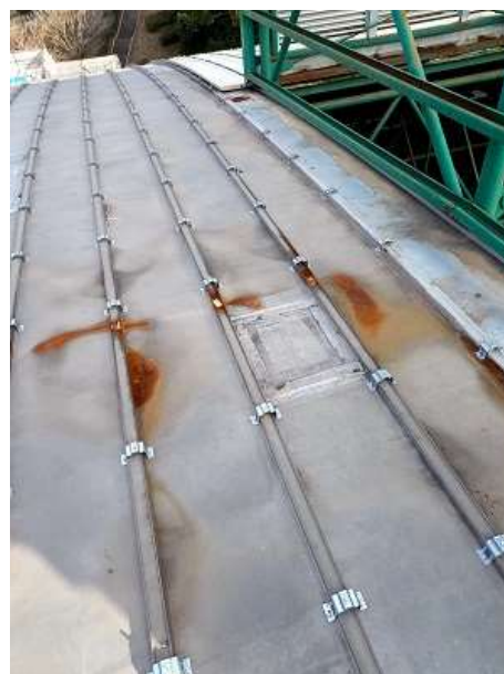
写真12 屋根の現況及び瓦棒下地
