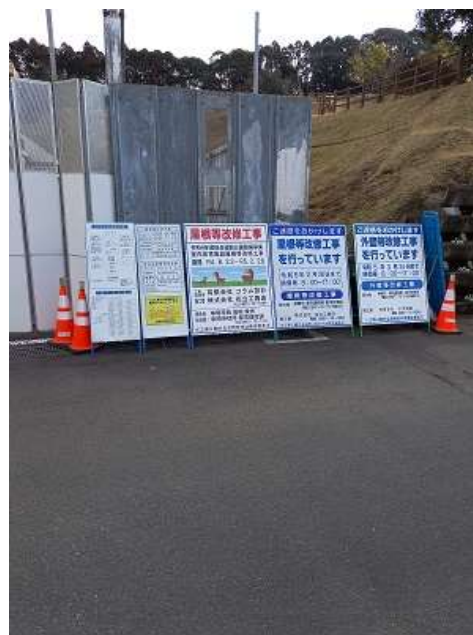
写真10 正面ゲート及び工事看板
