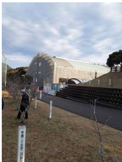
写真9 南西方向から全景
