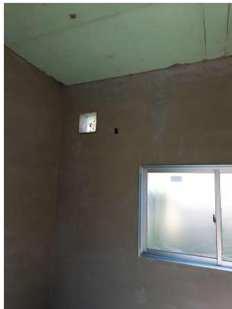
写真8 ポンプ室天井及び壁
