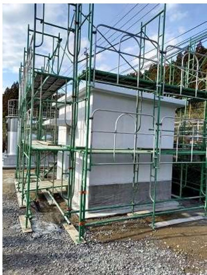
写真3 北方向より全景
