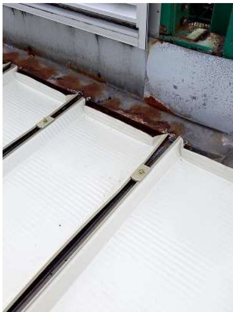
写真 13 屋根材水上部曲げ上げ
