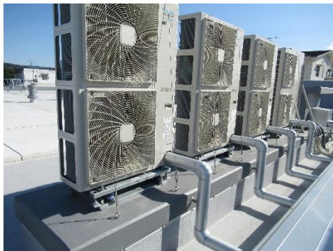
写真7 空調室外機転倒防止
