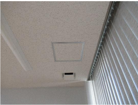
写真3 天井点検口(本部事務室)
