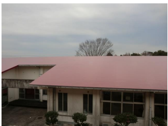
北面屋根の状況
