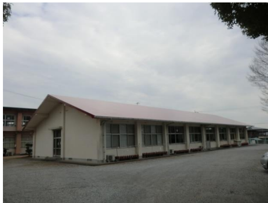
南面屋根の状況
