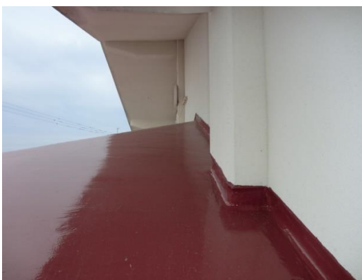
玄関屋根のウレタン塗膜防水状況
