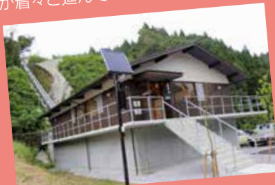
完成した市ノ瀬小水力発電所
