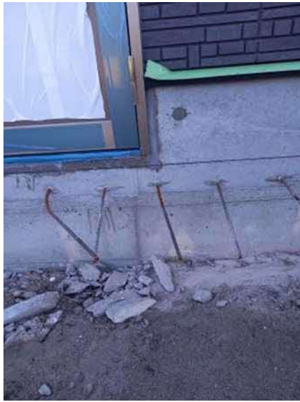
写真4 入口ドア廻り腰壁
