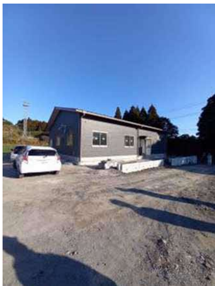
写真2 南西方向より全景
