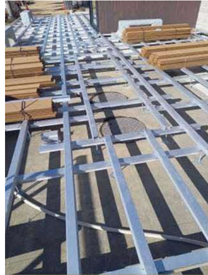
写真10 マンホール廻り床下地
