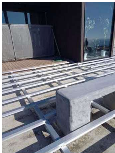
写真12 コンクリートベンチ取り付け
