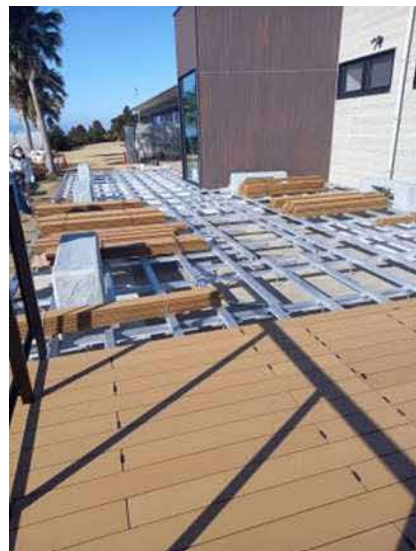
写真8 東方向より人工木デッキ工事中
