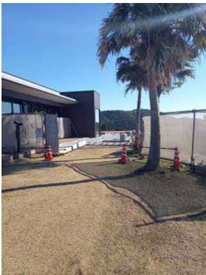
写真7 南西方向から観光交流館既存取り合い
