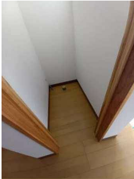
写真6 内部トイレ床
