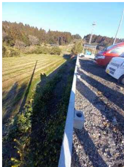
写真3 敷地西面L型擁壁
