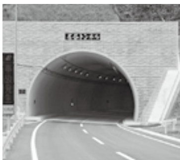
昨年12月に開通した名谷トンネル
