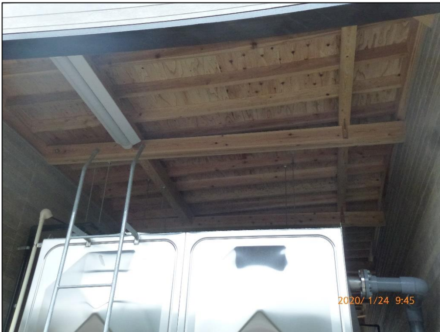
軸組構造（梁、母屋、垂木） 下は原水タンク 施工は丁寧であり、所定の金物で正しく固定されている
