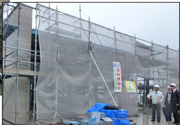
南側壁面（複層ガラス）、足場設置状況 足場には、2段手摺や幅木、転落防止ネット等が正しく設置されている
