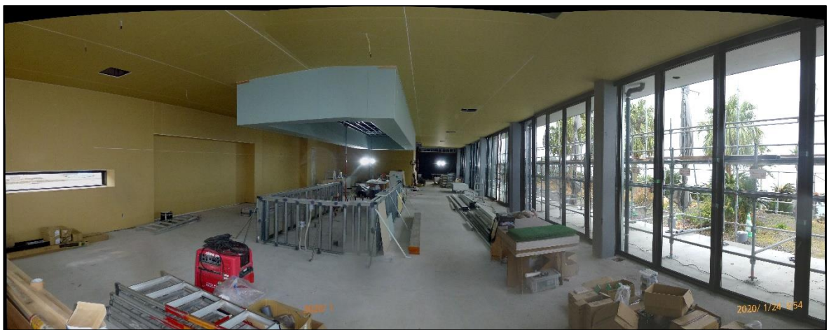
内部の状況（西側より東側を望む）中央はオープンキッチンスペース 床面は精度よく仕上げられている
