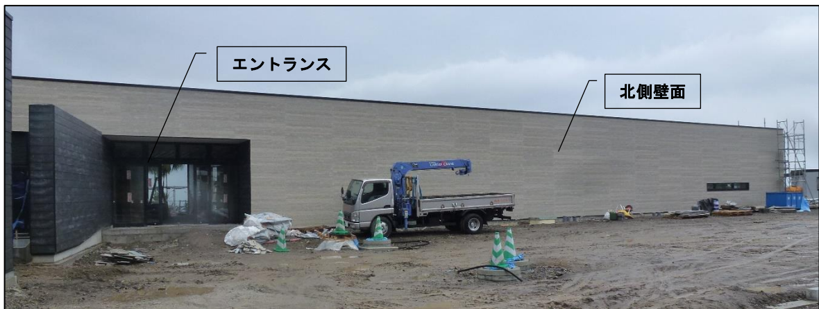
北側壁面～芝生広場～駐車場エリア 外壁面は丁寧に仕上げられている 舗装や広場は未施工であるが、縁石や側溝は精度よく設置されている
