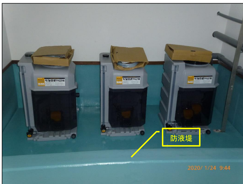
滅菌装置設置状況（手前は防液堤） 万一の薬剤流出に備え、防液堤（H300）を設置 塗装はエポキシ樹脂系を採用
