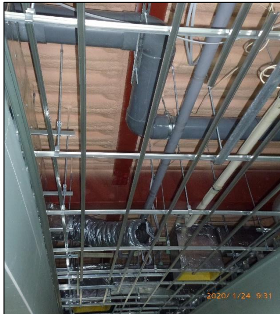
天井裏の状況 塩害に配慮し、塩化ビニル製ダクトを採用
